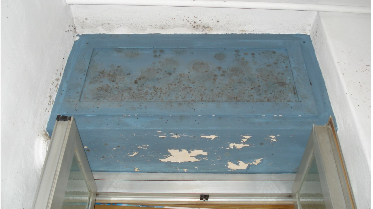
Foto 17: vista serramento del bagno
