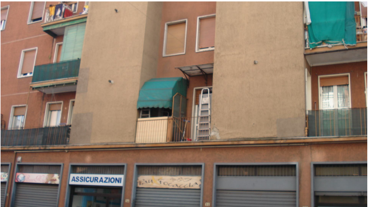
Foto 4: vista esterna dell'appartamento, lato strada
