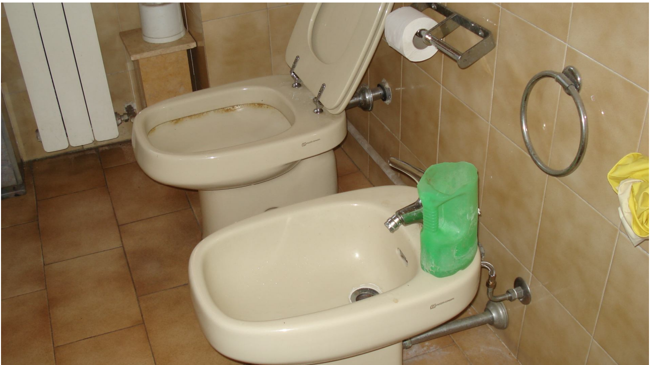
Foto 18: dettaglio serramenti bagno
