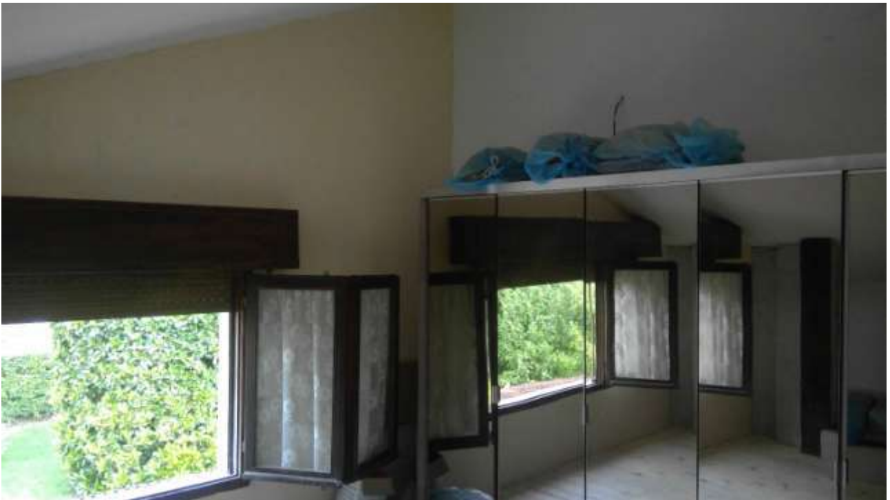
Foto n. 24 – Comune di San Martino al Tagliamento (PN), Lotto 1 – Foglio 5, mappale 495 – Veduta di porzione della soffitta in corrispondenza della parte non accatastata.
