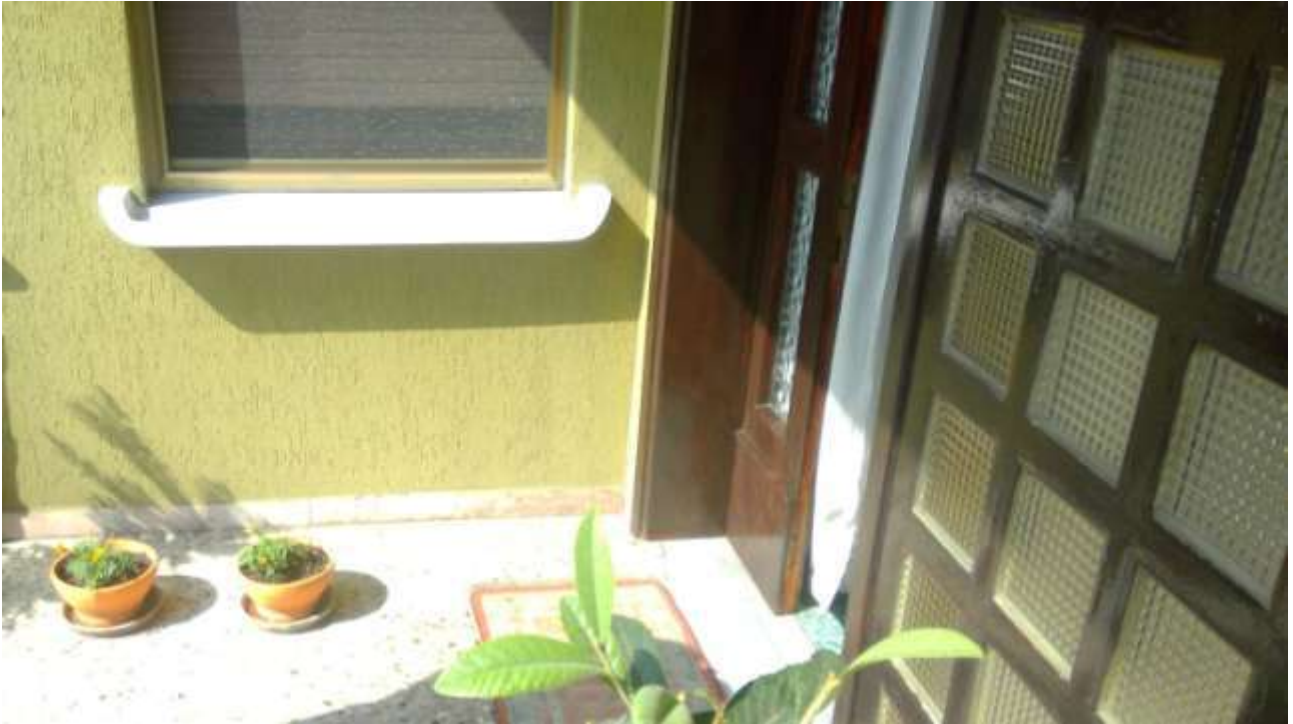
Foto n. 3 – Comune di San Martino al Tagliamento (PN), Lotto 1 – Foglio 5, particella 495 – particolare del portoncino d'ingresso principale.
