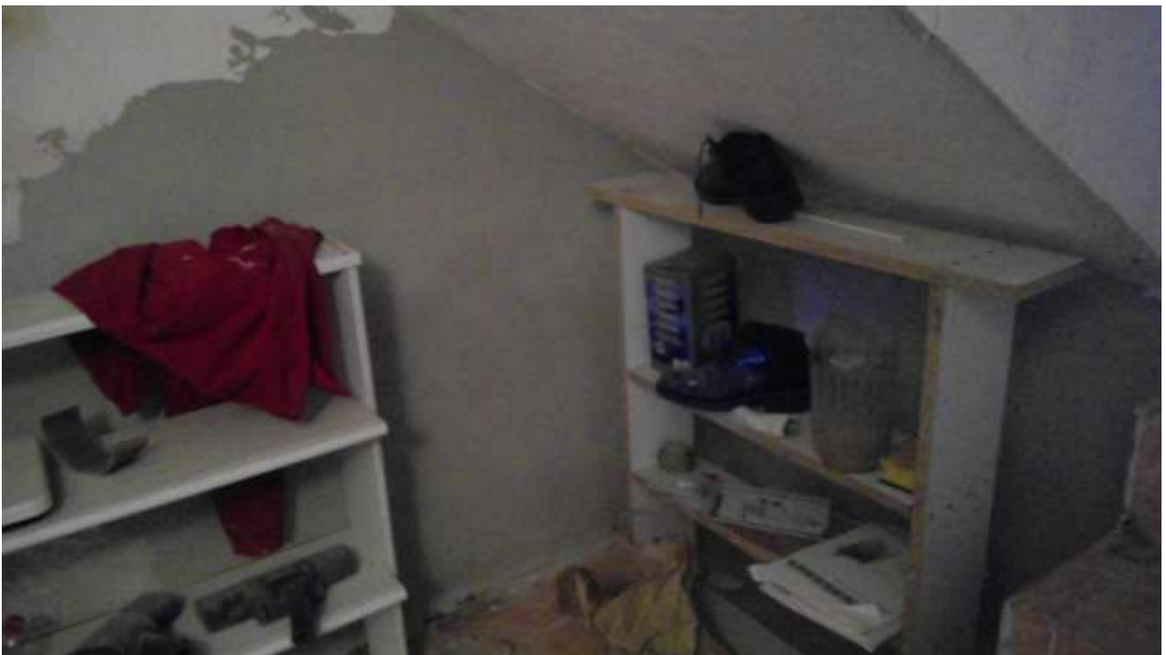
Foto n. 10 – Comune di San Martino al Tagliamento (PN), Lotto 2 – Foglio 10, particella 5 – Particolare del vano accessorio posto al di sotto delle scale di accesso al primo piano.
