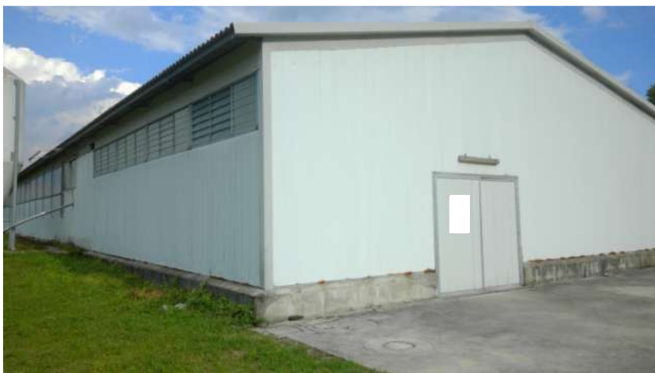
Foto n. 2 – Comune di San Martino al Tagliamento (PN), Lotto 4 - Foglio 11, particella 375 - Veduta esterna del capannone pignorato, con accesso da via delle Pozze.
