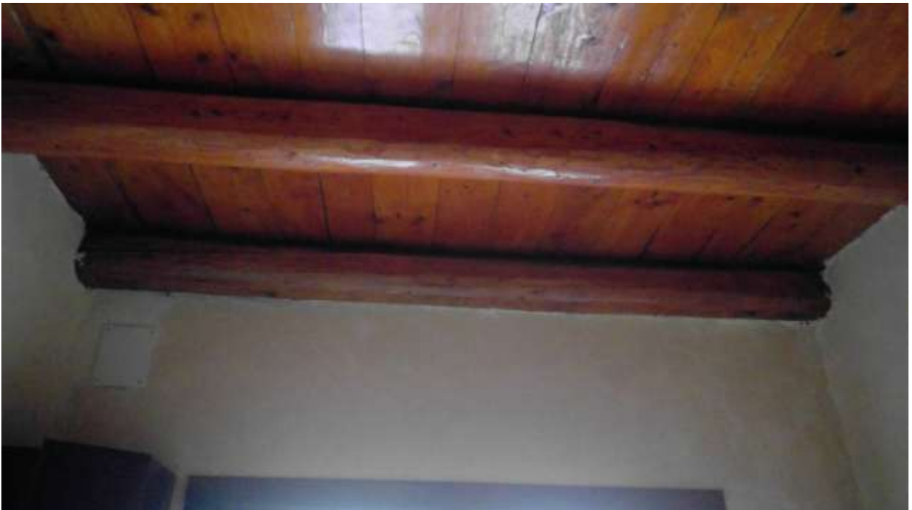
Foto n. 4 – Comune di San Martino al Tagliamento (PN), Lotto 2 – Foglio 10, particella 5 – particolare del solaio in legno con travi e tavolato a vista.
