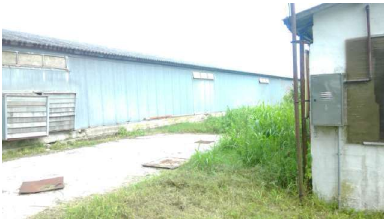
Foto n. 16 – Comune di San Martino al Tagliamento (PN), Lotto 3 - Foglio 11, particella 86 – A sinistra il capannone centrale in struttura metallica, a destra parte di quello posto ad ovest; foto scattata da posizione nord.
