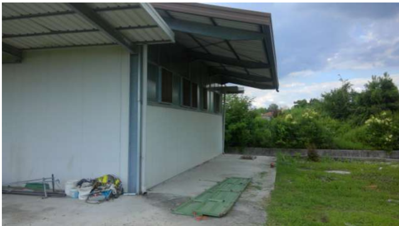
Foto n. 3 – Comune di San Martino al Tagliamento (PN), Lotto 3 - Foglio 11, particella 90 - Veduta parziale da posizione sud, del capannone di cui alla foto precedente.
