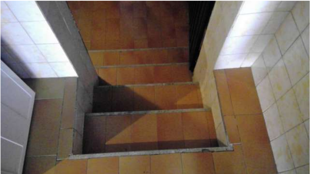
Foto n. 20 – Comune di San Martino al Tagliamento (PN), Lotto 1 – Foglio 5, mappale 495 sub 1 – Piano scantinato – particolare delle scale che portano dalla lavanderia al corridoio e alla cantina/ripostiglio.
