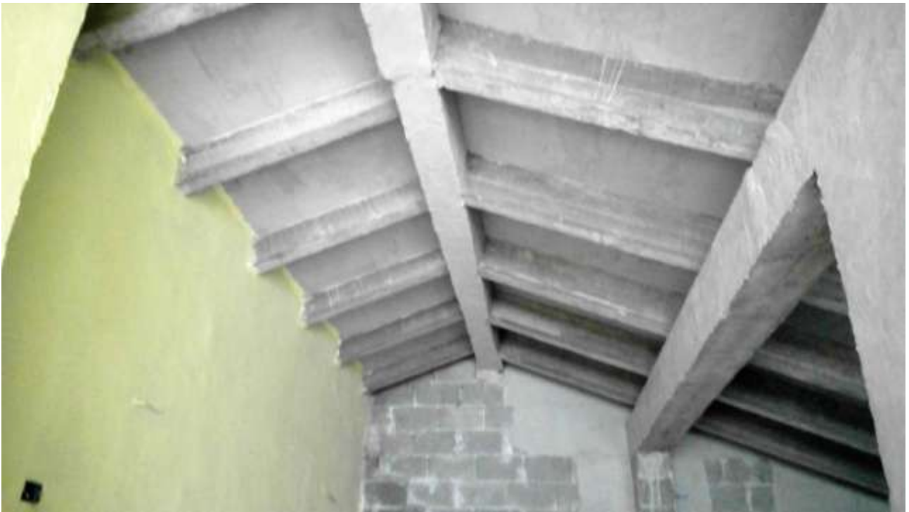
Foto n. 25 - Comune di San Martino al Tagliamento (PN), Lotto 1 - Foglio 5, mappale 495 sub 1 - Particolare della struttura di sostegno del tetto, realizzata in travi di cemento armato.
