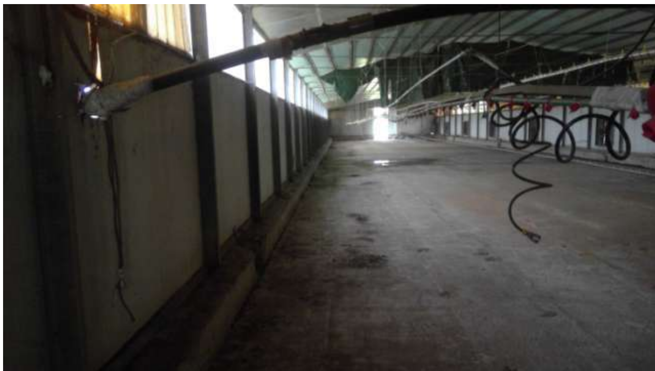
Foto n. 5 – Comune di San Martino al Tagliamento (PN), Lotto 4 - Foglio 11, particella 375 - Veduta interna della zona di allevamento delle galline ovaiole all'interno del capannone pignorato.
