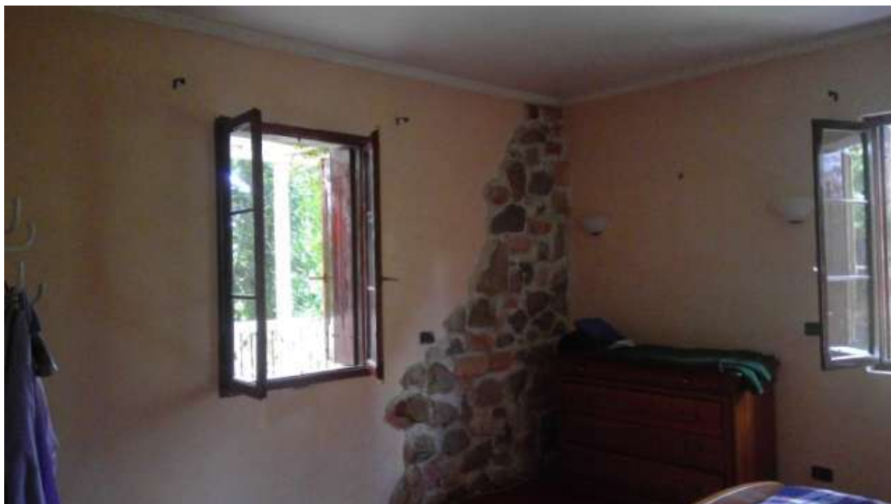
Foto n. 15 – Comune di San Martino al Tagliamento (PN), Lotto 2 – Foglio 10, particella 5 – Primo piano – Veduta interna di porzione della prima camera, indicata con il n. 5 nella planimetria catastale.
