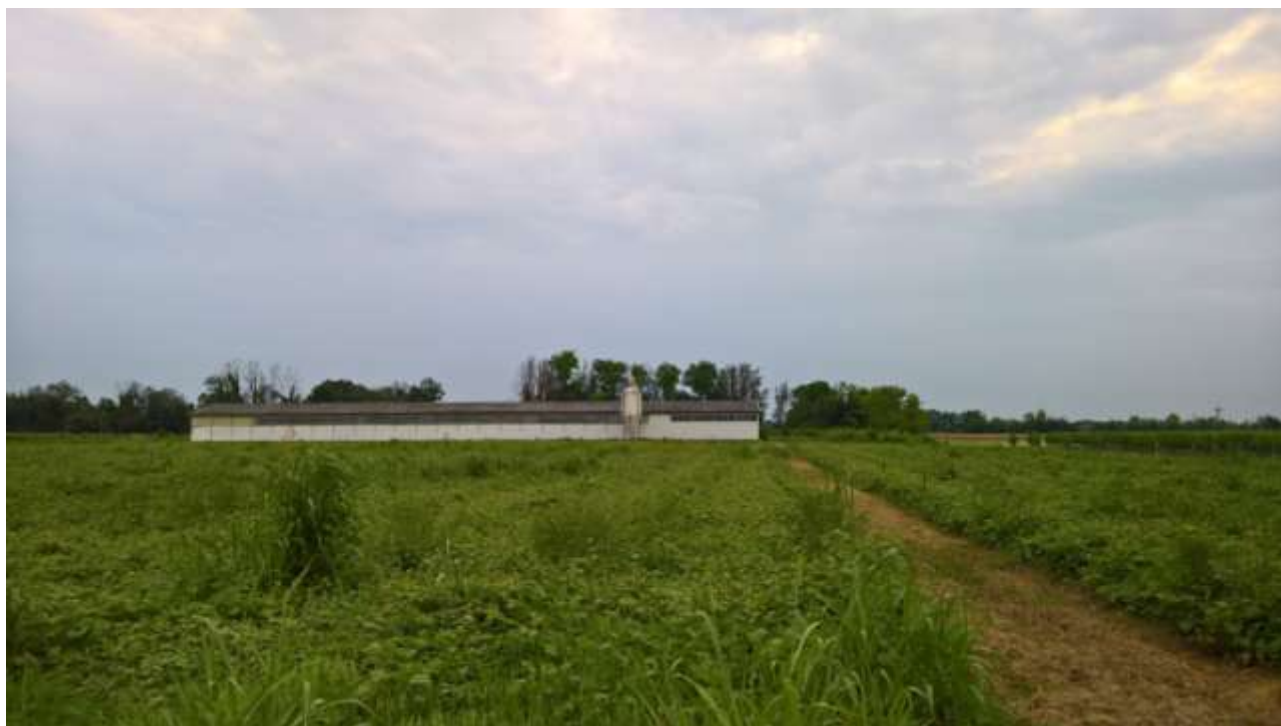
Foto n. 1 – Comune di San Martino al Tagliamento (PN), Lotto 4 - Foglio 11 - Veduta generale del capannone pignorato, foto scattata da posizione nord.
