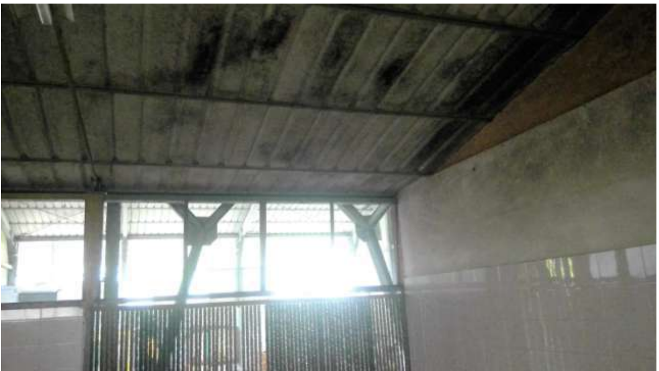
Foto n. 10 – Comune di San Martino al Tagliamento (PN), Lotto 3 - Foglio 11, particella 86 - Particolare della zona di accesso al capannone di allevamento avicolo.
