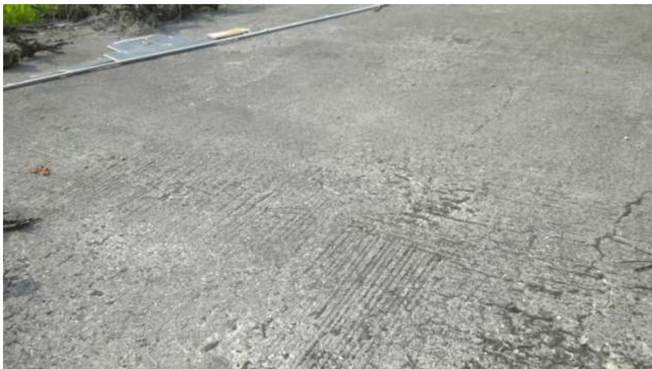
Foto n. 7 – Comune di San Martino al Tagliamento (PN), Lotto 4 - Foglio 11, particella 375 – Particolare della pavimentazione esterna della vasca interrata per liquami.
