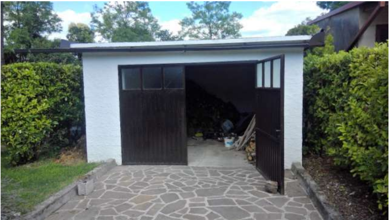
Foto n. 27 – Comune di San Martino al Tagliamento (PN), Lotto 1 – Foglio 5, particella 500 – veduta dell'autorimessa esterna che risulta autorizzata ma non accatastata.
