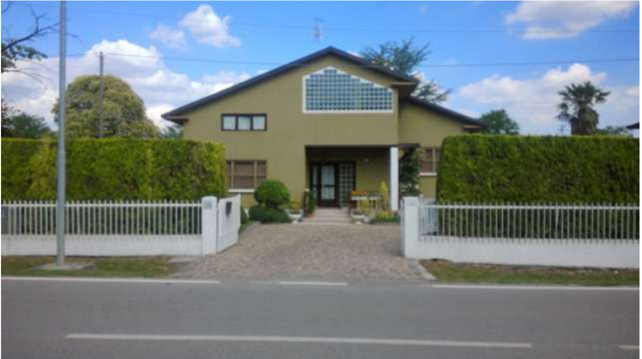
Foto n. 1 – Comune di San Martino al Tagliamento (PN), Lotto 1 – Foglio 5, particella 495 – Esterni – Veduta generale dell’immobile pignorato, con accesso dalla SP1 della Val d’Arzino (via Provinciale).
