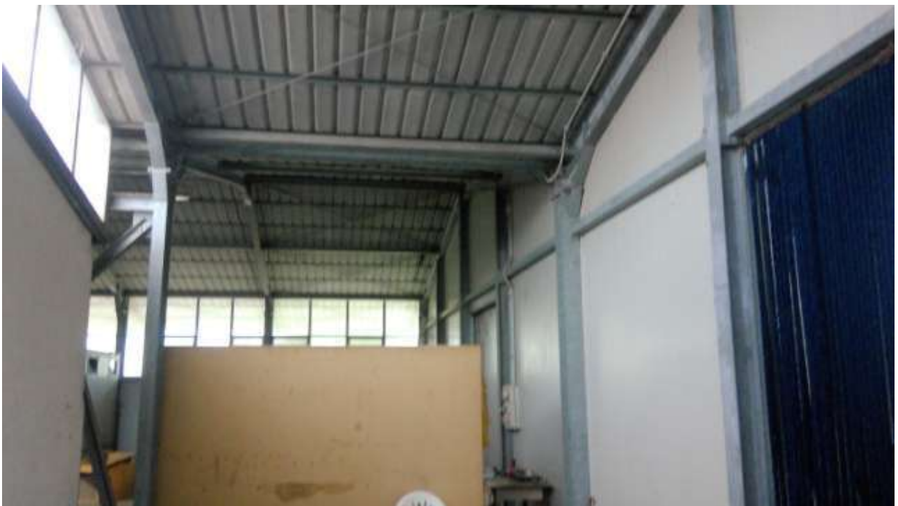
Foto n. 6 - Comune di San Martino al Tagliamento (PN), Lotto 3 - Foglio 11, particelle 86 e 90 - Veduta della zona adibita a selezione e confezionamento all'interno della porzione ampliata.
