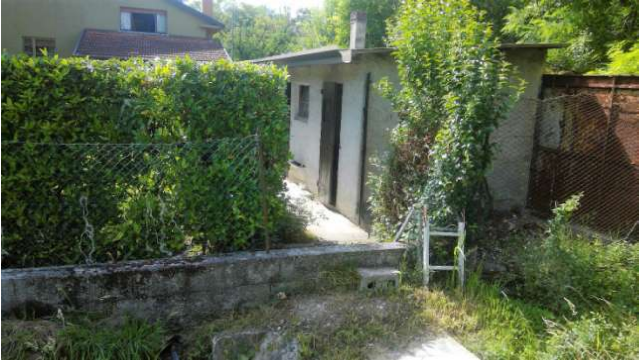
Foto n. 29 – Comune di San Martino al Tagliamento (PN), Lotto 1 – Foglio 5, particella 500 – veduta dello stesso fabbricato da posizione est, in prossimità del confine.
