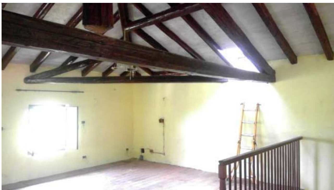
Foto n. 24 – Comune di San Martino al Tagliamento (PN), Lotto 2 – Foglio 10, particella 5 – Secondo piano – Particolare della struttura di sostegno del tetto, realizzata con capriate e travi in legno.
