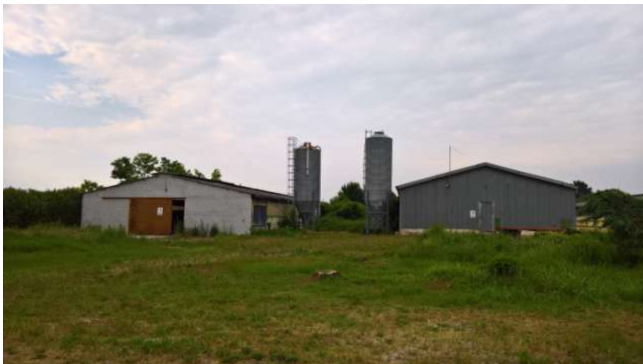
Foto n. 1 – Comune di San Martino al Tagliamento (PN), Lotto 3 - Foglio 11, particelle 86 e 299 - Veduta generale dei due capannoni pignorati, con accesso da via delle Pozze.
