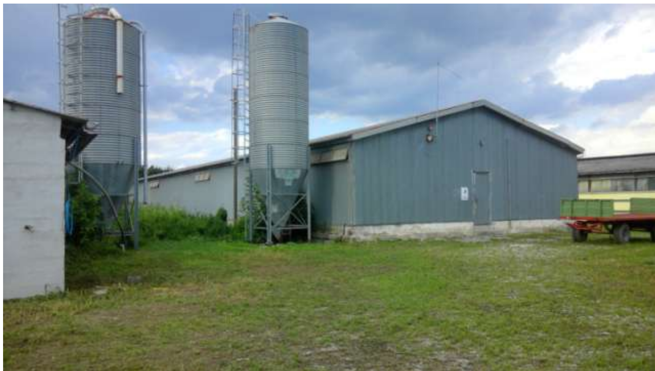
Foto n. 13 – Comune di San Martino al Tagliamento (PN), Lotto 3 - Foglio 11, particella 86 - Veduta esterna del capannone centrale, realizzato in struttura metallica.
