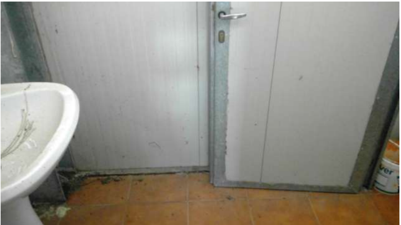
Foto n. 8 – Comune di San Martino al Tagliamento (PN), Lotto 3 - Foglio 11, particella 90 - Vista interna del vano accessorio uso servizi igienici.
