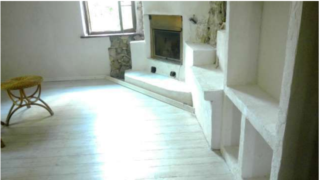
Foto n. 6 – Comune di San Martino al Tagliamento (PN), Lotto 2 – Foglio 10, particella 5 – Piano terra – porzione del primo vano posto a sinistra rispetto all'ingresso, indicato con il n. 4 nella planimetria catastale.
