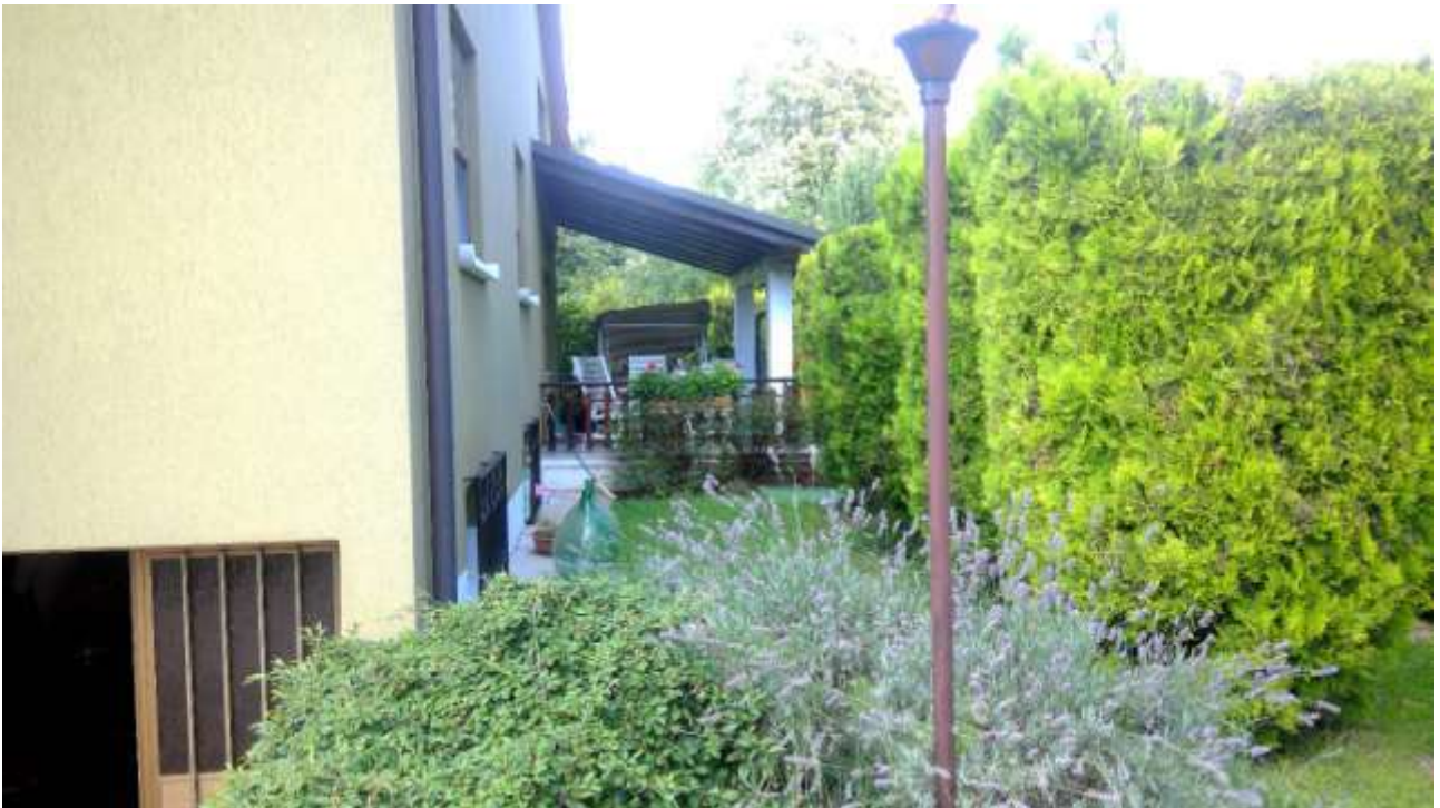
Foto n. 26 - Comune di San Martino al Tagliamento (PN), Lotto 1 - Foglio 5, particella 495 - Esterni - veduta di parte del giardino di pertinenza; sullo sfondo il piccolo portico collegato alla sala ricavata nel vano non accatastato.
