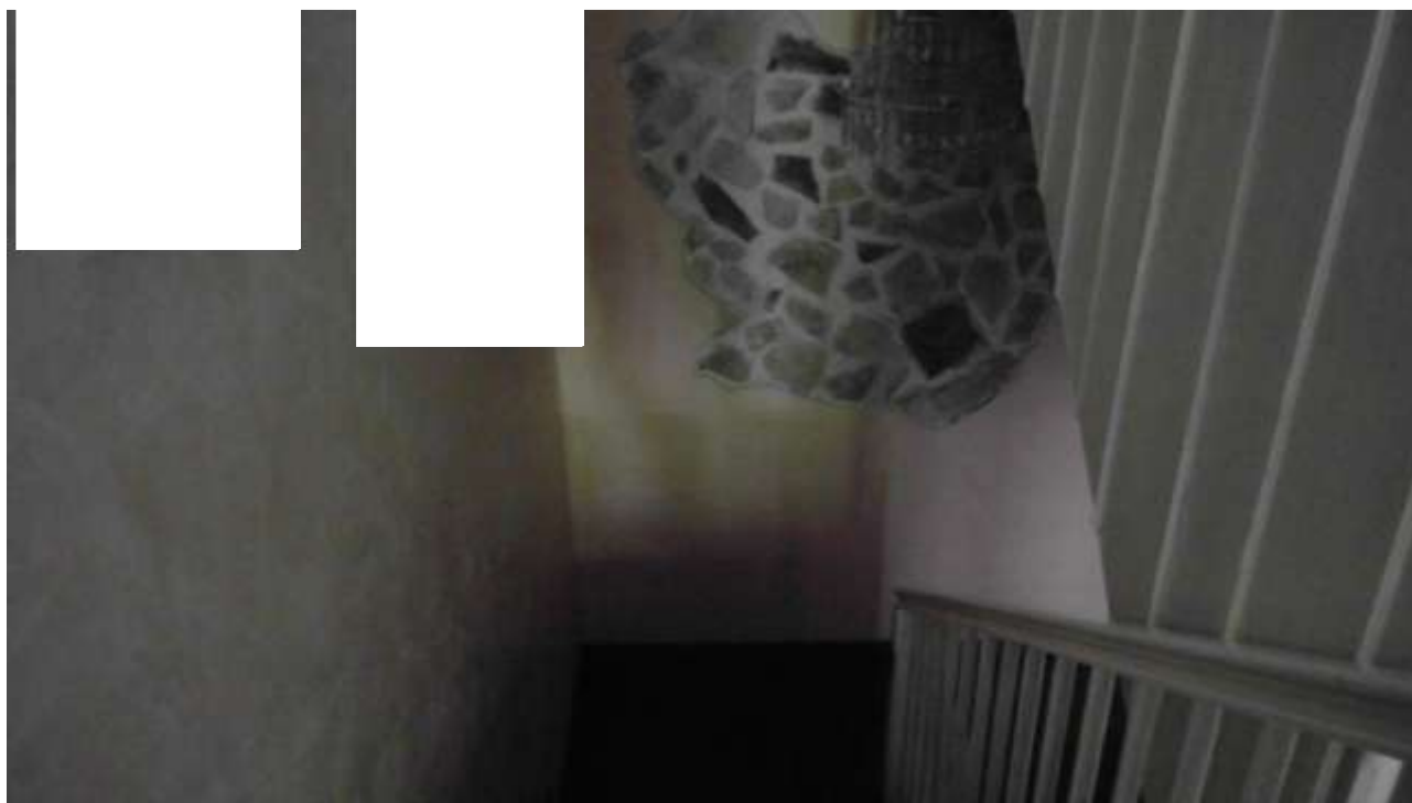
Foto n. 14 – Comune di San Martino al Tagliamento (PN), Lotto 2 – Foglio 10, particella 5 – Veduta, dal primo piano, del vano scale di accesso alle camere.
