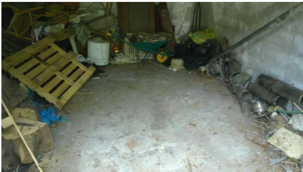
Foto n. 27 – Comune di San Martino al Tagliamento (PN), Lotto 2 – Foglio 10, particella 553 – Veduta interna del fabbricato uso autorimessa/deposito che non risulta accatastato.
