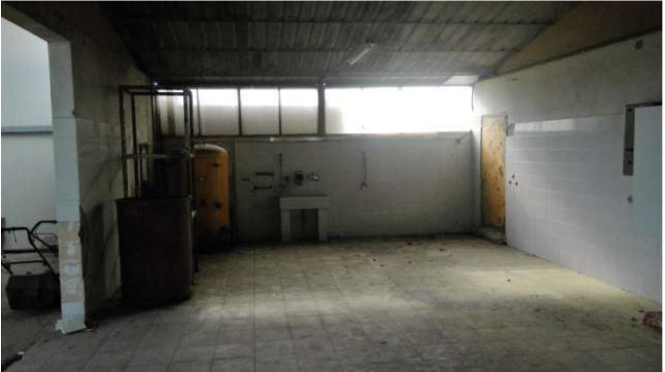
Foto n. 9 – Comune di San Martino al Tagliamento (PN), Lotto 3 - Foglio 11, particella 86 - Veduta della zona di selezionamento e vagliatura con lavabo e autoclave.
