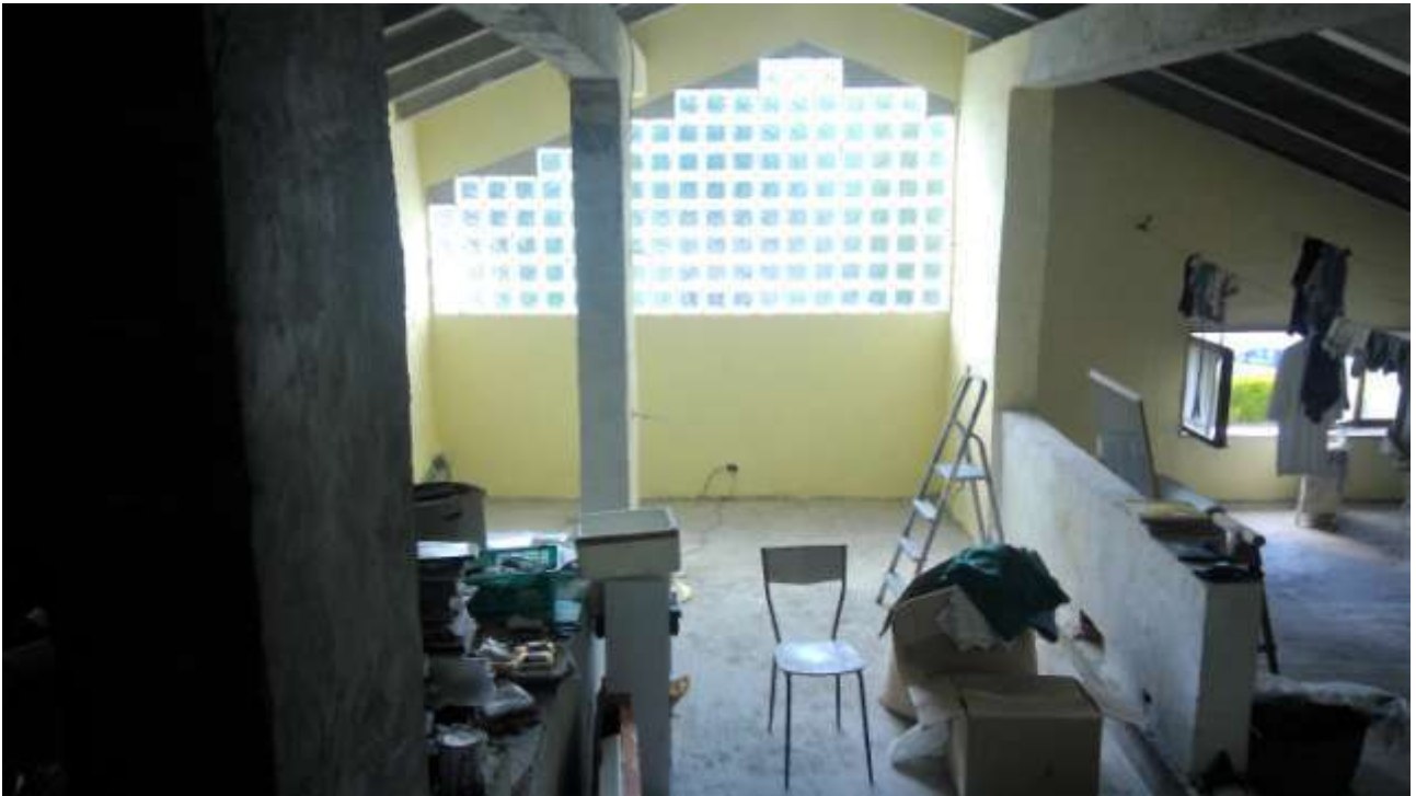
Foto n. 23 – Comune di San Martino al Tagliamento (PN), Lotto 1 – Foglio 5, mappale 495 sub 1 – Veduta di parte della soffitta posta al di sopra del piano rialzato dell'abitazione.
