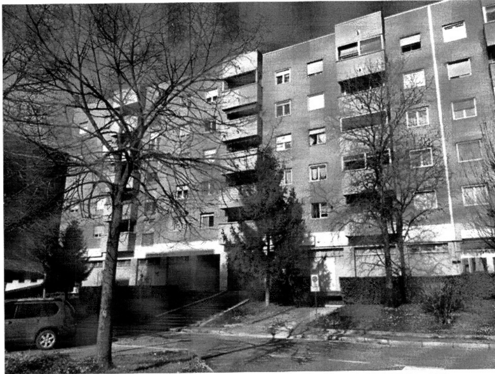
Facciata principale– Via Carlo Jannozzi n°10 – San Donato Milanese – (MI)
