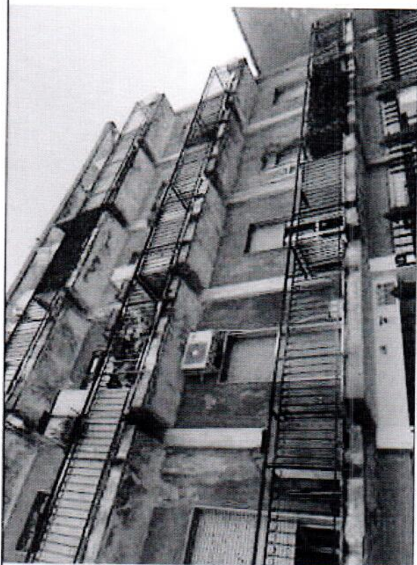
Stato u.i. fabbricato in facciata
