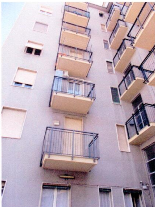
45. Facciata del cortile interno (dal quale si accede alle cantine)
