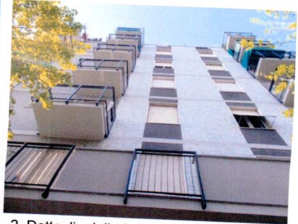
2. Dettaglio della facciata principale fronte strada (via Balducci)
