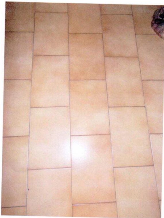
31. Dettaglio del pavimento del corridoio
