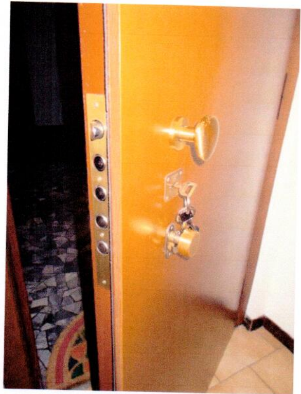
10. Dettaglio del portoncino di ingresso
