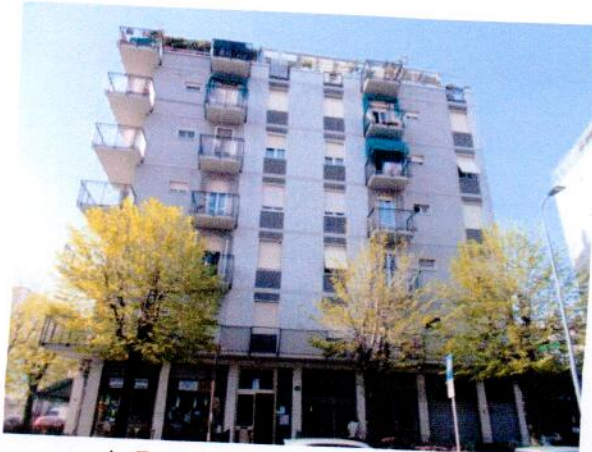
1. Panoramica del fabbricato
