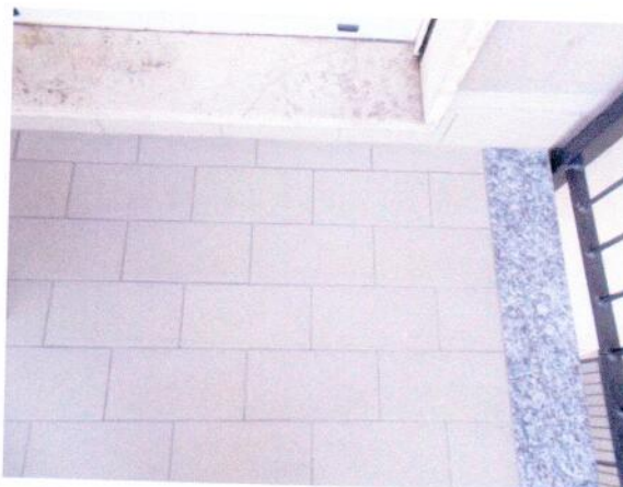
28. Dettaglio del pavimento del balcone
