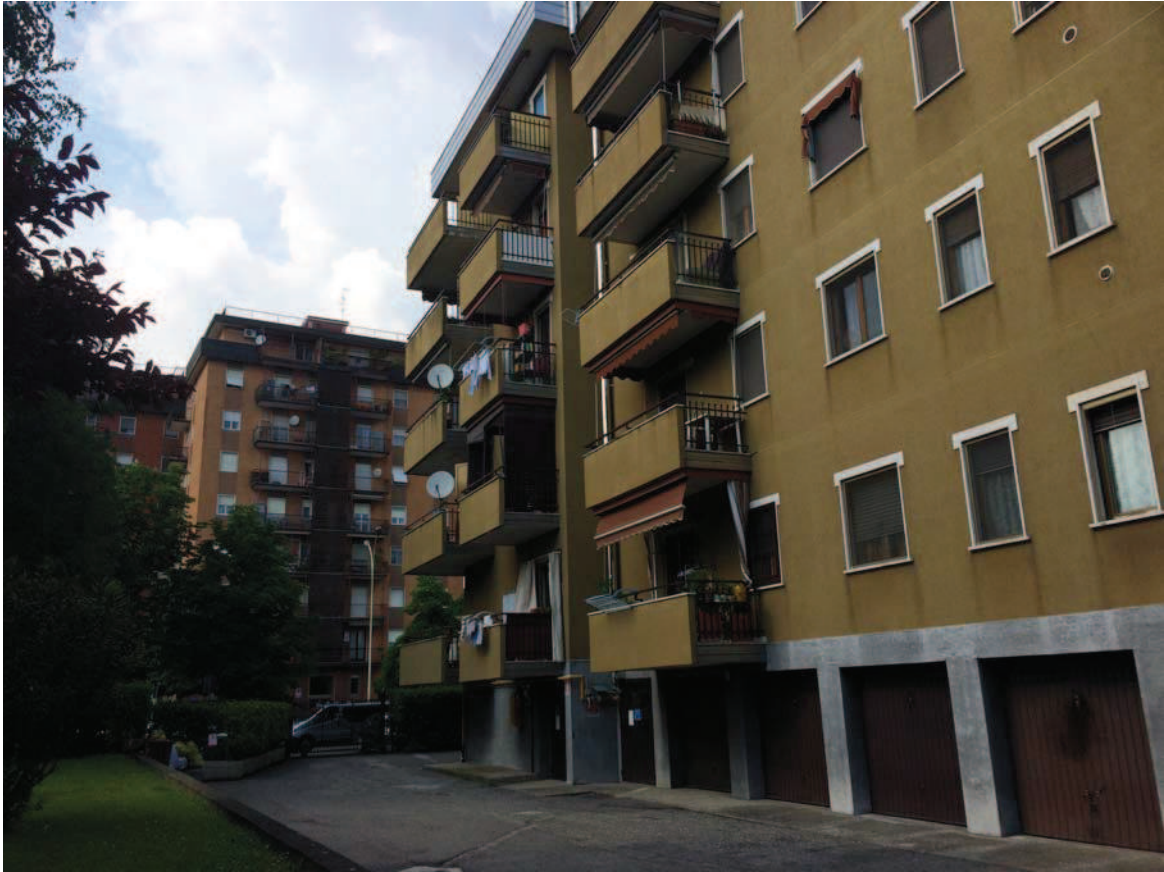
Foto 05 - Il fabbricato dal cortile interno comune
