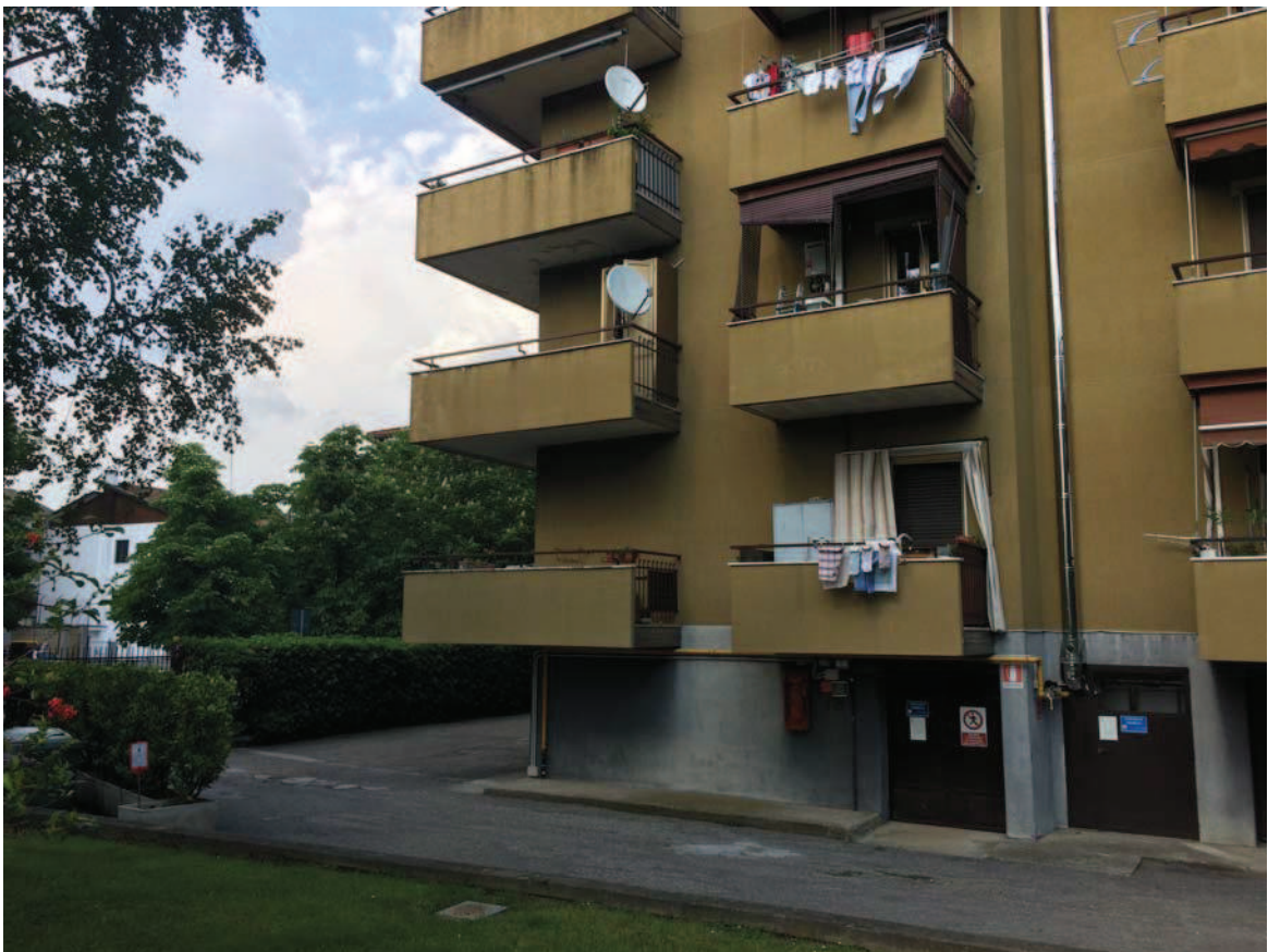
Foto 06 - L'unità al secondo piano dal cortile interno comune
