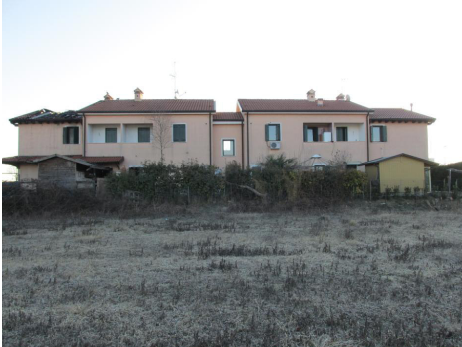
Fig.3: vista da ovest Condominio "Loncon 2"
