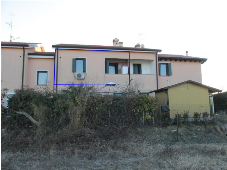
Fig.4: vista appartamento da ovest
