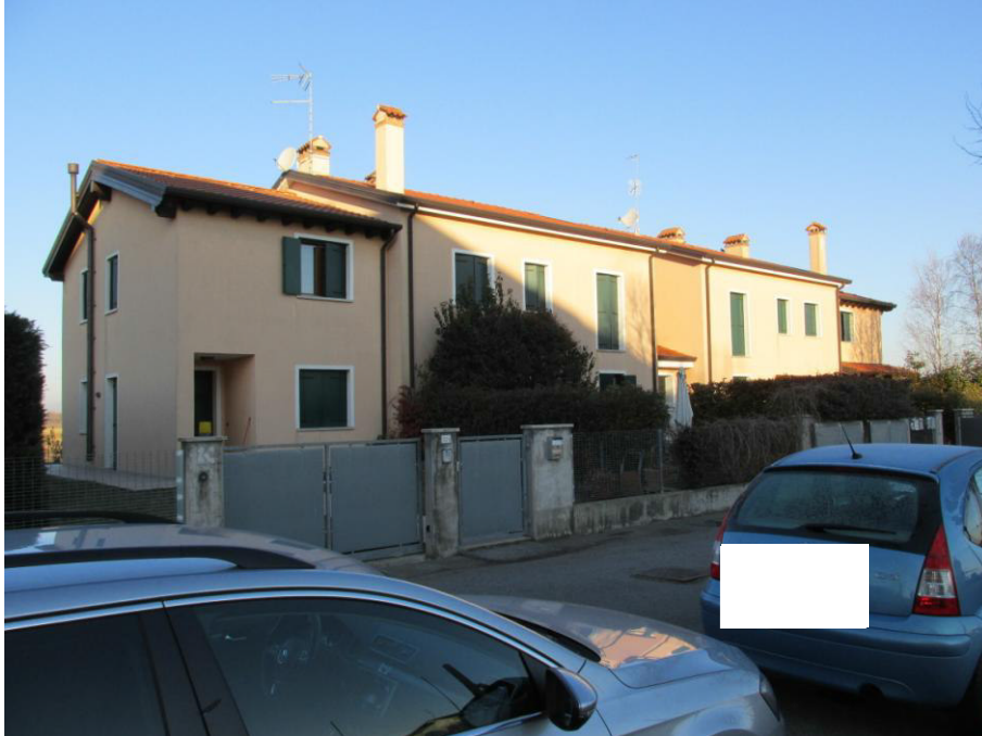
Fig.1: vista da sud - est Condominio "Loncon 2"
