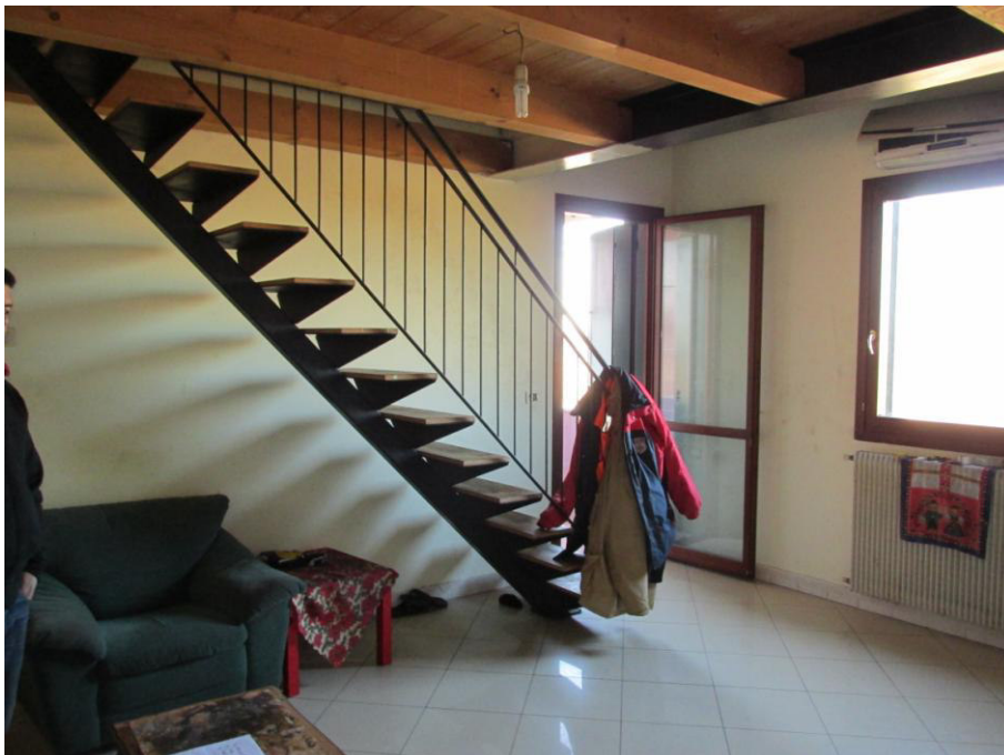
Fig.6: vista soggiorno con soppalco abusivo
