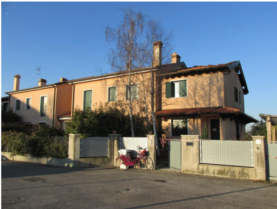
Fig.2: vista da nord - est Condominio "Loncon 2"
