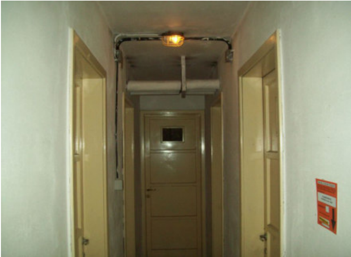
Foto 14: Corridoio di accesso alla cantina
