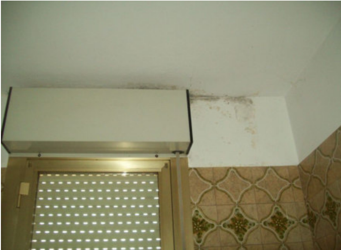
Foto 11: Parete Nord bagno
