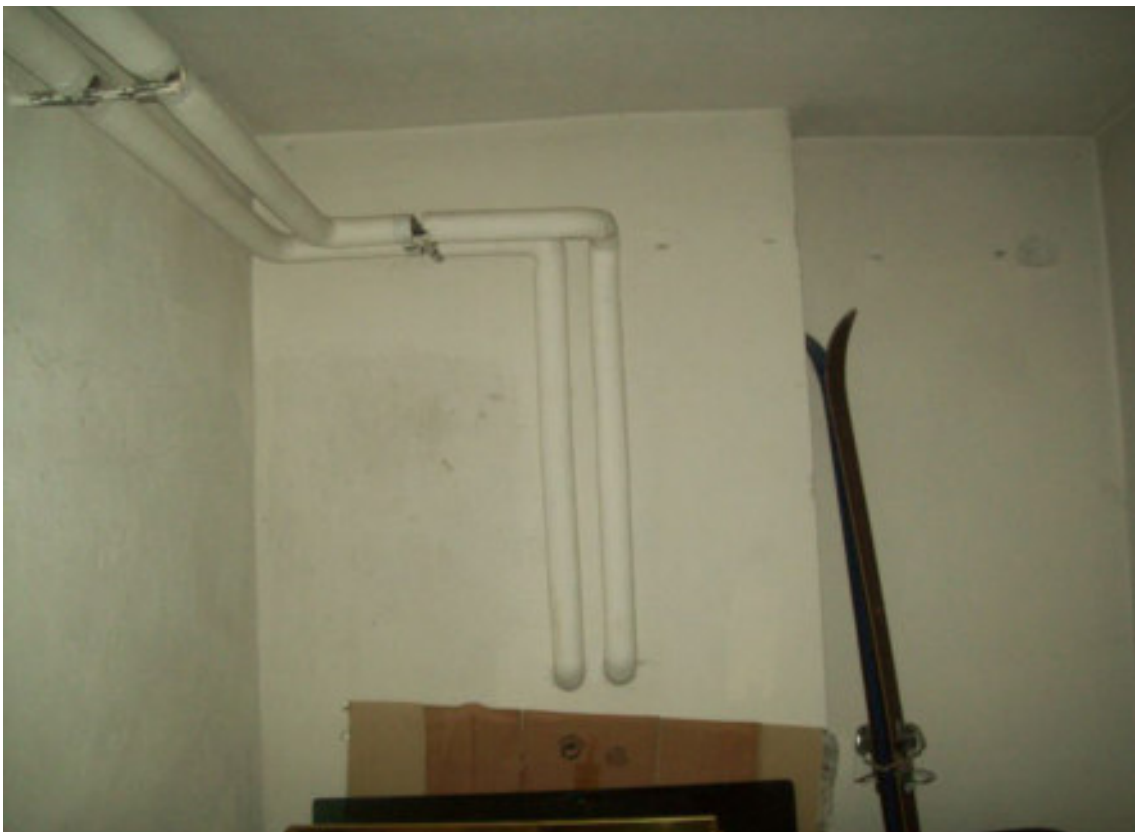
Foto 15: Parete Ovest cantina
