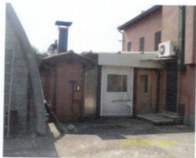
"Corpo A3"- Retrocucina
