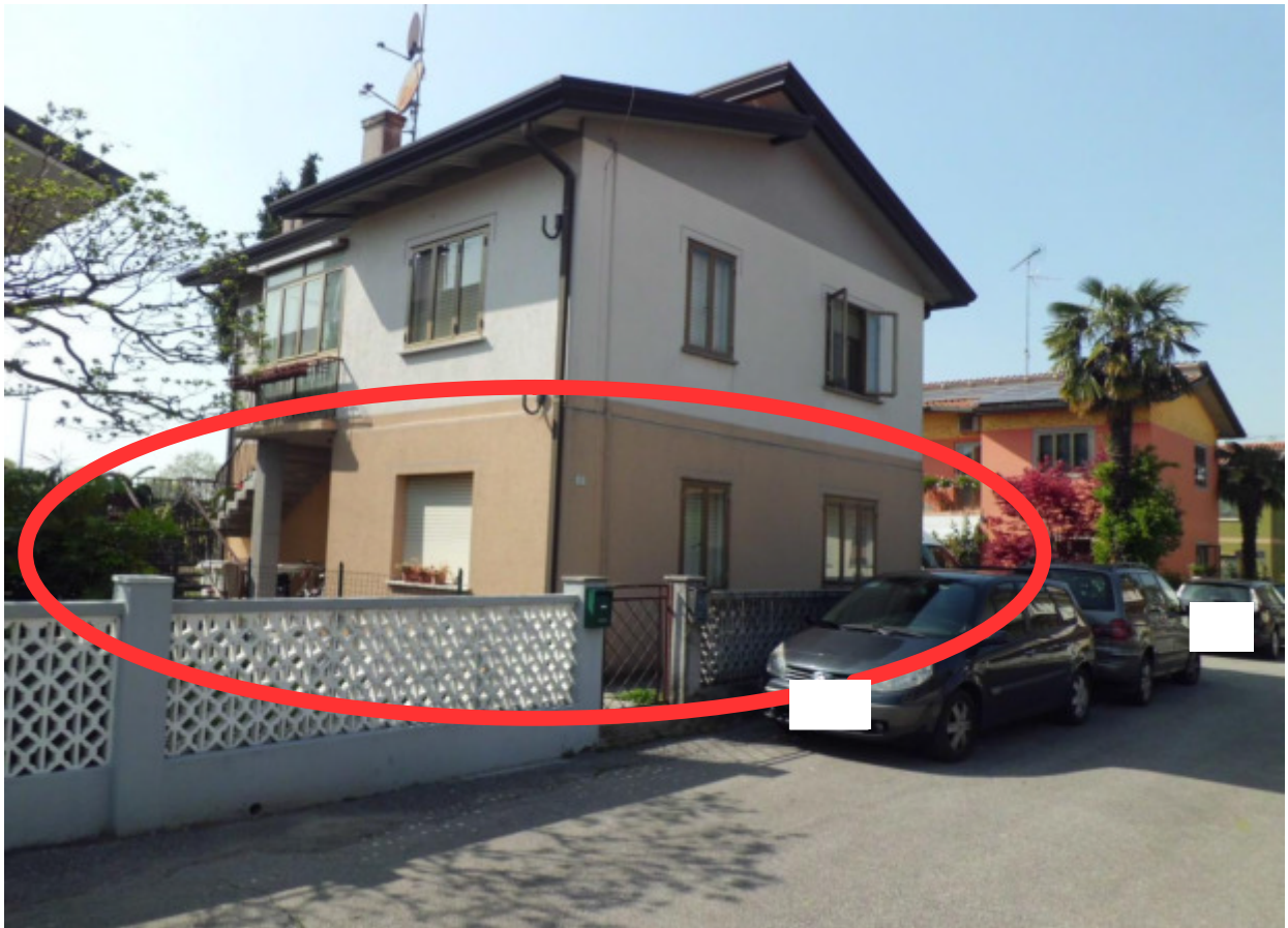
Foto n. 1 – 21.04.2015 – Lotto n. 1 - Comune di San Michele al Tagliamento, fg.24- Vista dell'abitazione pignorata - Fotografia scattata da Via Olivelli.
