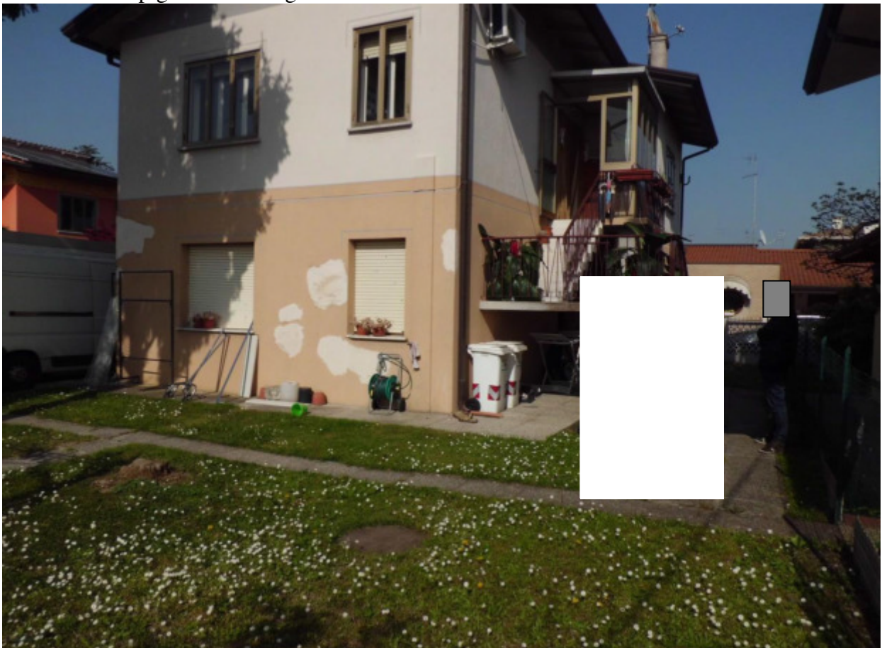
Foto n. 2 – 21.04.2015 – Lotto n. 1 - Comune di San Michele al Tagliamento, fg.24, part.269 - Vista dell'abitazione pignorata - Fotografia scattata dalla particella 892.
