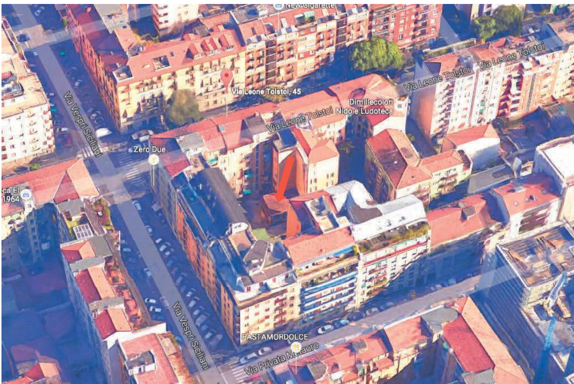
Vista assonometrica del fabbricato interno da Google Maps
