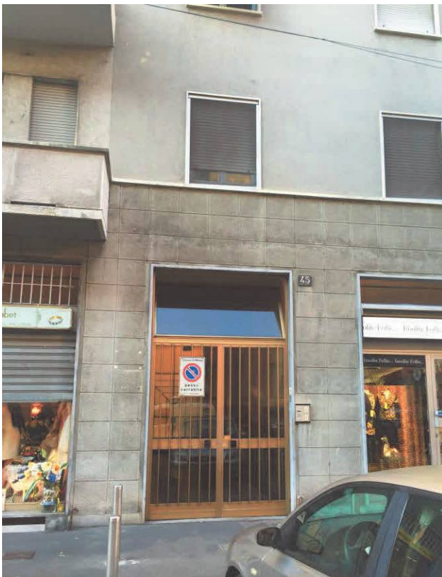
Vista portone ingresso al fabbricato
