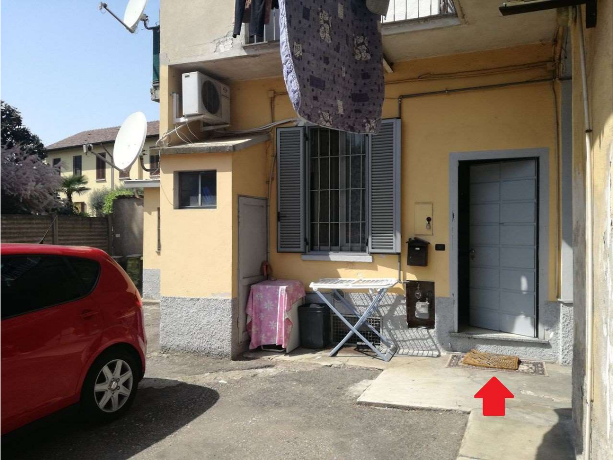
Vista dei locali da cortile interno
