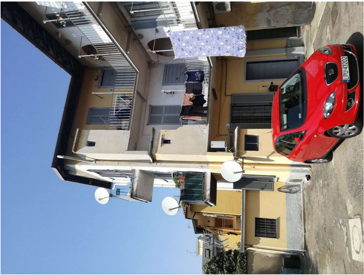
Vista dei locali da cortile interno
