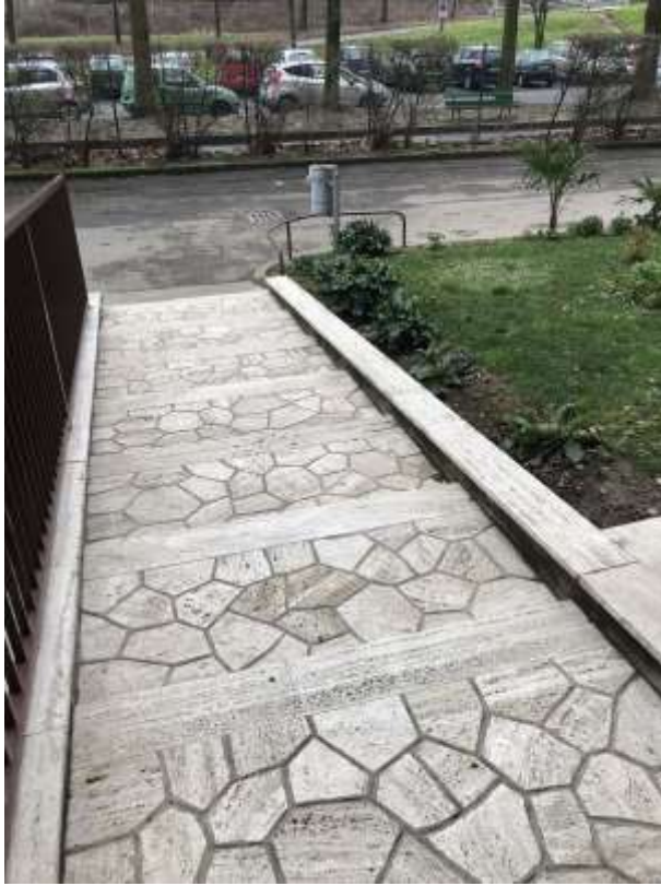
Foto 7. Vista della scalinata di accesso al fabbricato.
