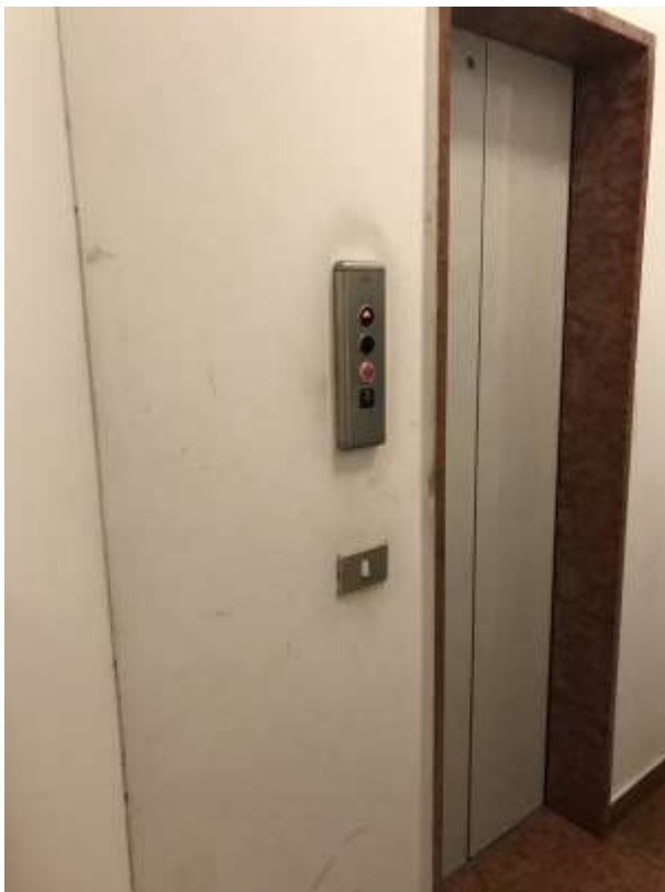
Foto 12. Vista della porta di accesso all'ascensore.
