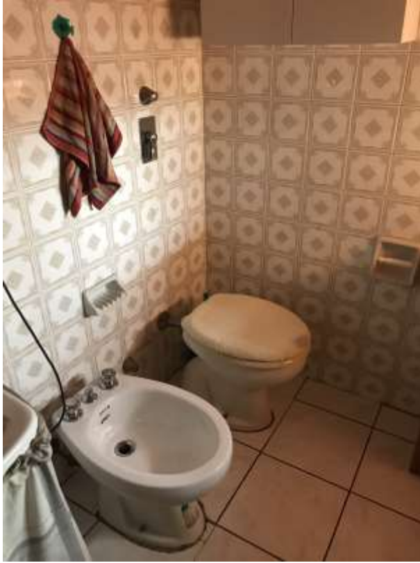
Foto 29. Vista del bagno, dettaglio dei sanitari.
