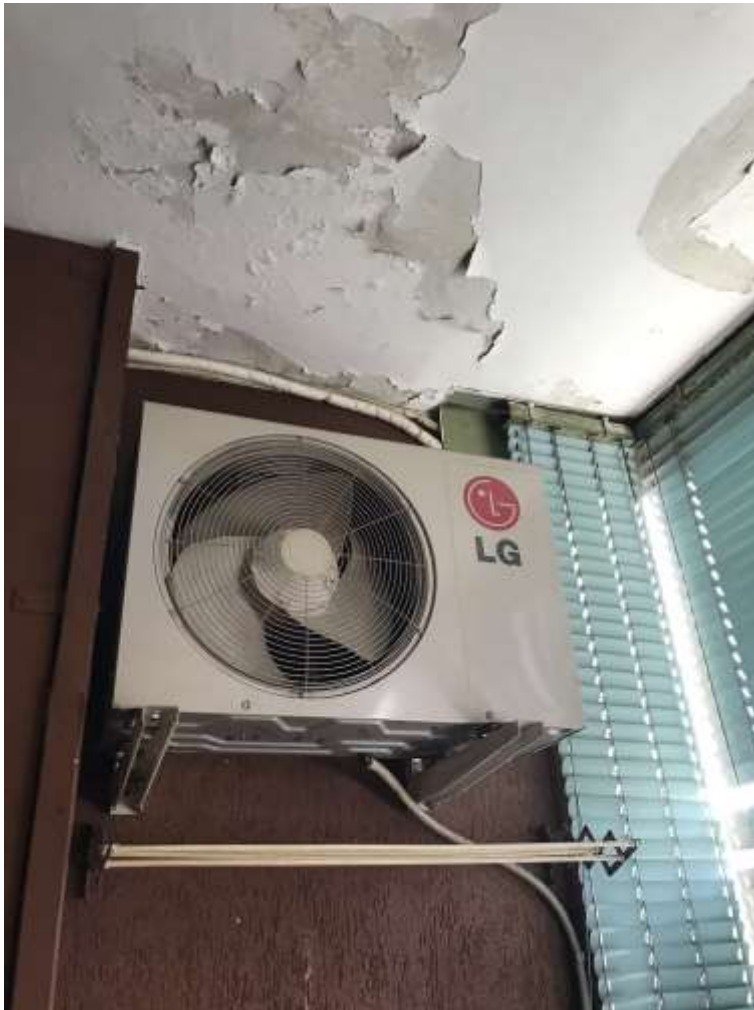
Foto 20. Vista della posizione della macchina per l'area condizionata, collocata sul balcone.
