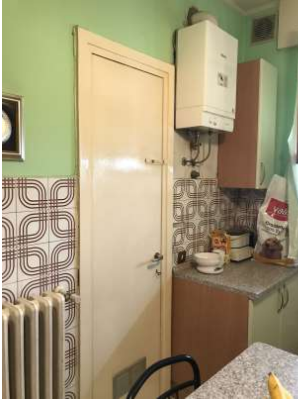
Foto 15. Vista della cucina, con particolare della collocazione della caldaia e la porta di ingresso di servizio.
