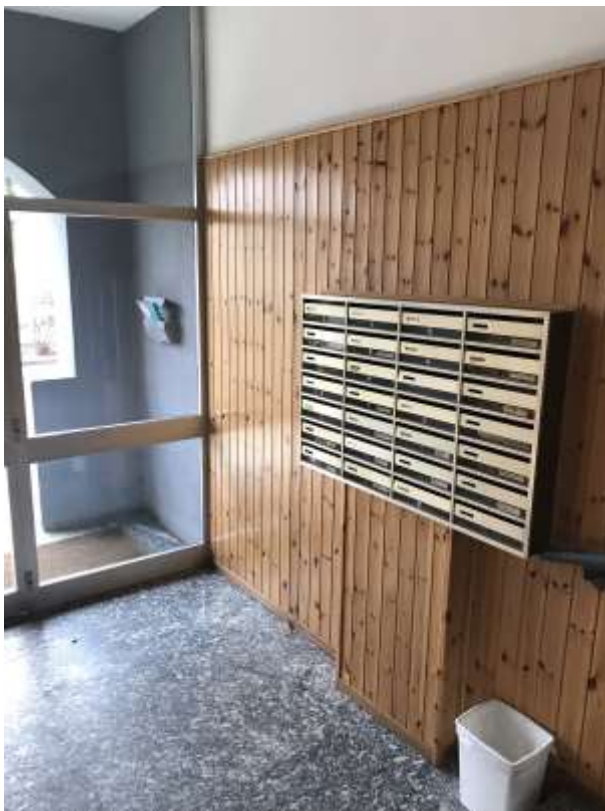
Foto 10. Vista dell'androne di ingresso al fabbricato con particolare della collocazione delle cassette postali.
