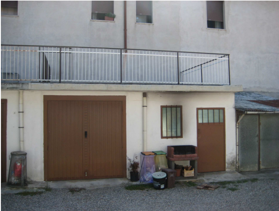
FOTO 20 – sul lato destro autorimessa con terrazzo/lastrico solare
