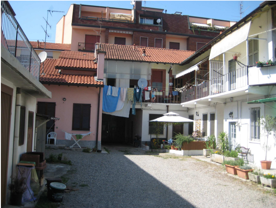
FOTO 4 – corte comune, lato destro corpo di fabbrica nel quale presente l'unità immobiliare oggetto del provvedimento
