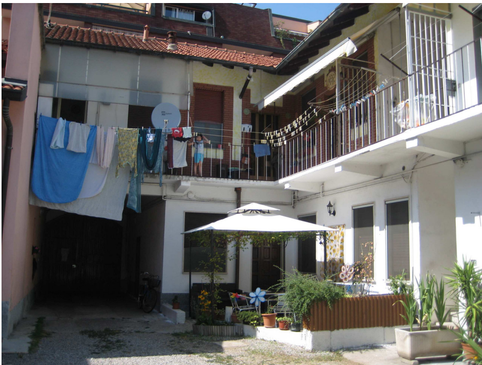
FOTO 5 – corte comune e al piano terra l'unità oggetto di stima
