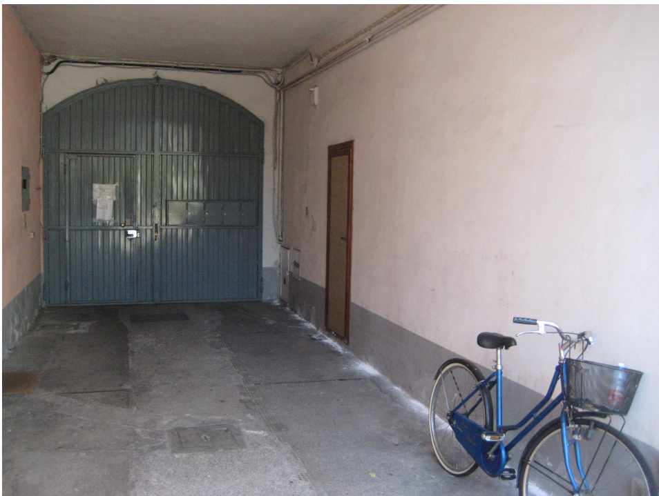
FOTO 3 – androne ingresso condominiale
