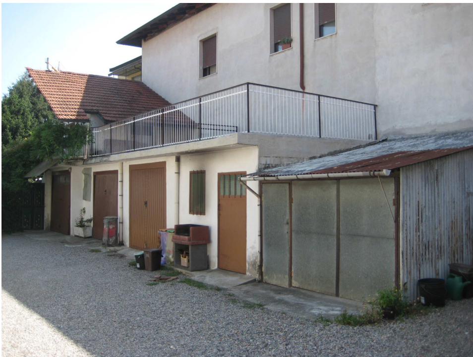
FOTO 19 – sul lato destro autorimessa con terrazzo/lastrico solare
