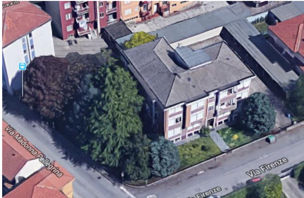
IMMOBILE VIA FIRENZE N°1
