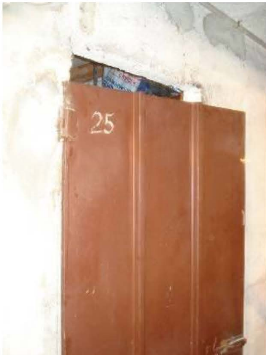
Porta di ingresso al locale piano S-1
