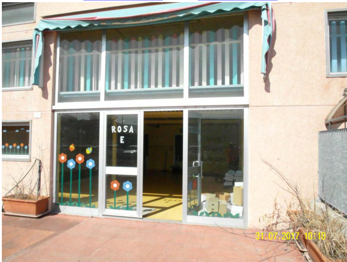
Foto n. 3: Come foto 2 vista dalla corte interna.
