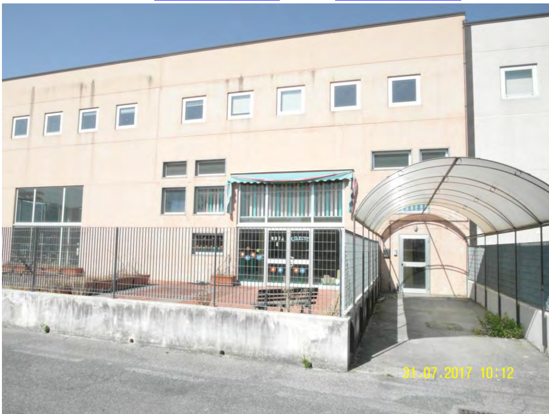
Foto n. 1: Accesso al fabbricato dalla via Bartocci.
