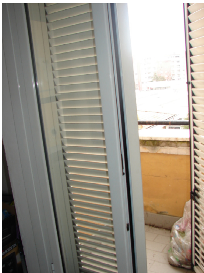
Foto 6 – Loggetta su via Monviso
