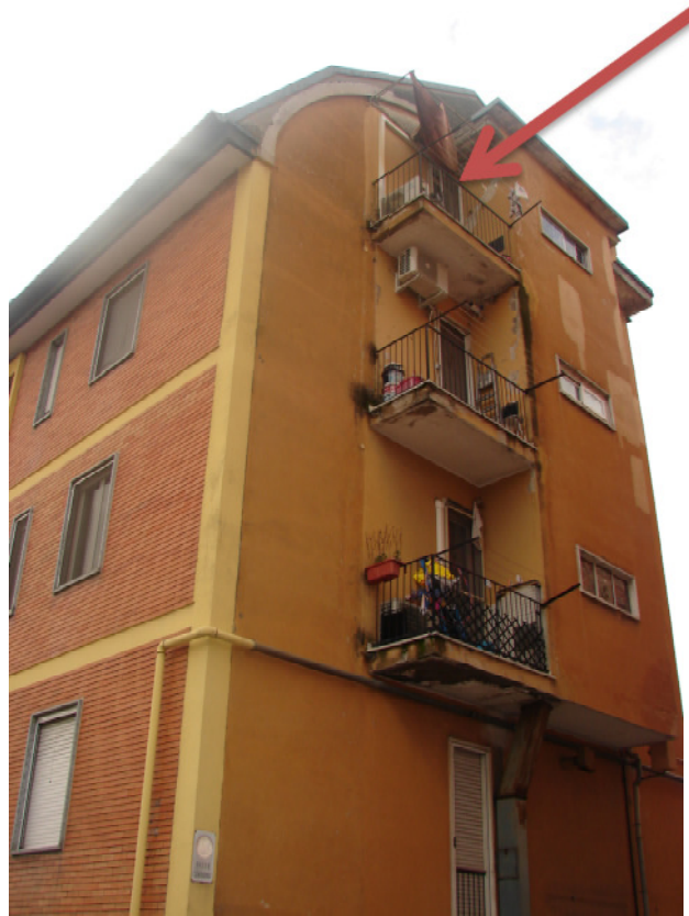
Foto 1 – Appartamento al terzo piano
