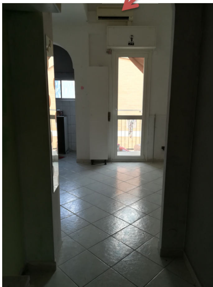
Foto 10 – Aria condizionata e pavimento in piastrelle
