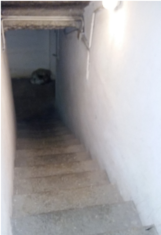
Vista scala cantine
