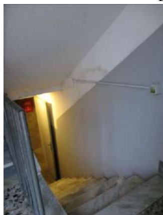
Scala accesso alla cantina
