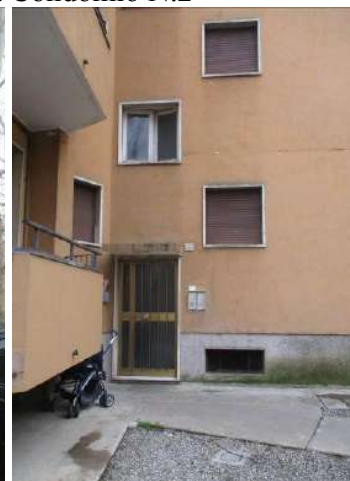
Ingresso civico N.2
