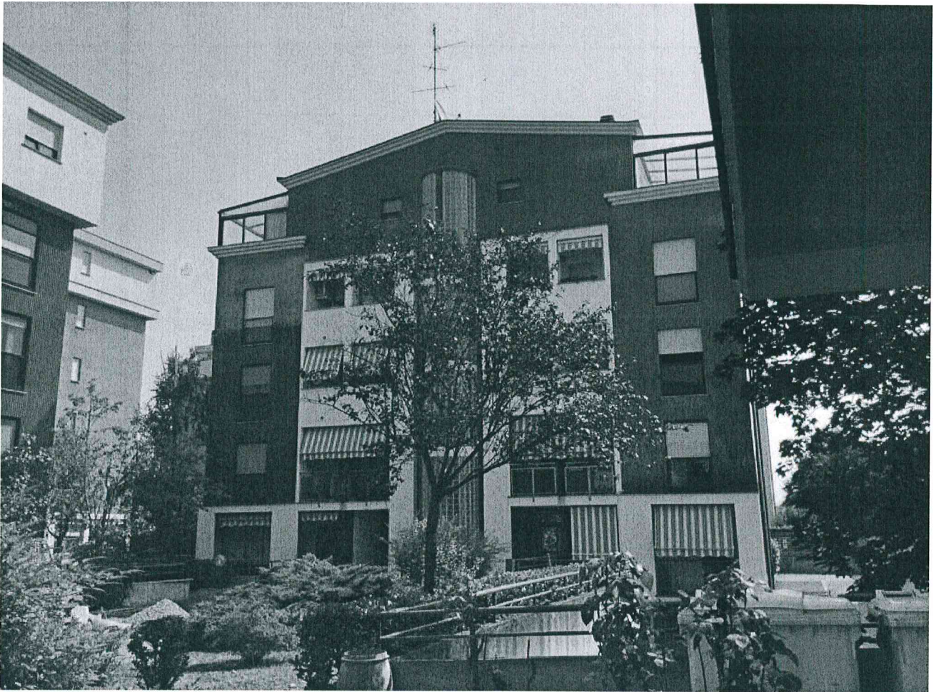
Fig.3: vista dal cortile interno dell'edificio oggetto di trattazione.
