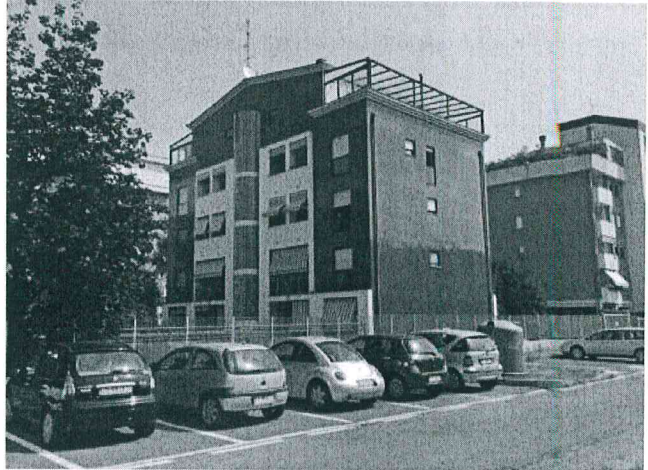
Fig.2: vista edificio da Via San Pio X.
