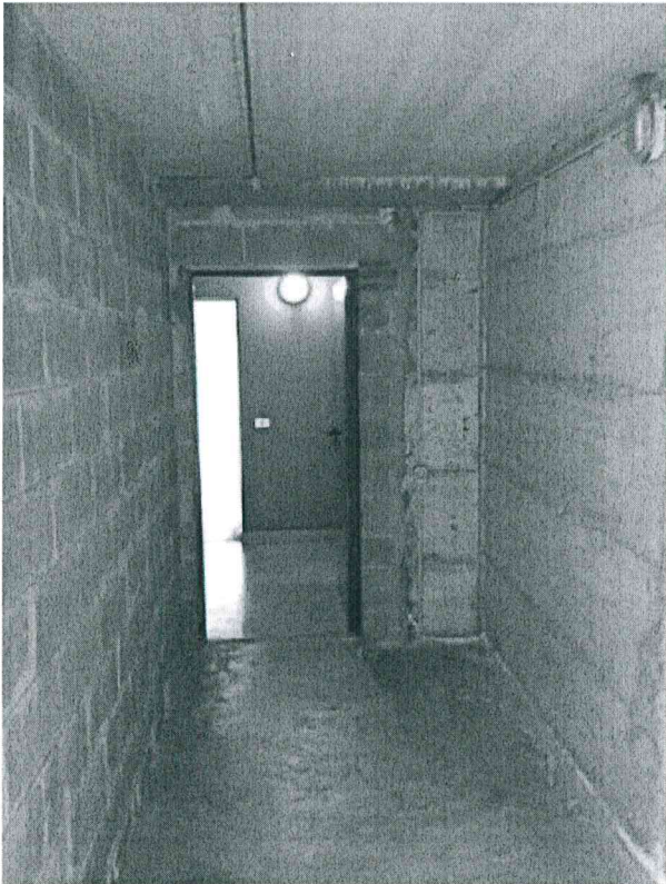
Fig.20: corridoio cantine verso scala.
