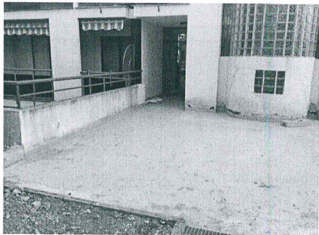
Fig.5: vista area accesso edificio.
