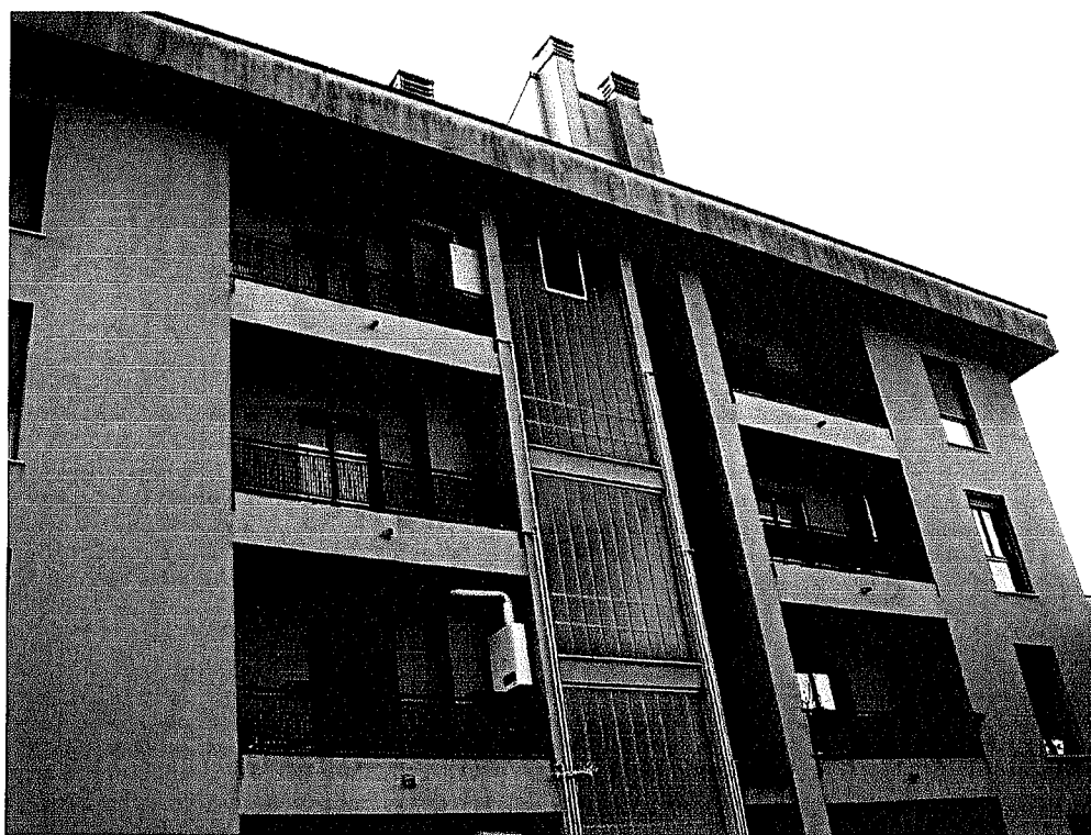
Foto n°. 4 Prospetto lato cortile interno (piano terzo ed ultimo)
