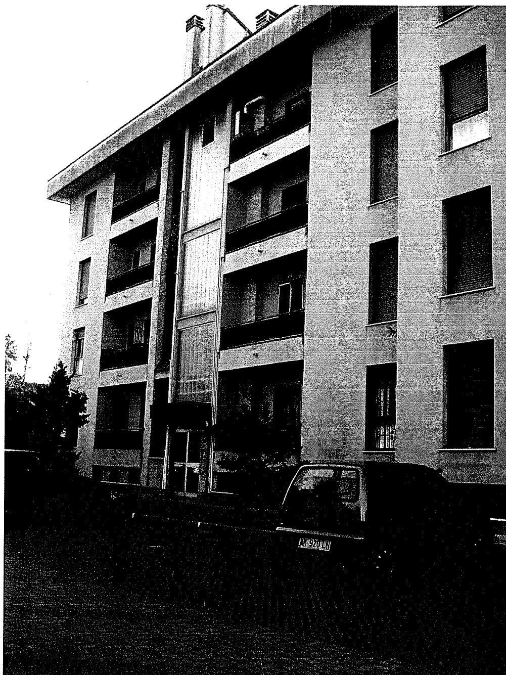
foto n°. 2 Prospetto interno lato sinistro (prima scala)
