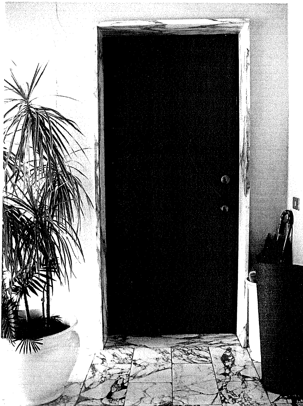
Foto n°. 8 L'ingresso all'unità esecutata
