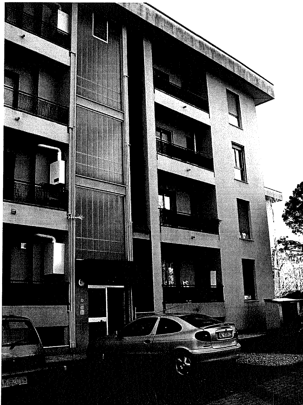
foto n°. 3 Prospetto interno lato destro (seconda scala)
