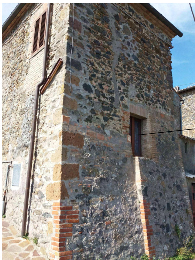
FINESTRA CHE ILLUMINA IN PARTE LA ZONA GIORNO E IN PARTE IL BAGNO
