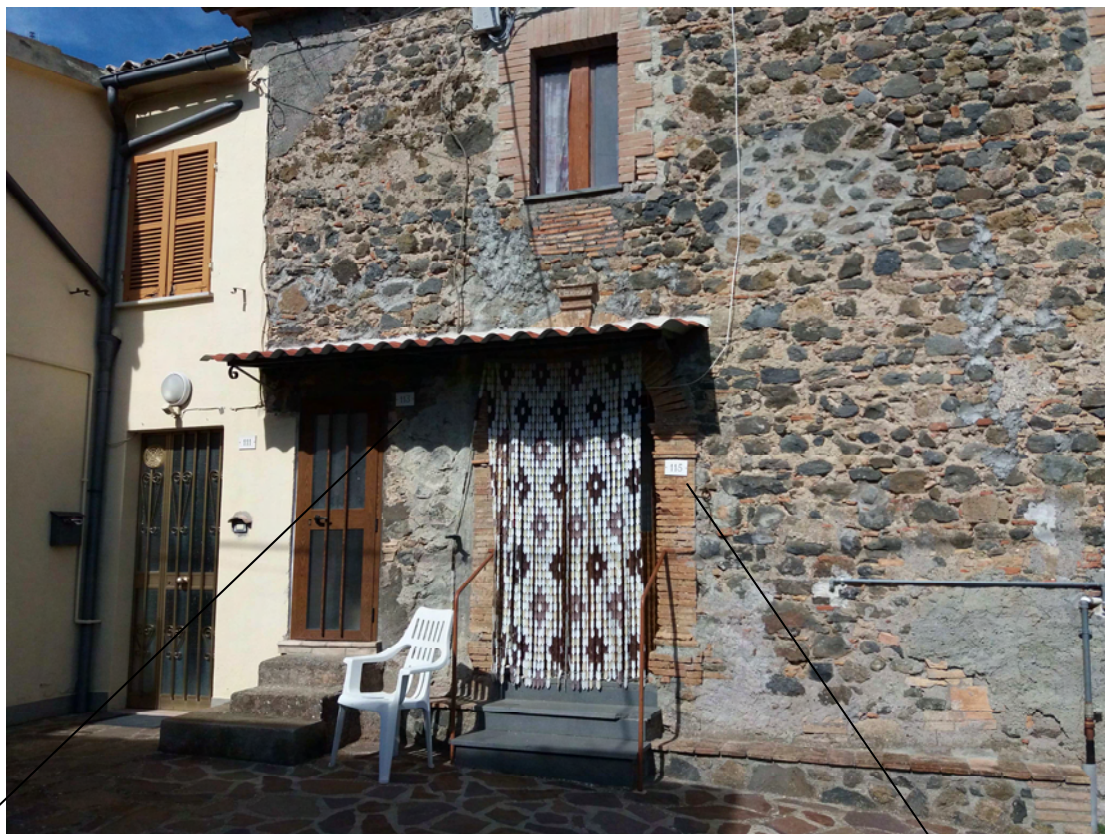
INGRESSO AL N° 113 : RAMPA DI SCALE E ACCESSO ALLA ZONA NOTTE
