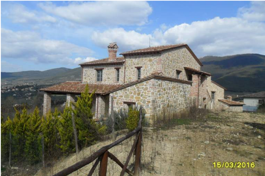
CORPO E - esterno fabbricato
