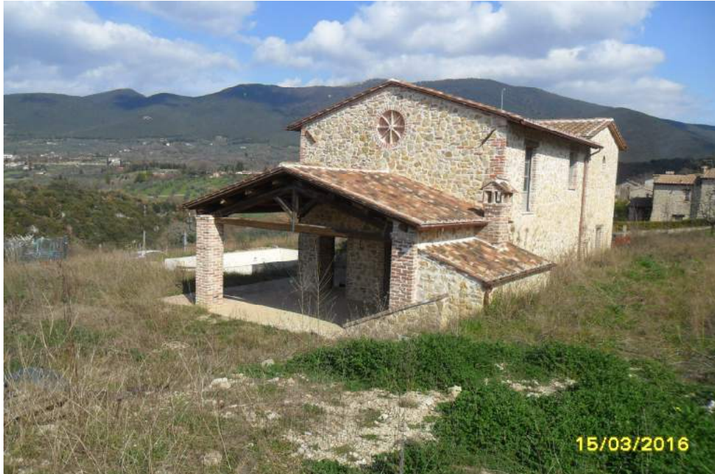
CORPO A - esterno fabbricato
