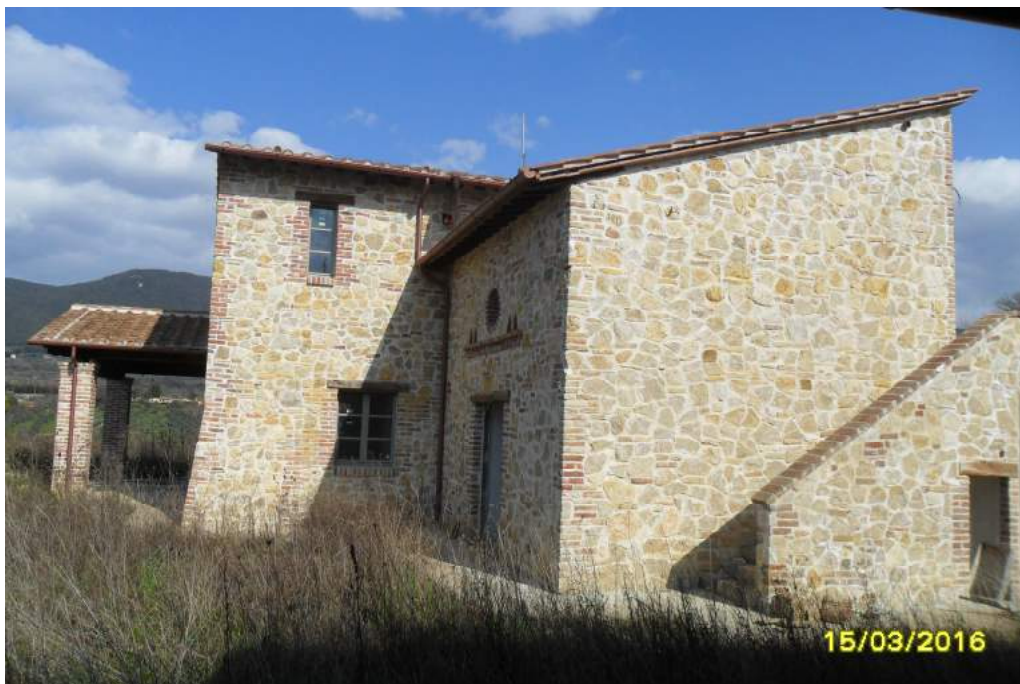
CORPO C - esterno fabbricato
