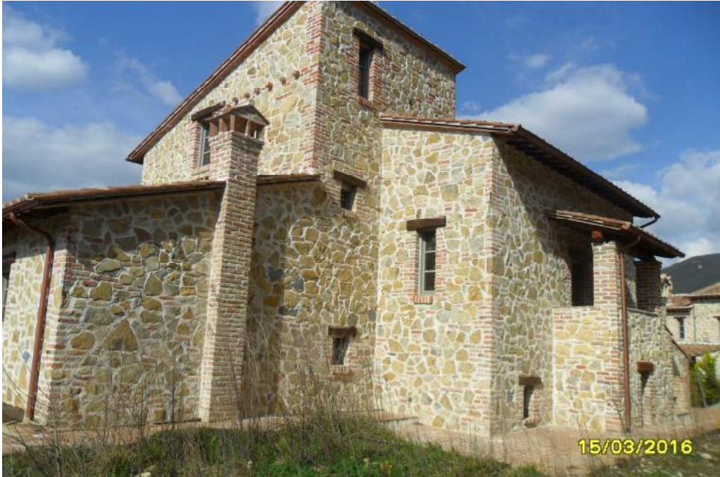
CORPO D - esterno fabbricato
