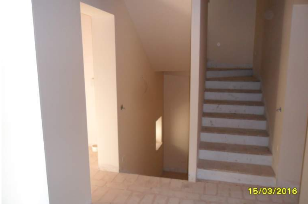
CORPO D - interno fabbricato
