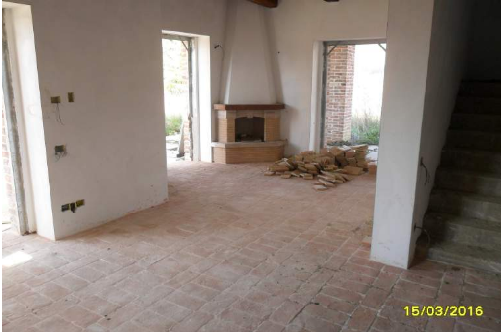
CORPO B - interno fabbricato
