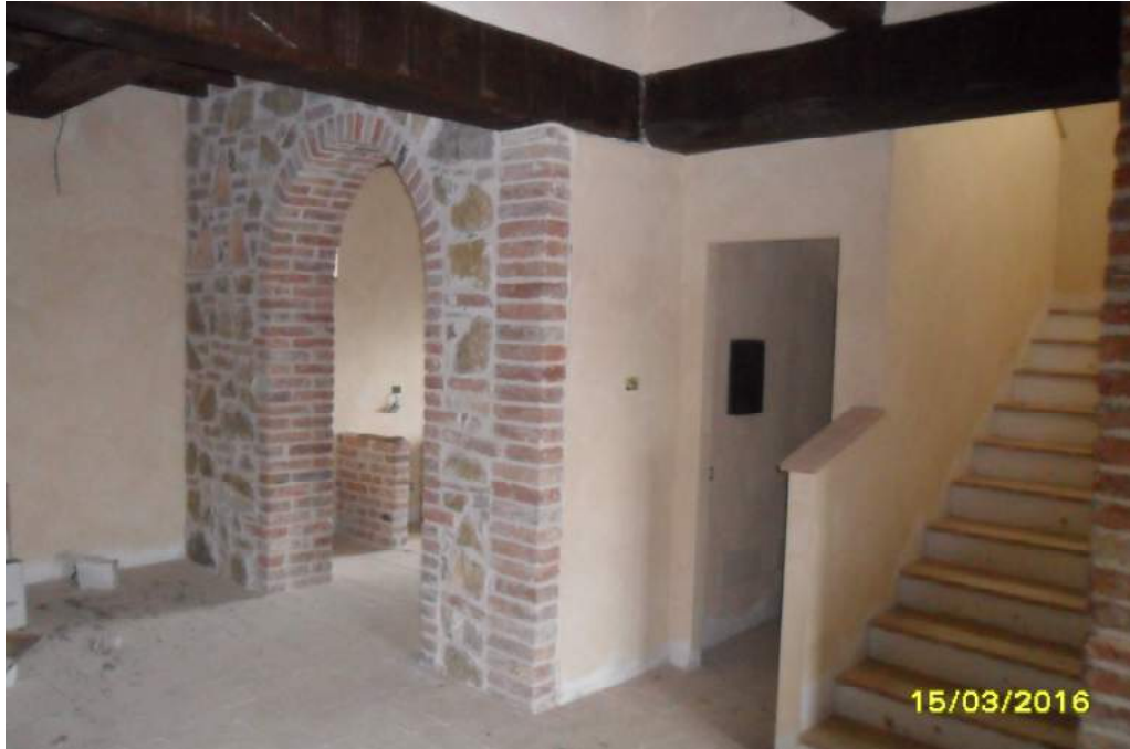
CORPO E - interno fabbricato
