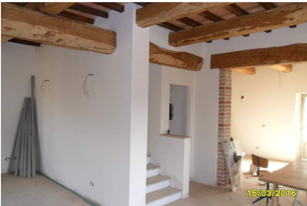
CORPO F - interno fabbricato
