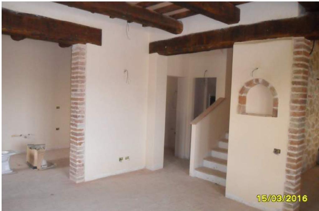
CORPO D - interno fabbricato
