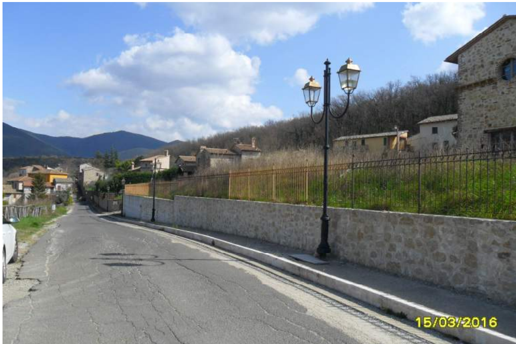
opere urbanizzazione lottizzazione (dalla via San Rocco)
