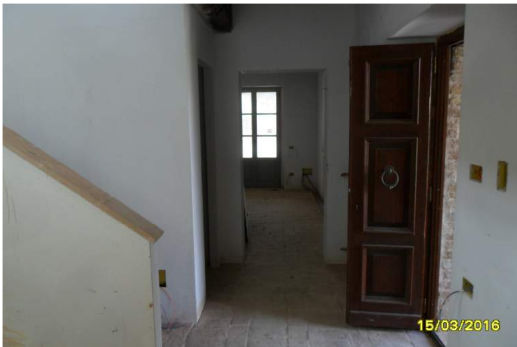
CORPO A - interno fabbricato
