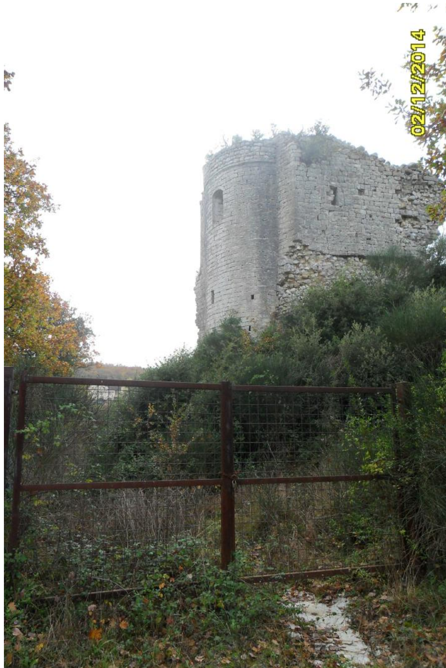
Ruderi Castello di Carnano (ingresso al fondo dalla via di Carnano - vista dei resti della chiesa)
