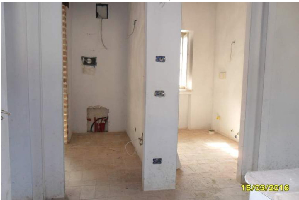
CORPO C - interno fabbricato
