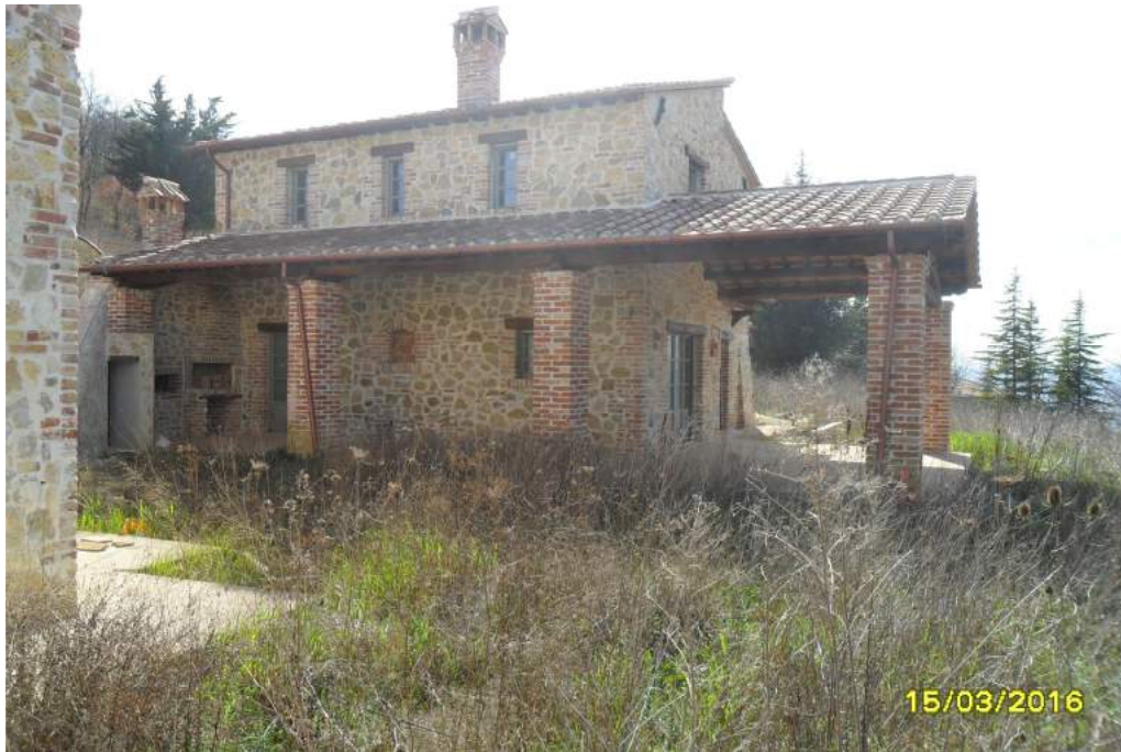
CORPO C - esterno fabbricato
