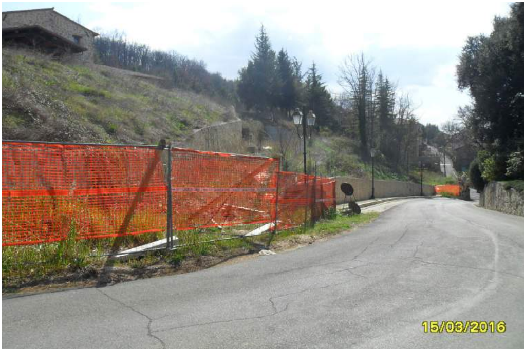
opere urbanizzazione lottizzazione (dalla via San Rocco)
