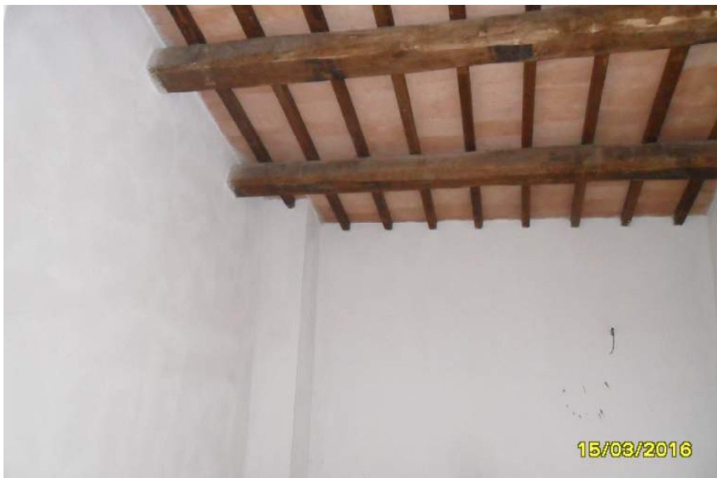
CORPO B - interno fabbricato
