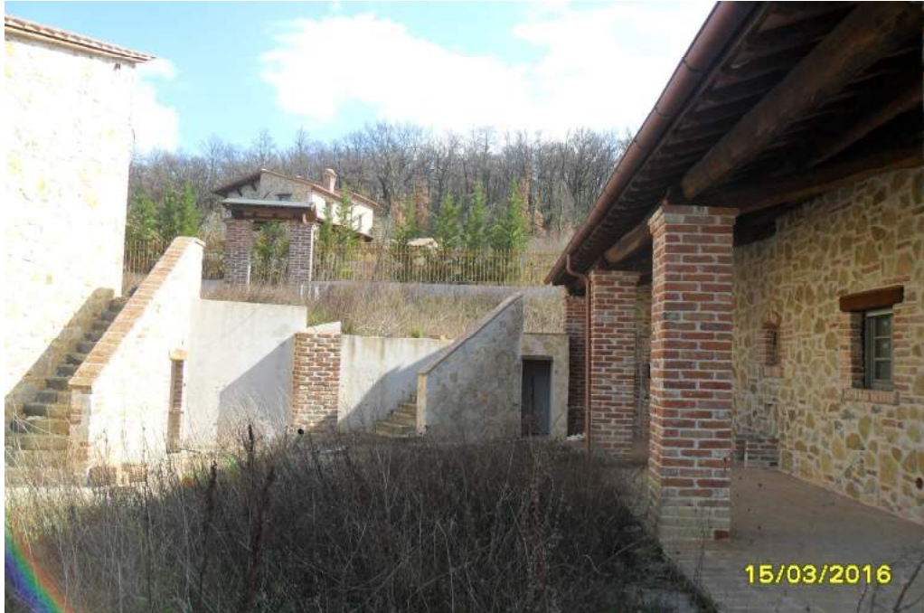
CORPO C - esterno fabbricato (vista muro di collegamento CORPO B - CORPO C)
