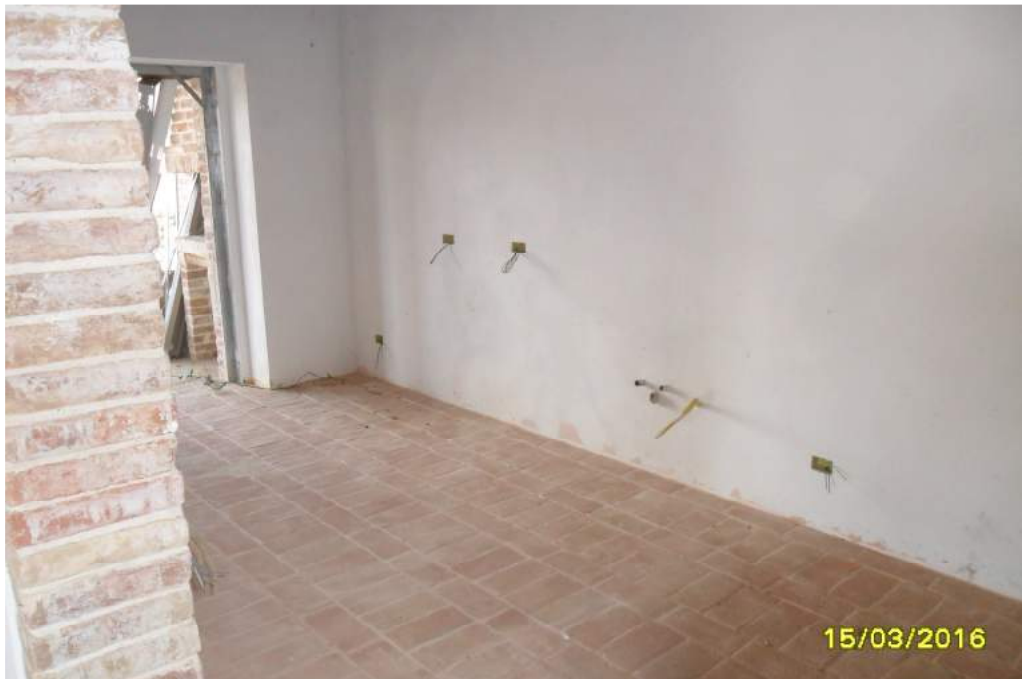
CORPO B - interno fabbricato
