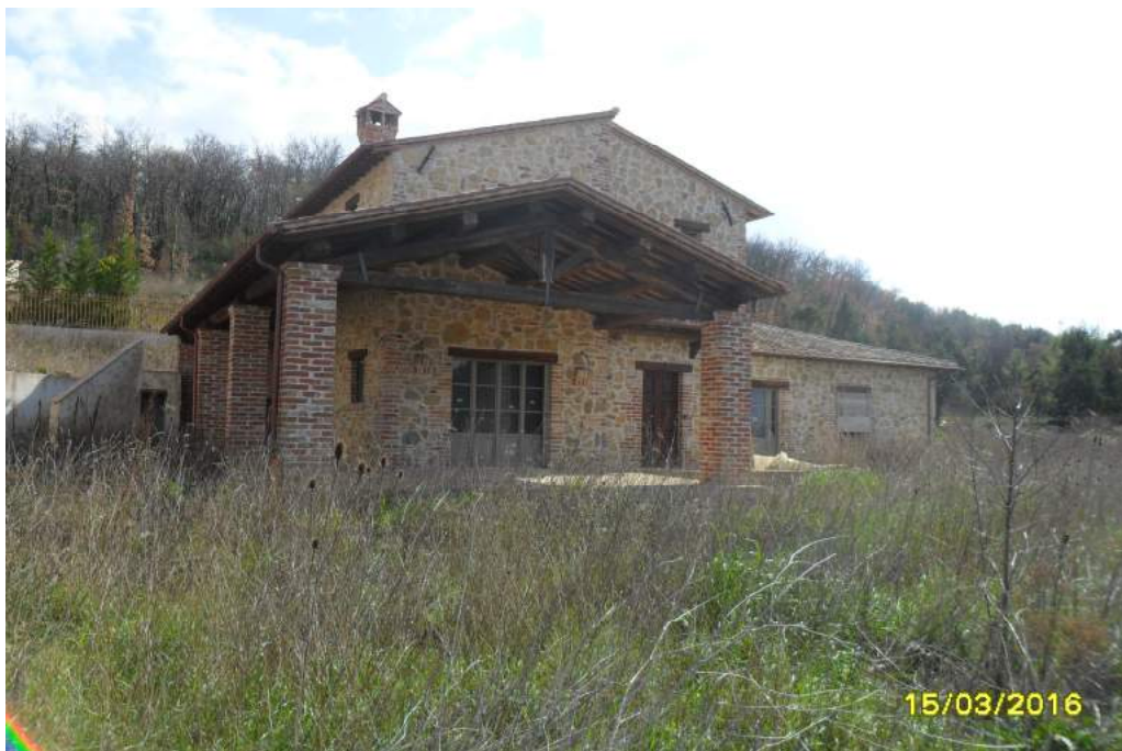
CORPO C - esterno fabbricato
