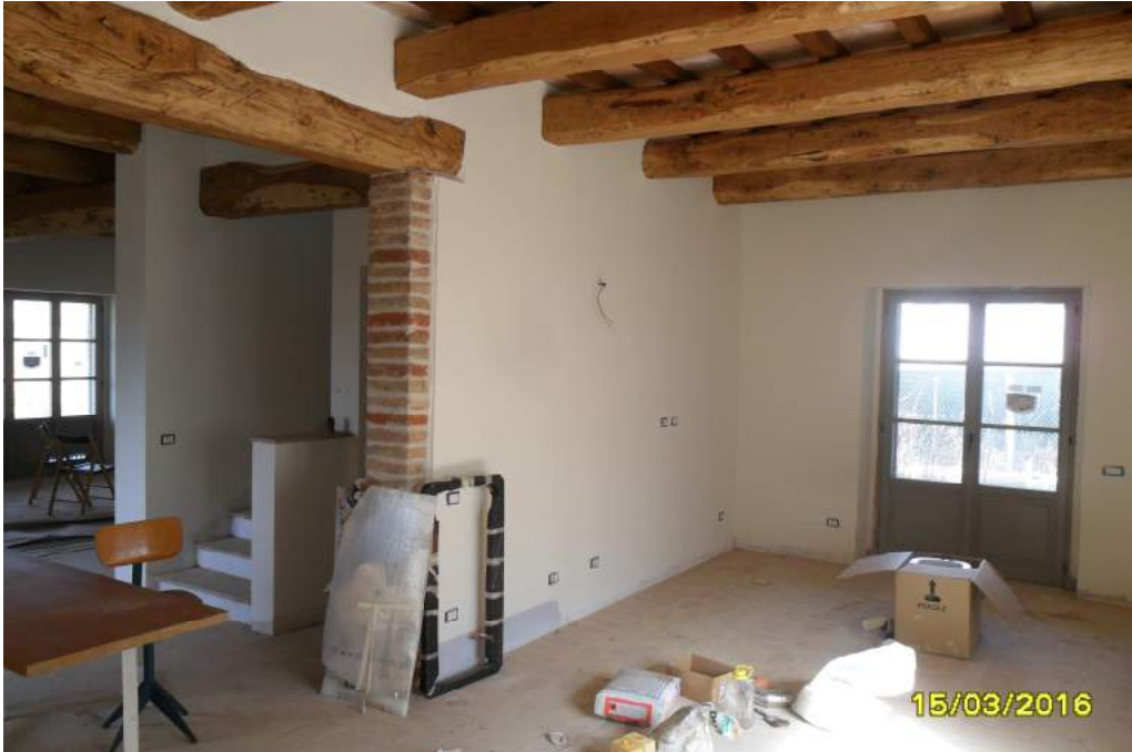
CORPO F - interno fabbricato
