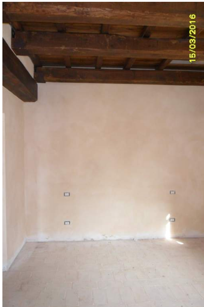
CORPO E - interno fabbricato
