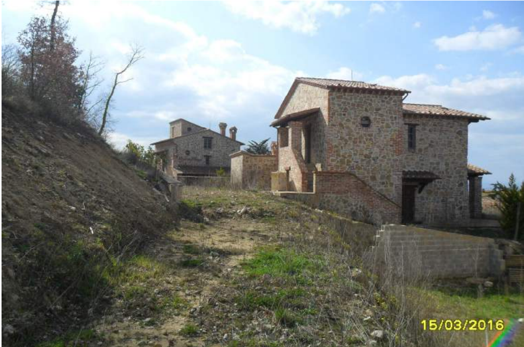
CORPO E - esterno fabbricato (vista opere sistemazione terreno lato sud-est)
