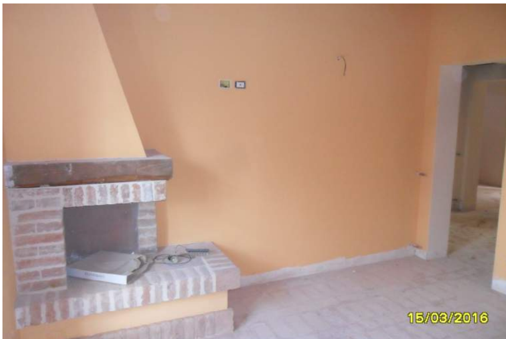
CORPO D - interno fabbricato
