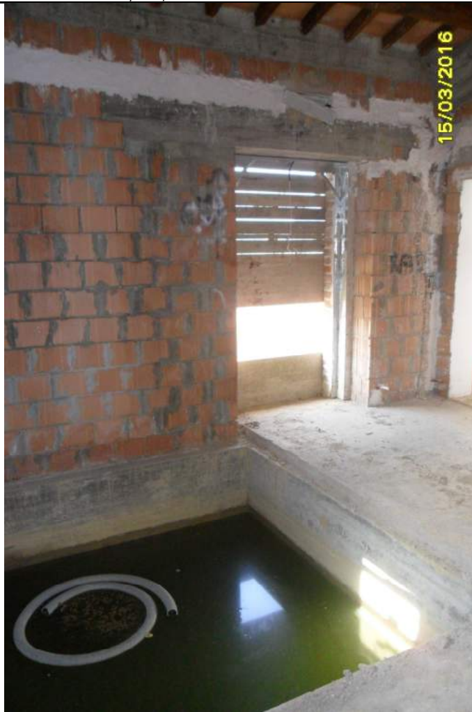
CORPO C - interno fabbricato
