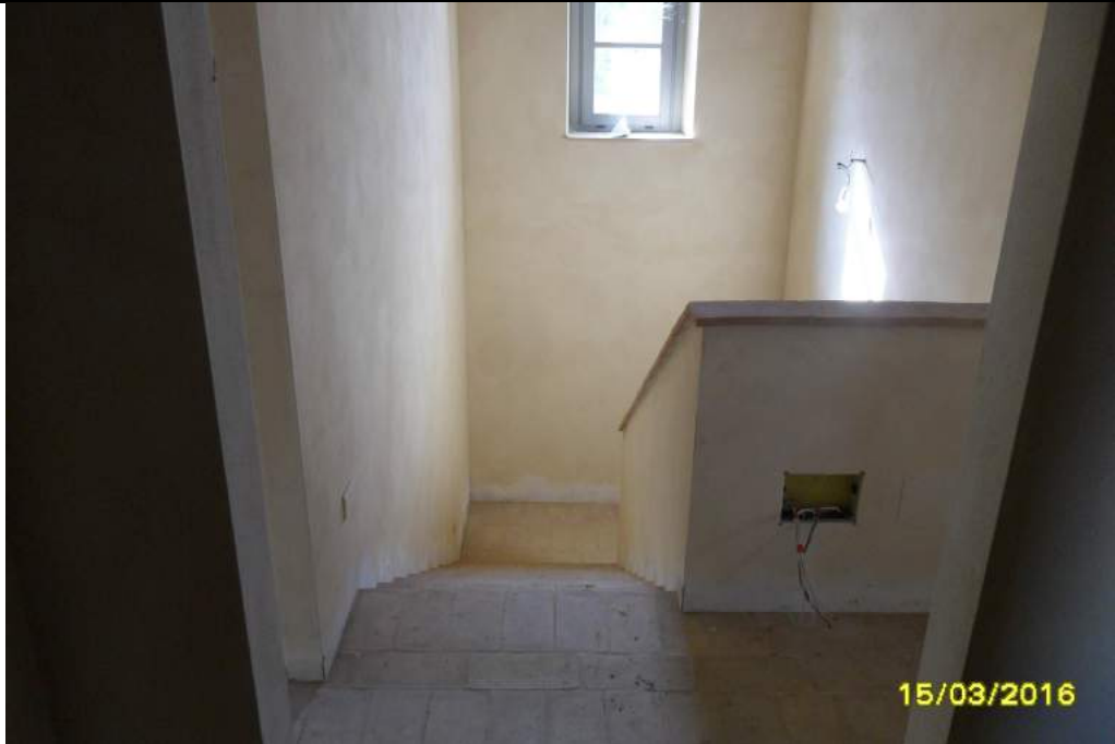
CORPO E - interno fabbricato
