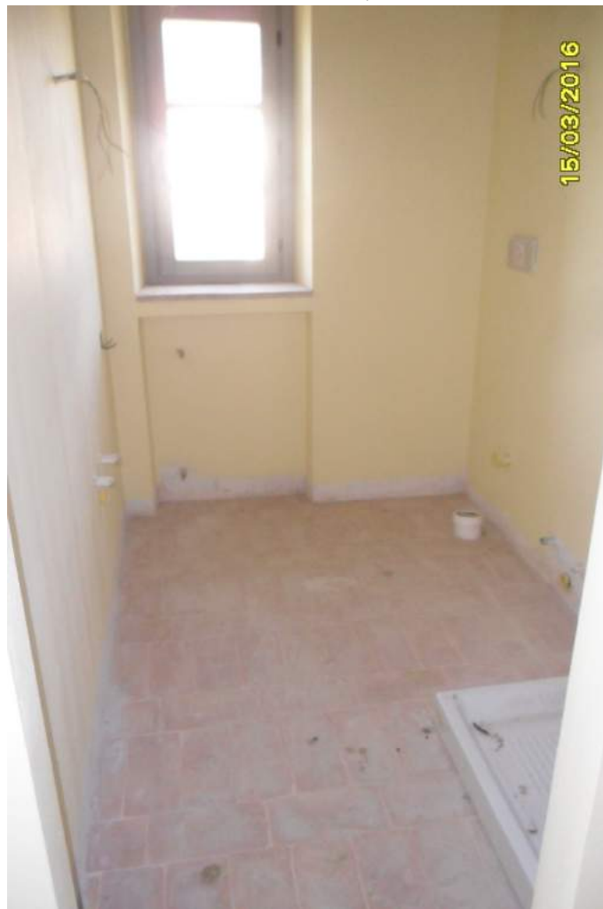
CORPO D - interno fabbricato
