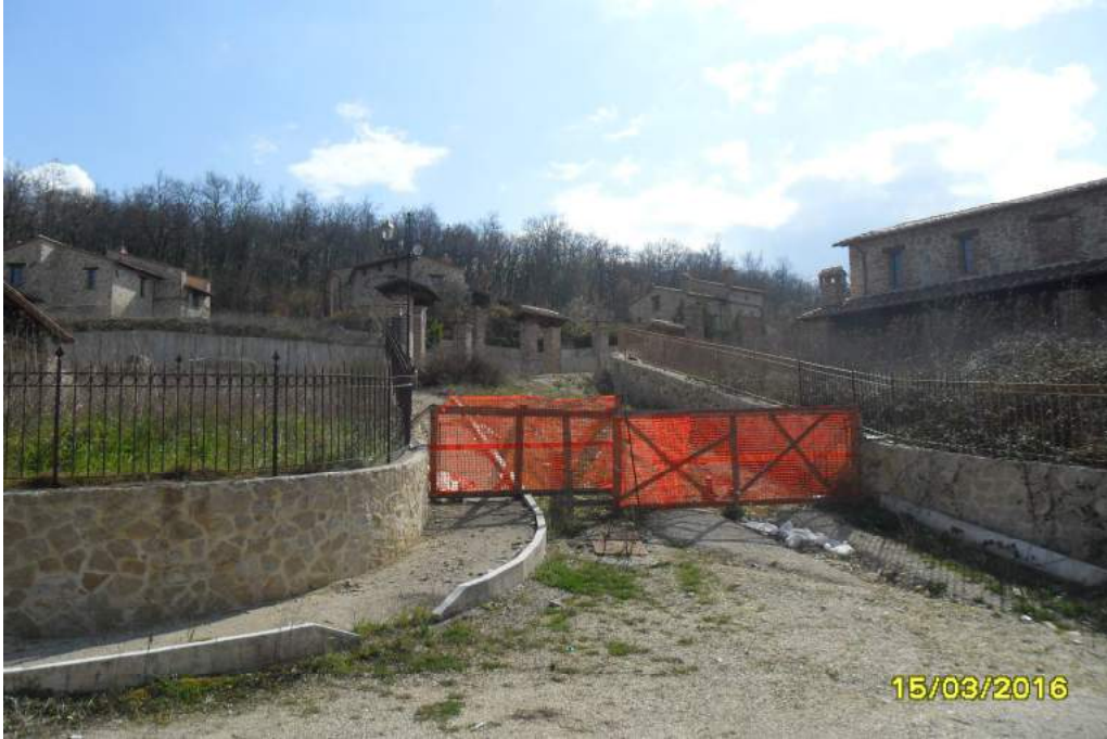
opere urbanizzazione (ingresso lottizzazione dalla via San Rocco)
