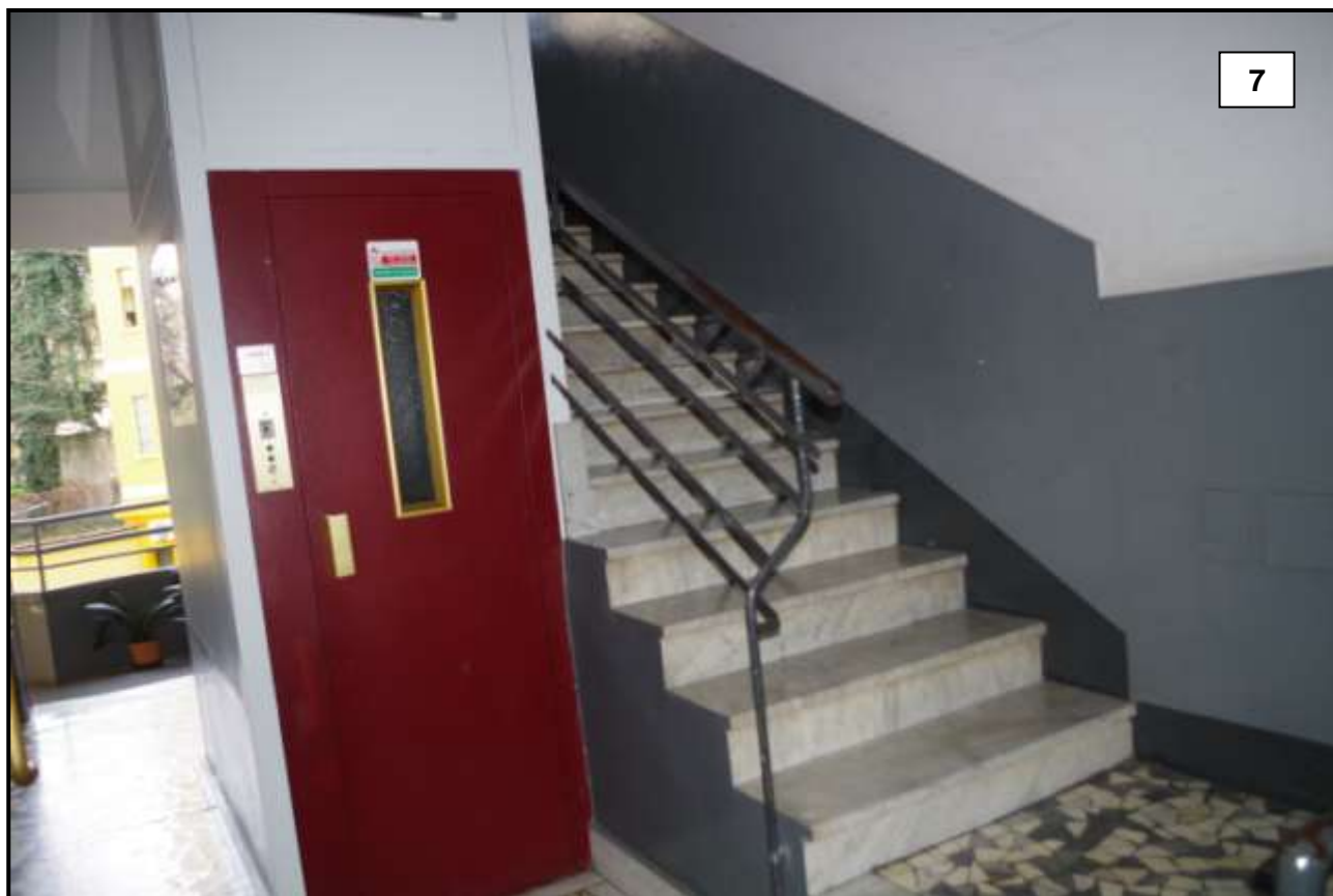
PASSAGGIO DI ACCESSO AI VANI SCALA (vista da androne)
