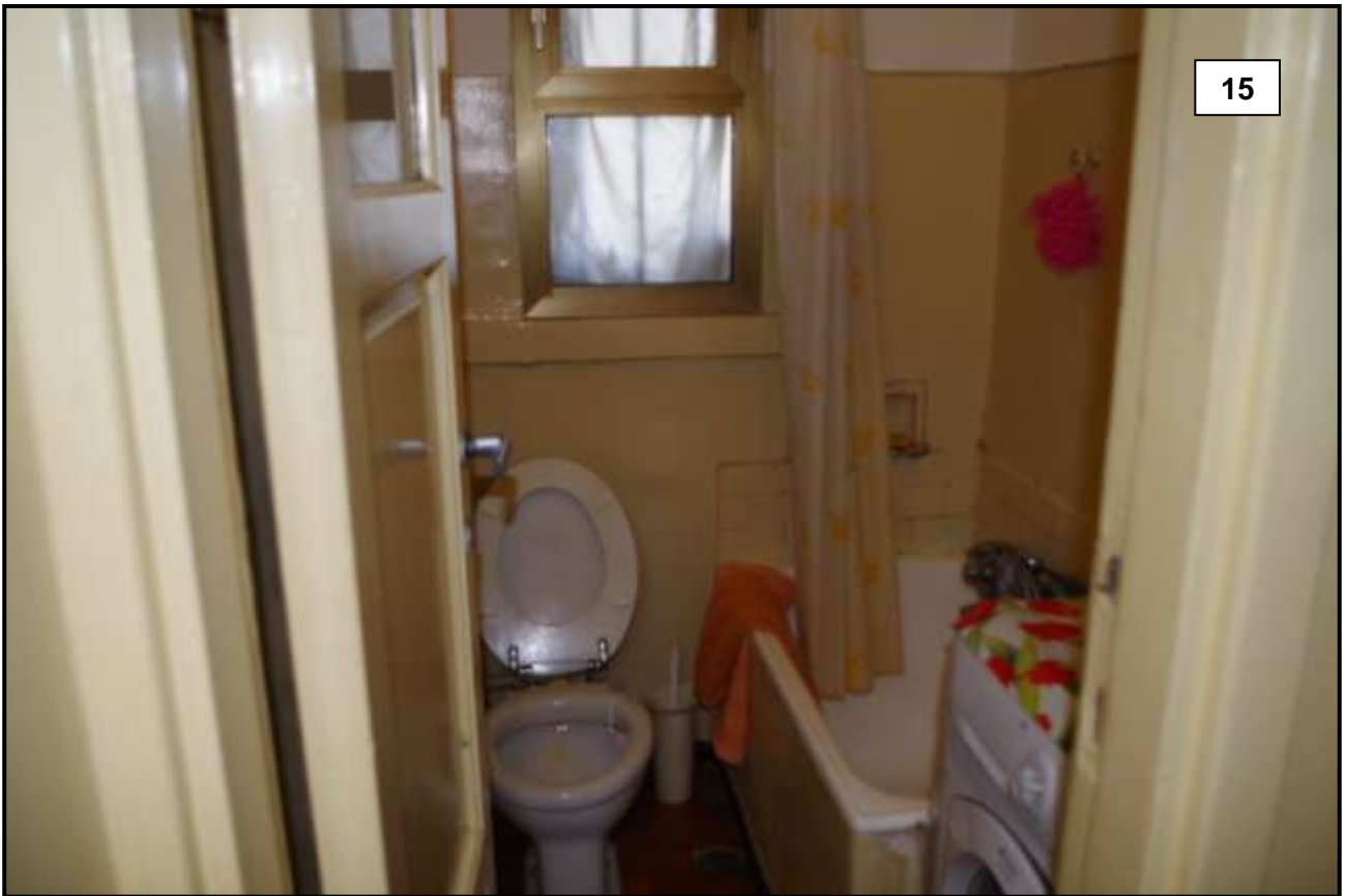
BAGNO (vista da antibagno)
