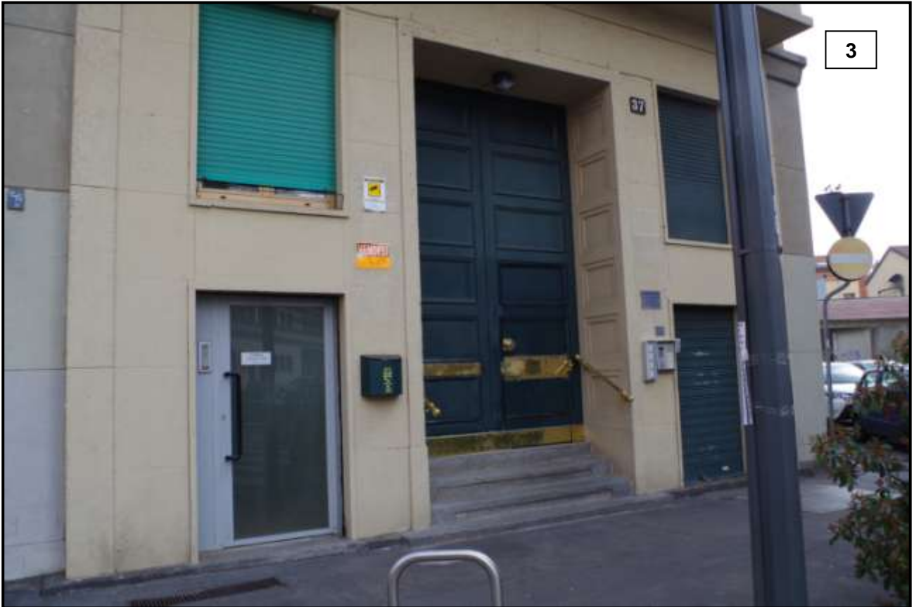
INGRESSO PEDONALE EDIFICIO (su via Mola)
