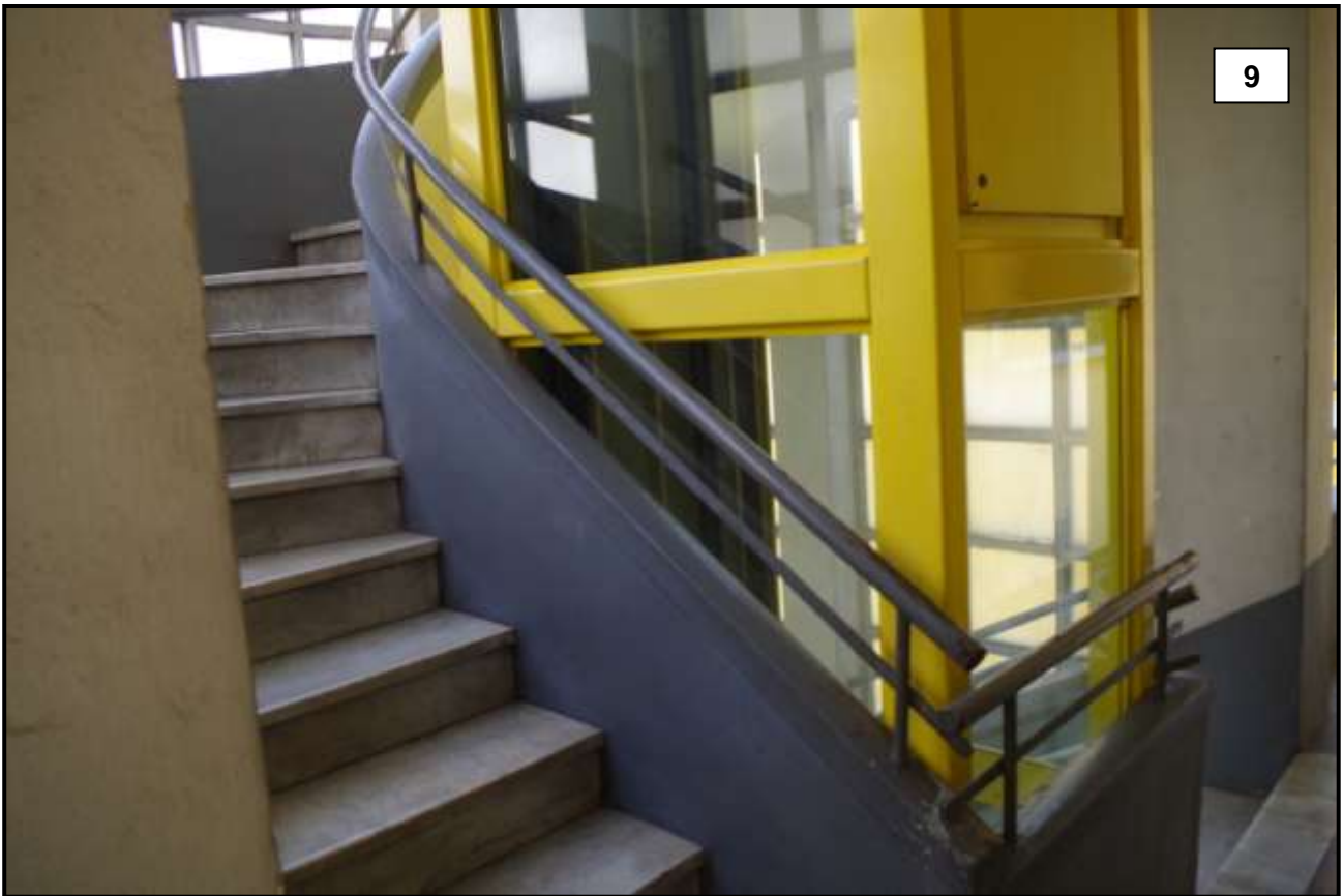
VANO SCALA B (vista da ballatoio)
