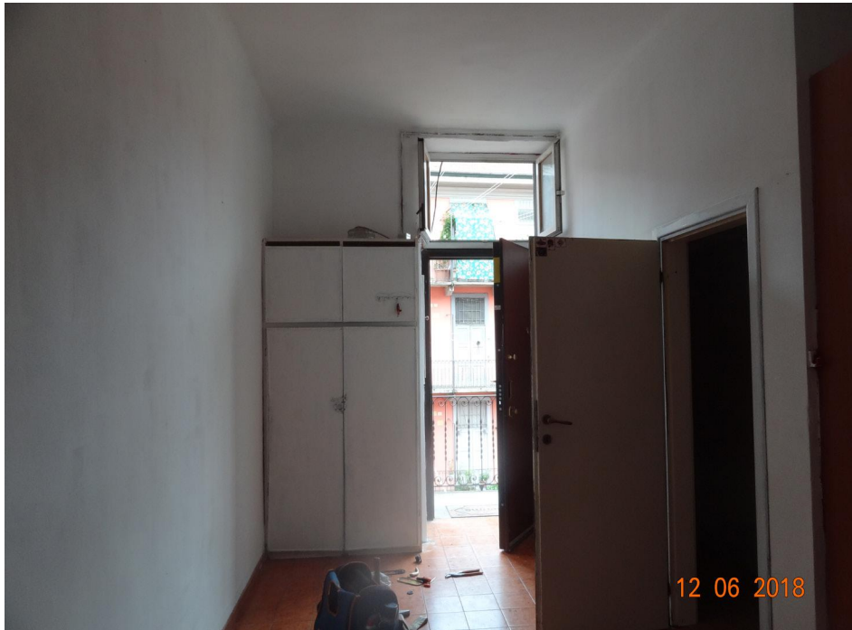
Vista interna - ingresso unità abitativa
