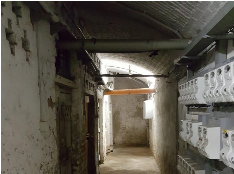
Vista interna - piano interrato cantina
