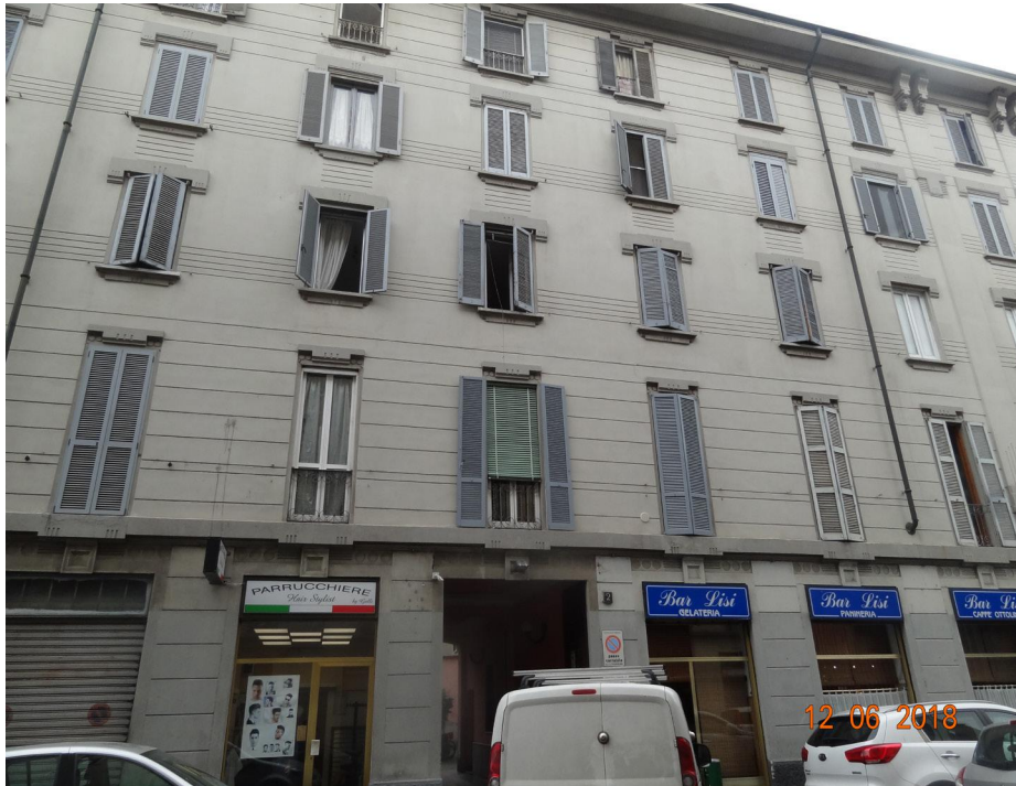
Vista esterna - ingresso carraio e pedonale fronte strada
