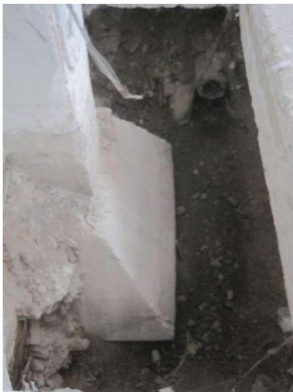
Dettagli – Scavi in sezione in corrispondenza dei pilastri perimetrali
