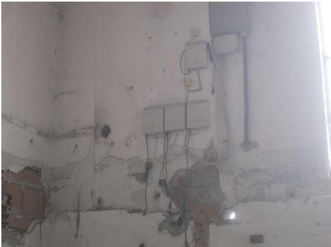
Dettagli – Distacchi di intonaco
