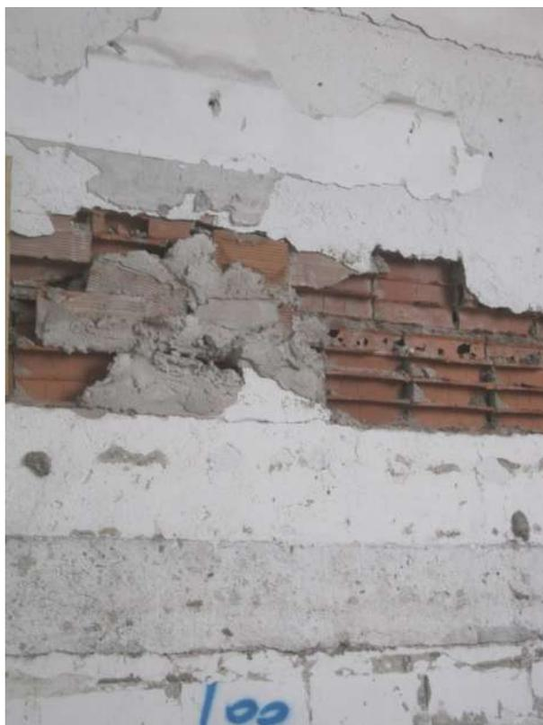
Dettagli – Danni alla muratura perimetrale di tamponamento in mattoni forati
