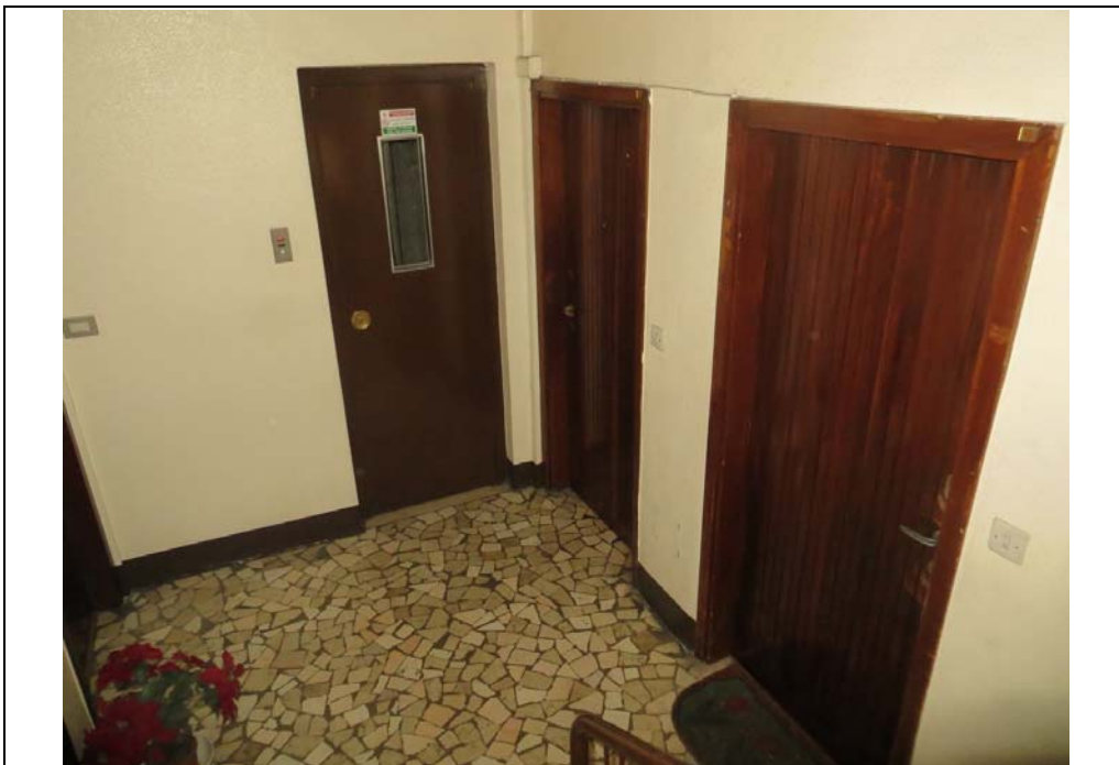
Vista interna del pianerottolo comune di accesso all'appartamento
