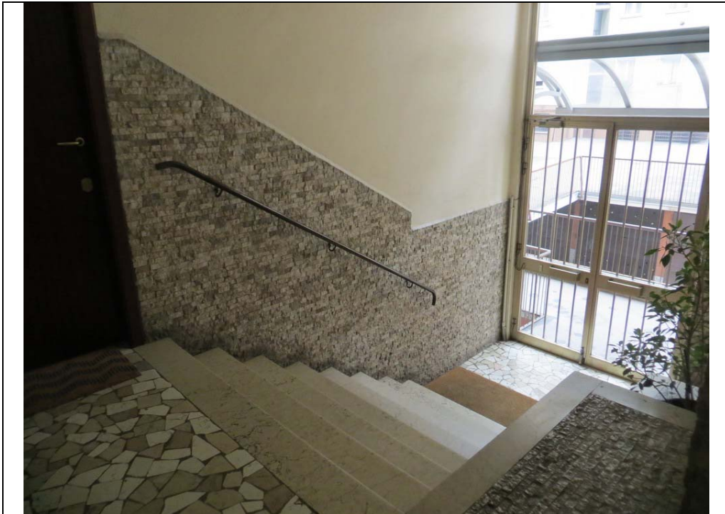
Vista interna del vano scala comune di accesso
