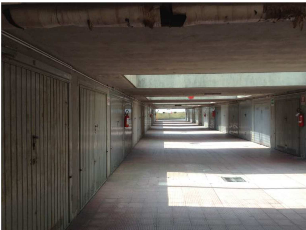
Foto 4,5 – vista corsello manovra
