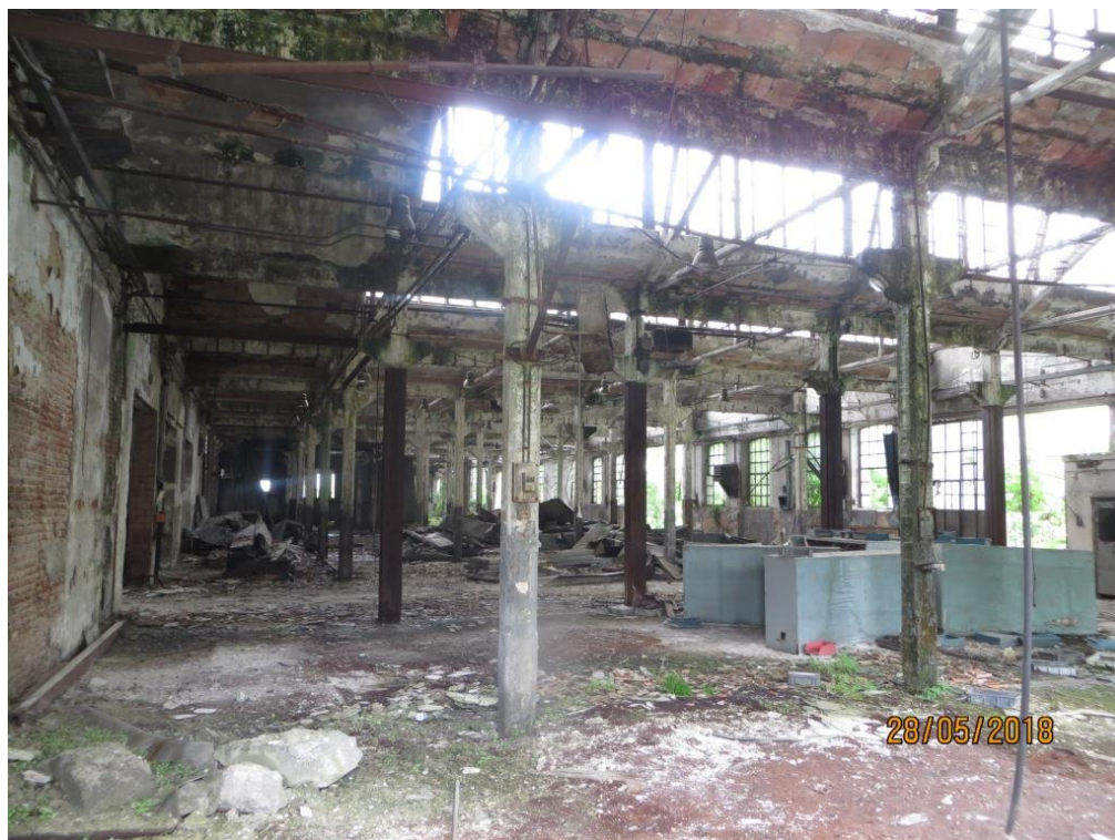
Foto 8 – Area "ex Fonderia" particolare degli interni
