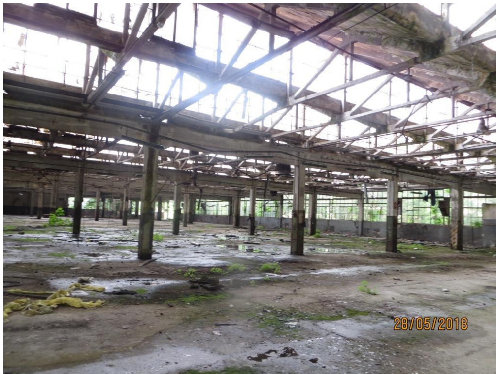
Foto 9 – Area "ex Fonderia" particolare degli interni
