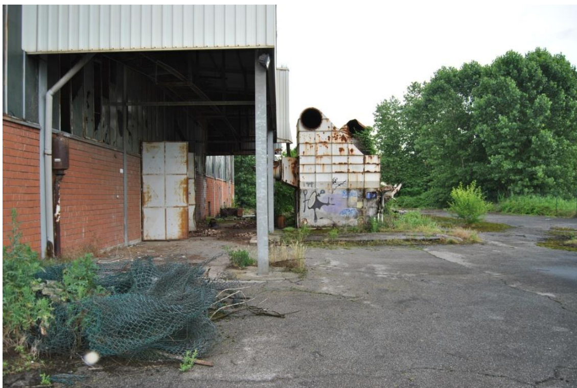
Foto 10 – Particolare del fabbricato dismesso su particella 85 e terreno particella 102
