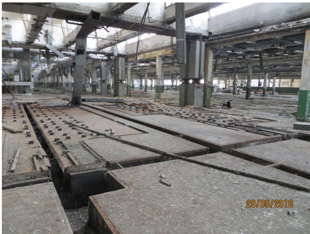
Foto 14 – Area "ex Compressori" particolare degli interni
