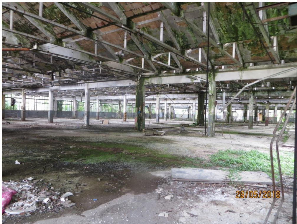
Foto 10 – Area "ex Fonderia" particolare degli interni
