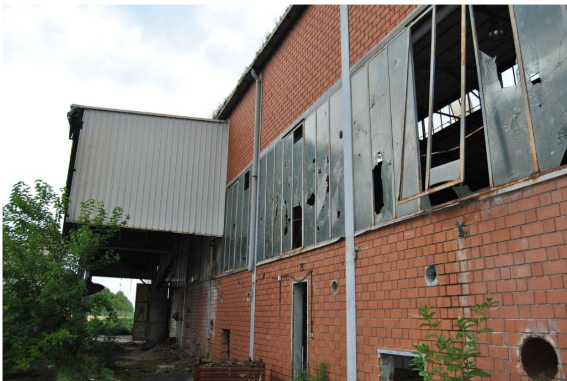
Foto 8 – Particolare del fabbricato dismesso su particella 85
