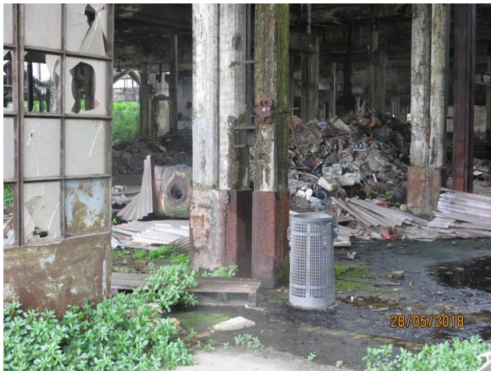
Foto 7 – Area "ex Fonderia" particolare degli interni
