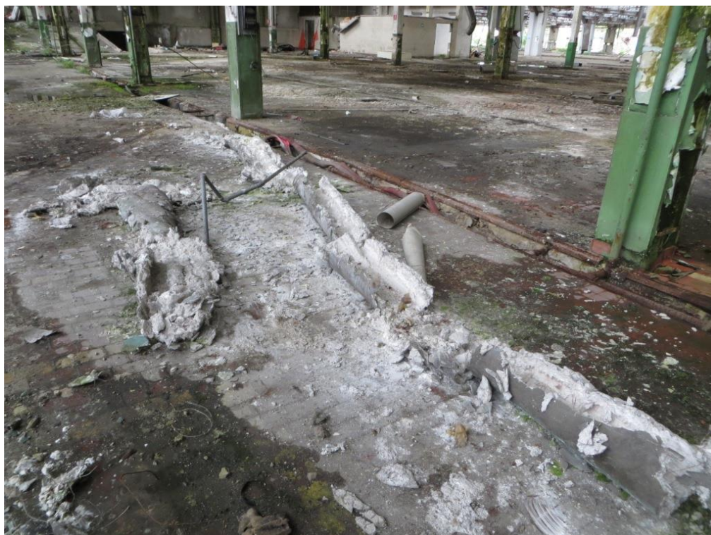
Foto 18 – Area "ex Compressori" particolare del deposito materiale con probabile presenza di amianto
