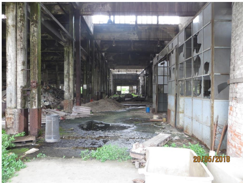
Foto 6 – Area "ex Fonderia" particolare degli interni
