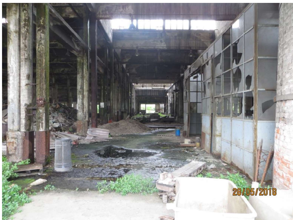
Foto 6 – Area "ex Fonderia" particolare degli interni
