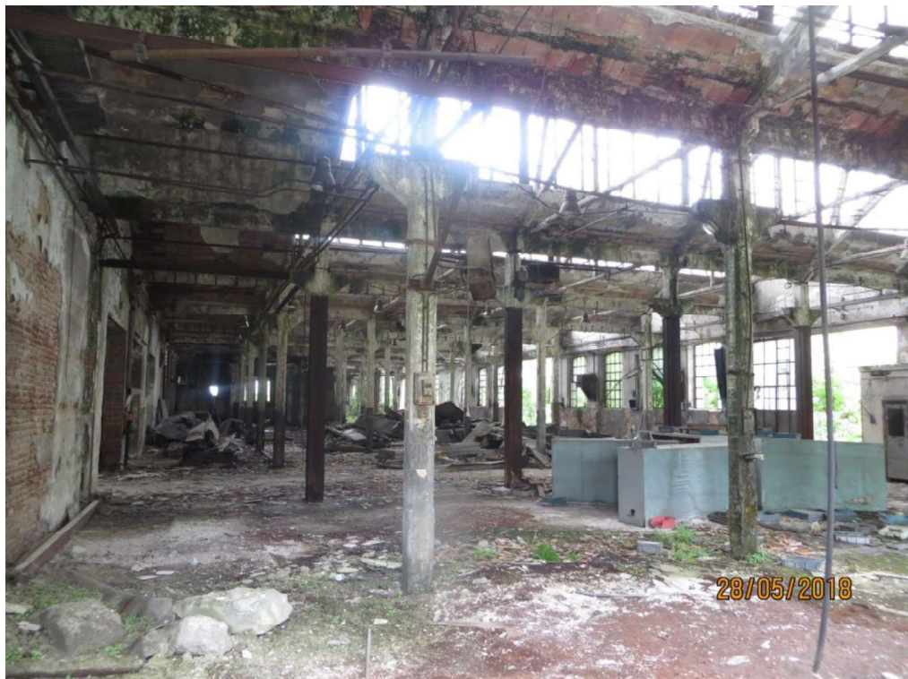
Foto 8 – Area "ex Fonderia" particolare degli interni
