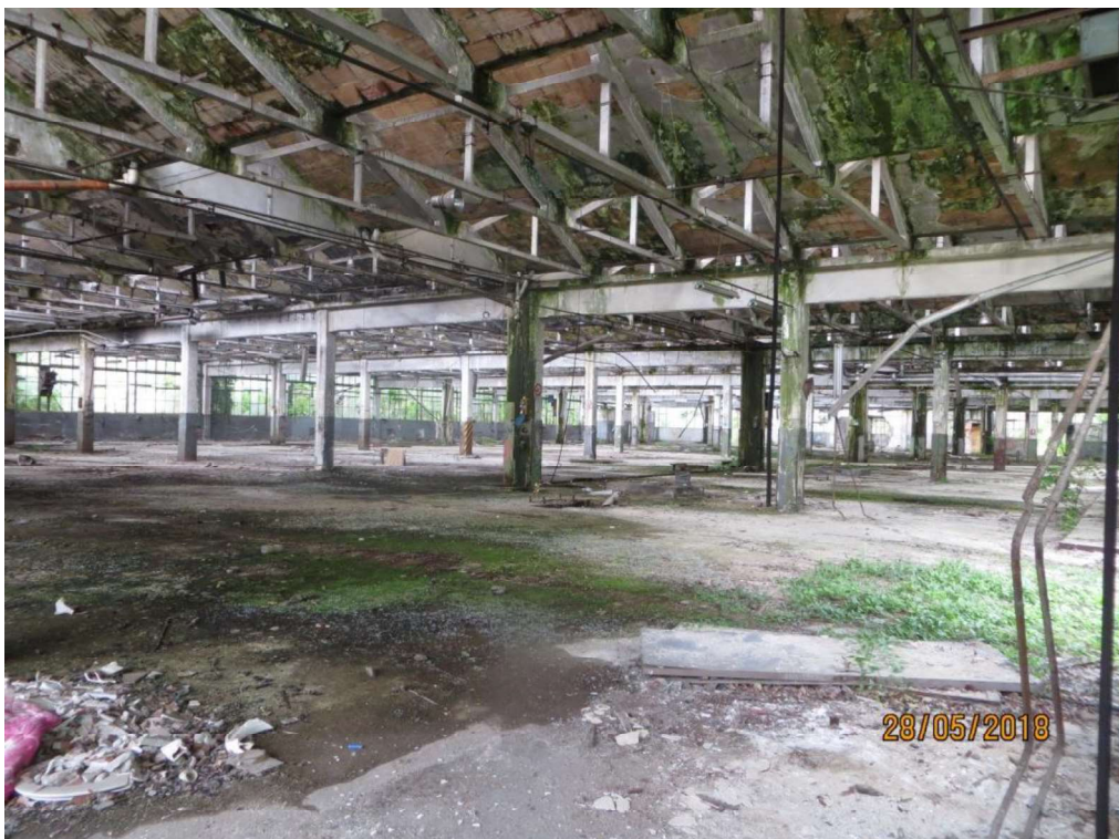
Foto 10 – Area "ex Fonderia" particolare degli interni
