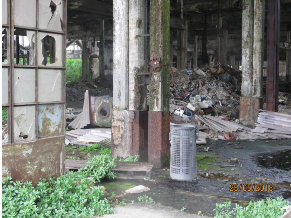
Foto 7 – Area "ex Fonderia" particolare degli interni
