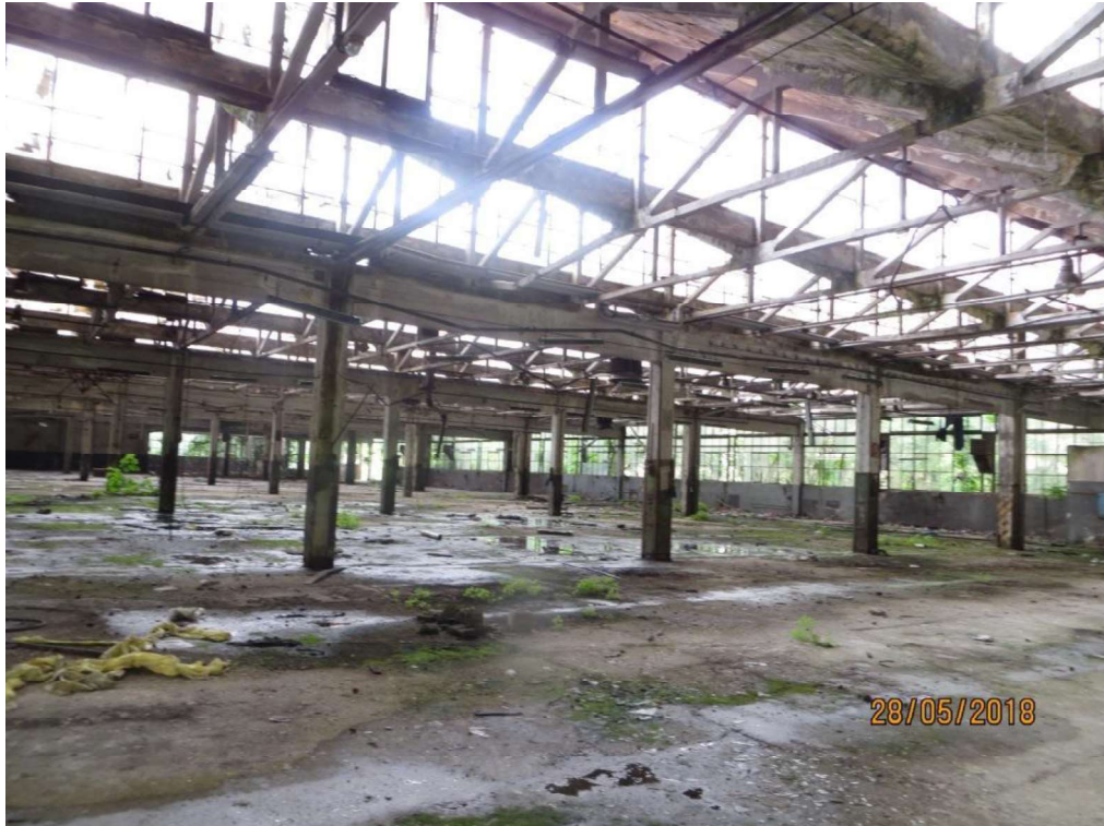
Foto 9 – Area "ex Fonderia" particolare degli interni
