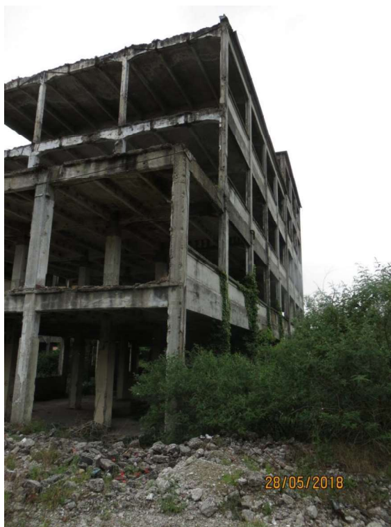
Foto 4 – "Lingottino" particolare della struttura portante
