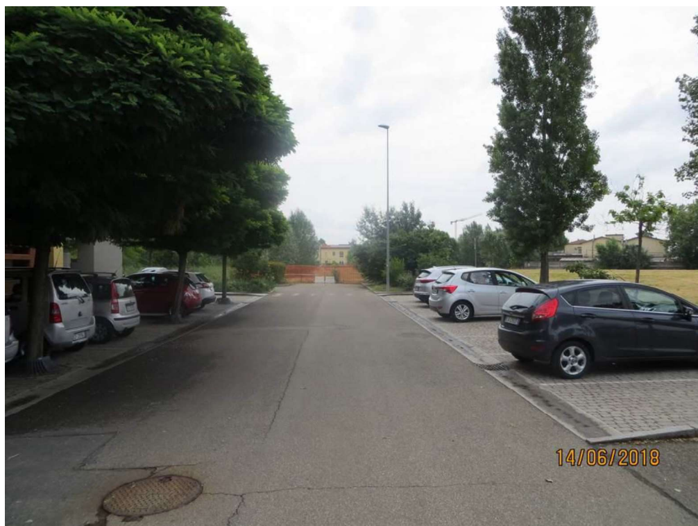
Foto 8 – Interruzione delle urbanizzazioni in via Boni (strada, i.p., parcheggi, verde)
