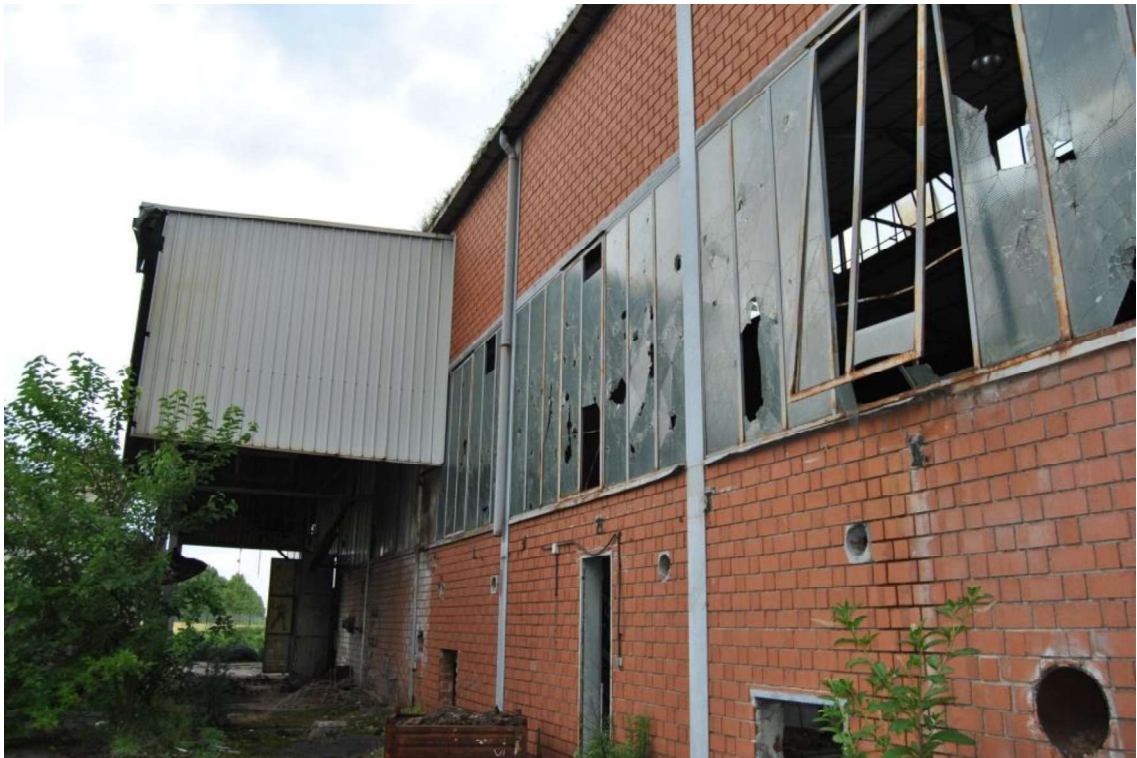
Foto 8 – Particolare del fabbricato dismesso su particella 85
