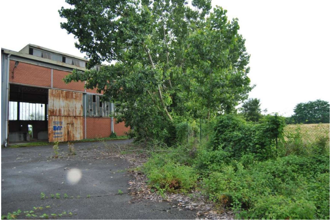
Foto 7 – Vista del fabbricato dismesso su particella 85 e particella 102
