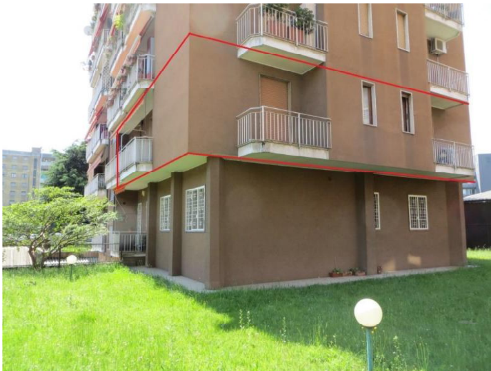
Foto 2 – Inquadramento, dal cortile interno, dell’immobile pignorato (lato Nord)
