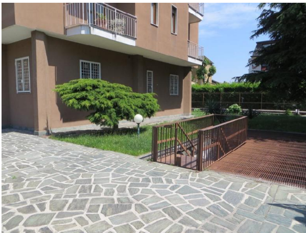
Foto 38 – Scala esterna di accesso al piano interrato
