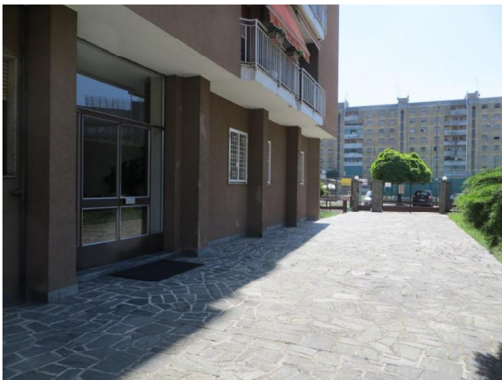
Foto 4 – Cortile condominiale antistante l’accesso al vano scala
