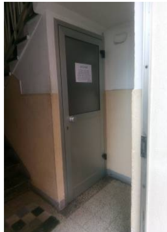
accesso condominiale alle cantine
