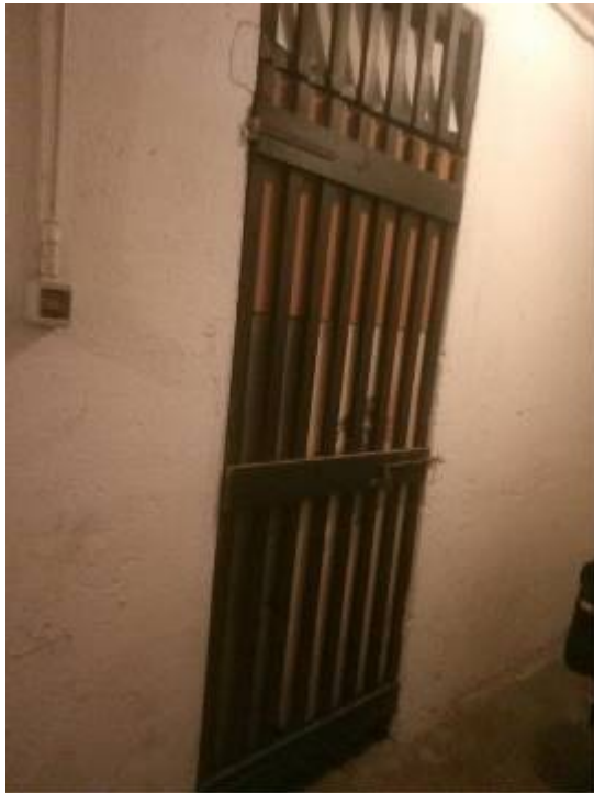
Porta di accesso alla cantina
