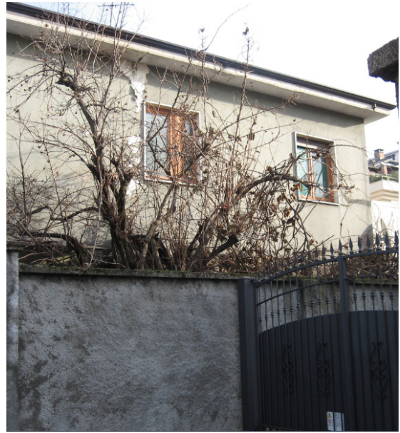
Foto 2: altra vista dell'edificio
