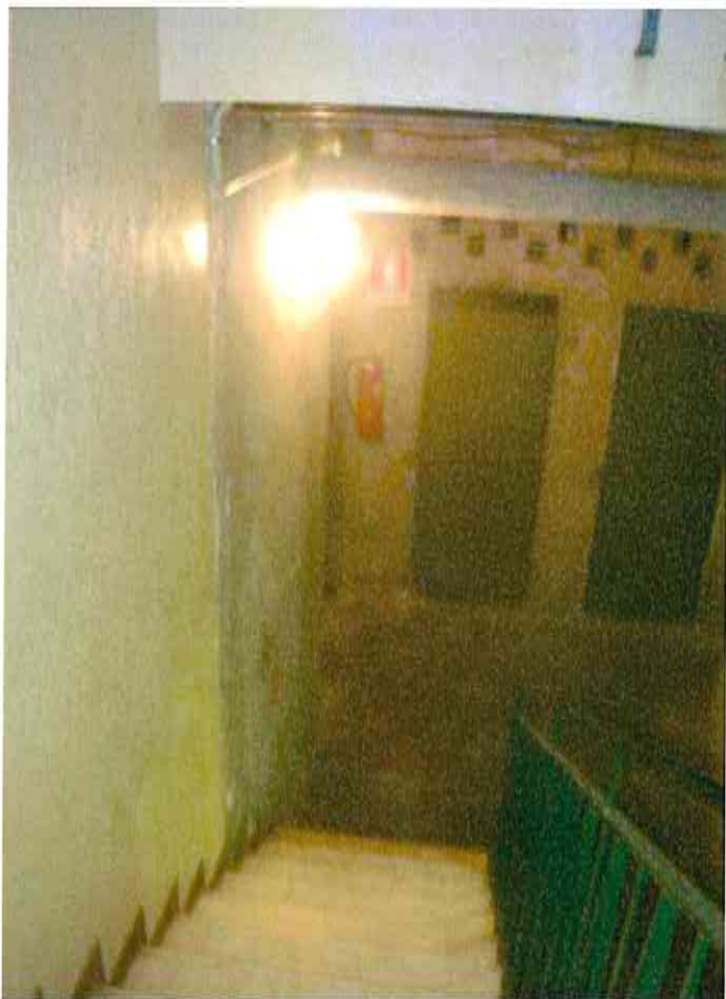
Scala che conduce al piano seminterrato
