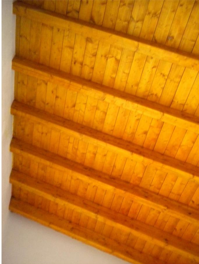
Foto 14 – Particolare copertura a vista con struttura portante in travi in legno lamellare
