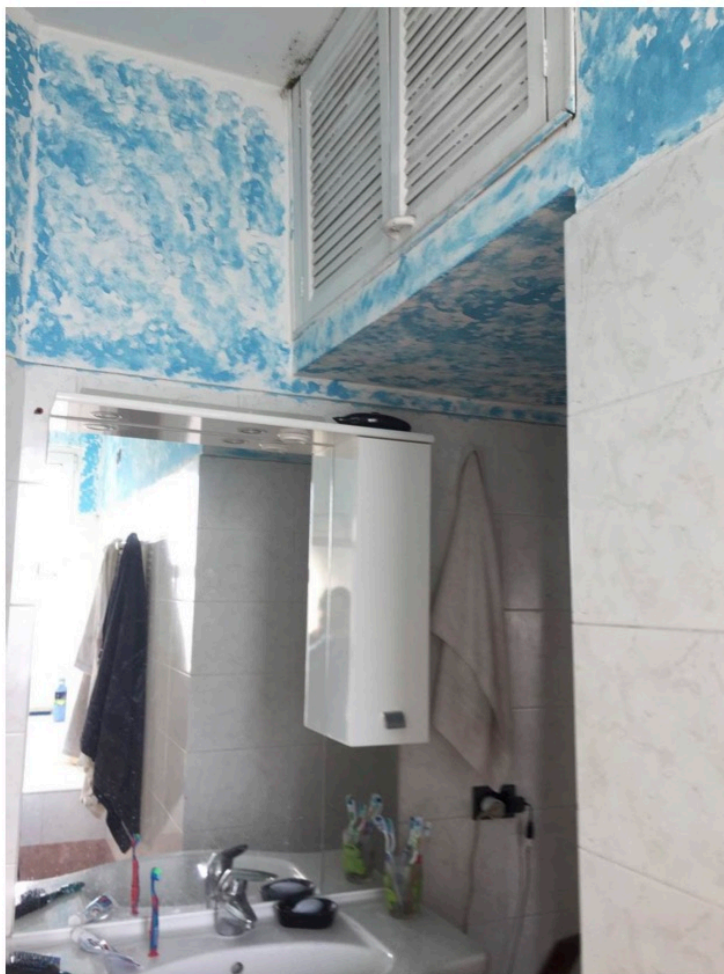
Fotografia n. 19 – Vista del locale bagno, ribassato ad altezza di ml. 2.20 sopra la porta di ingresso al locale, accessibile con doppio sportello apribile
