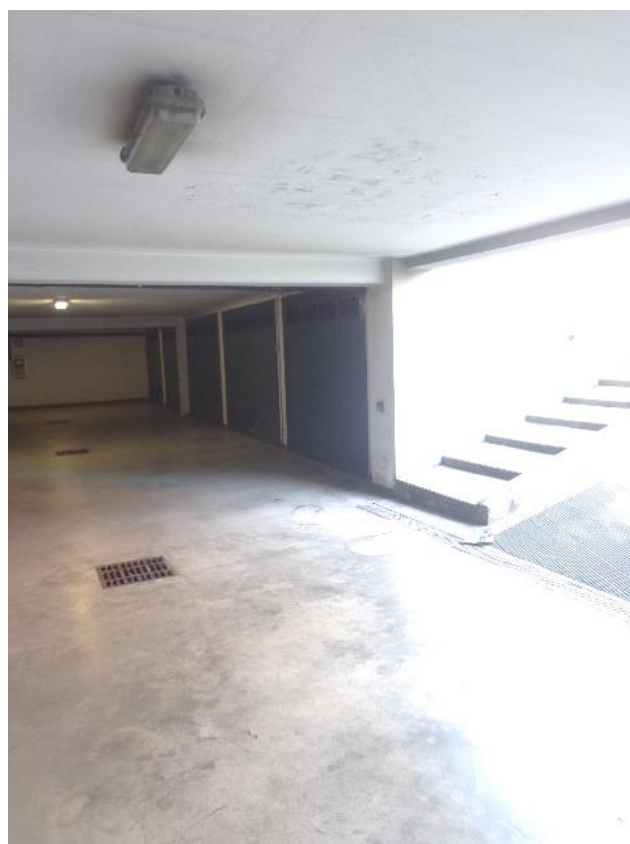
Particolari dell'locale box relativo all'unità immobiliare oggetto di perizia, munito di automazione e della rampa di accesso e uscita da via Figino.
