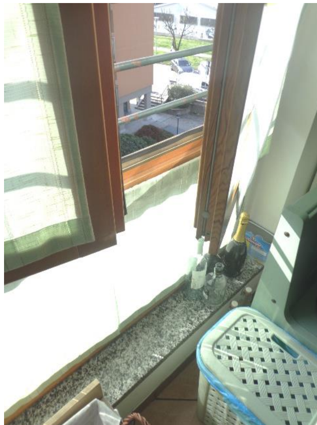
Particolari dell' accesso al locale giorno e all'angolo cottura; presenza d'infissi esterni lignei con doppi vetri, grate anti intrusione e di persiane a battente metalliche.
