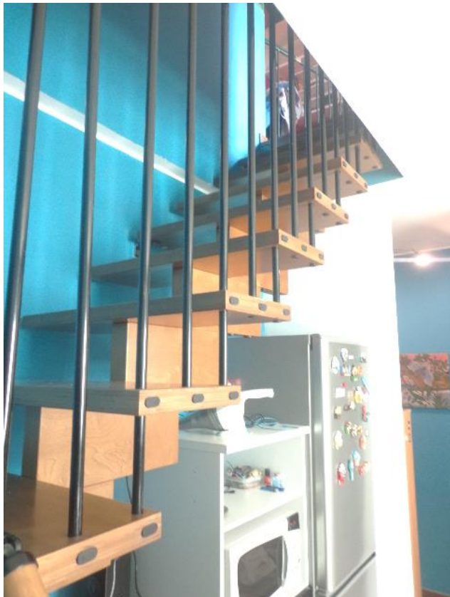
Particolari della scala interna atta all'accesso al locale sottotetto senza permanenza di persone; scala interna con struttura portante lignea.
