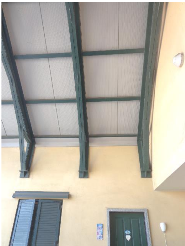
Particolari della struttura del tetto a due falde, realizzata in ferro zincato, dell'impianto ascensore e dell'accesso all'unità immobiliare oggetto di perizia al piano terzo.
