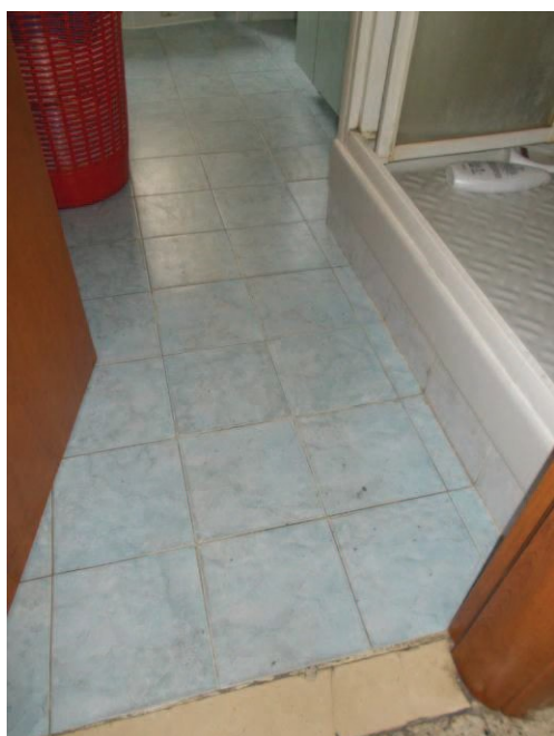
35. Pavimento del bagno
