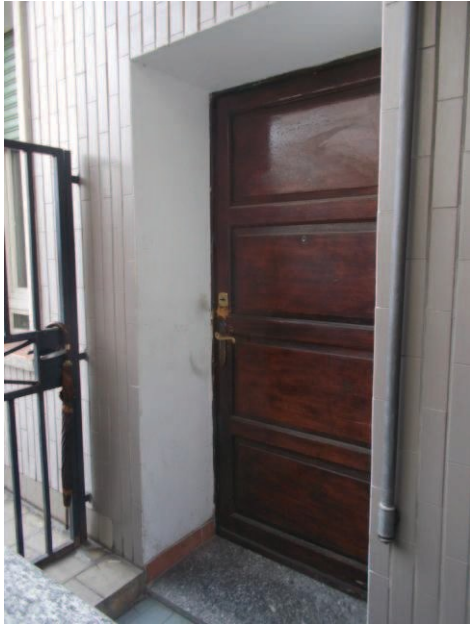
13. Portoncino di ingresso (dall'esterno)
