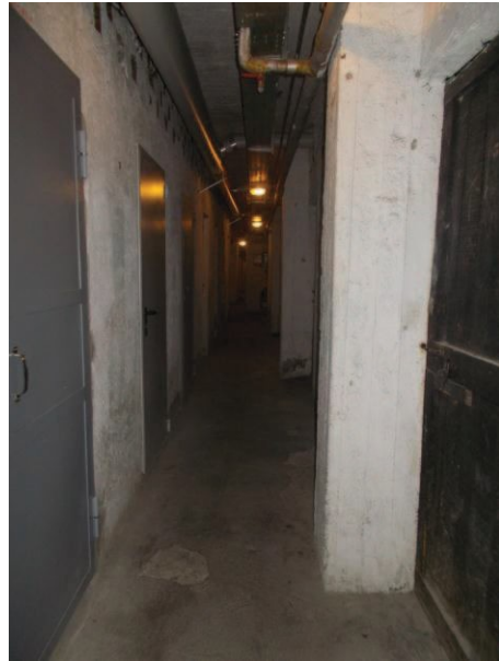
50. Corridoio comune delle cantine
