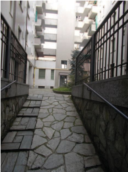
49. Rampa di accesso alle cantine
