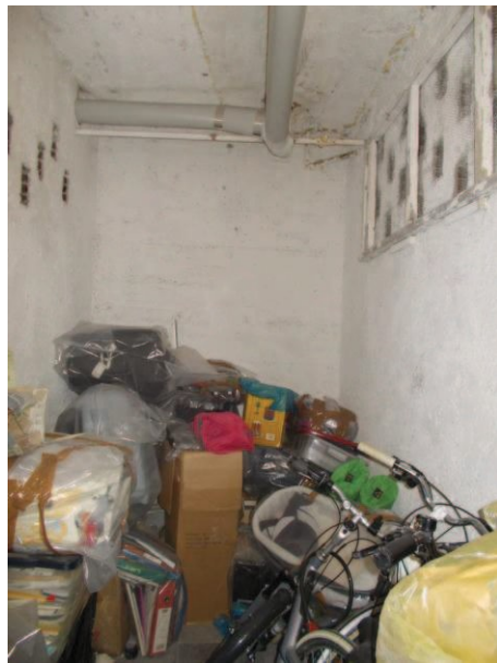
52. Interno della cantina
