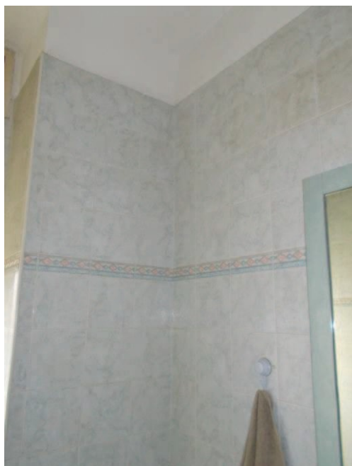
33. Dettaglio del rivestimento del bagno
