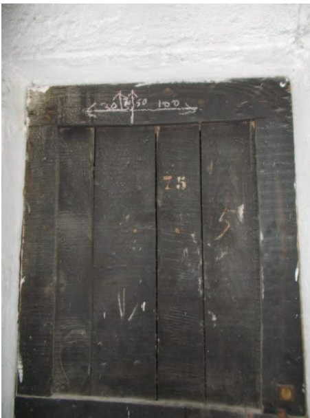
51. Ingresso alla cantina di pertinenza
