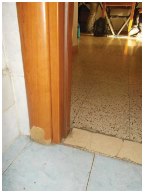
34. Dettaglio telaio della porta del bagno
