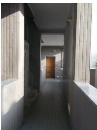
11. Ballatoio di arrivo della scala
