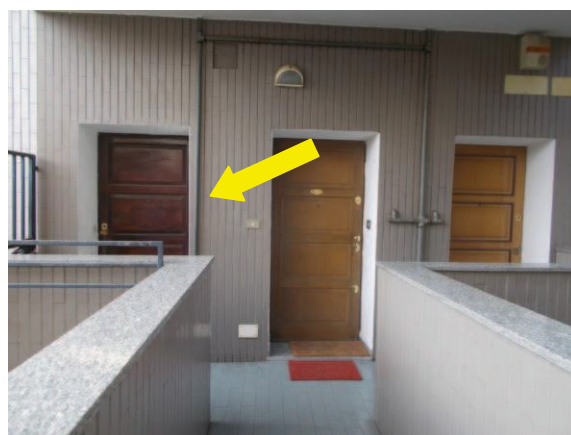
12. Ballatoio (con ingresso all'immobile)
