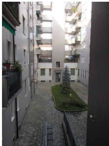
8. Panoramica del cortile interno
