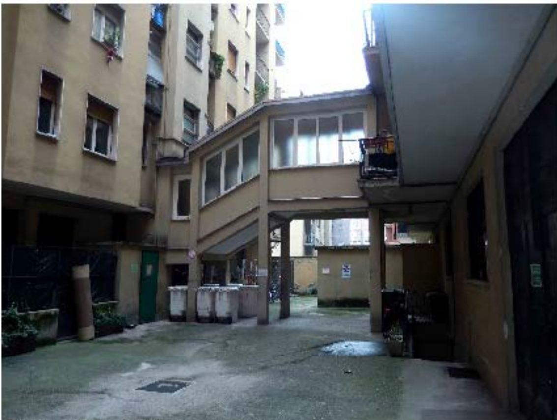
Foto 4 – Vista parziale del cortile sul retro.
