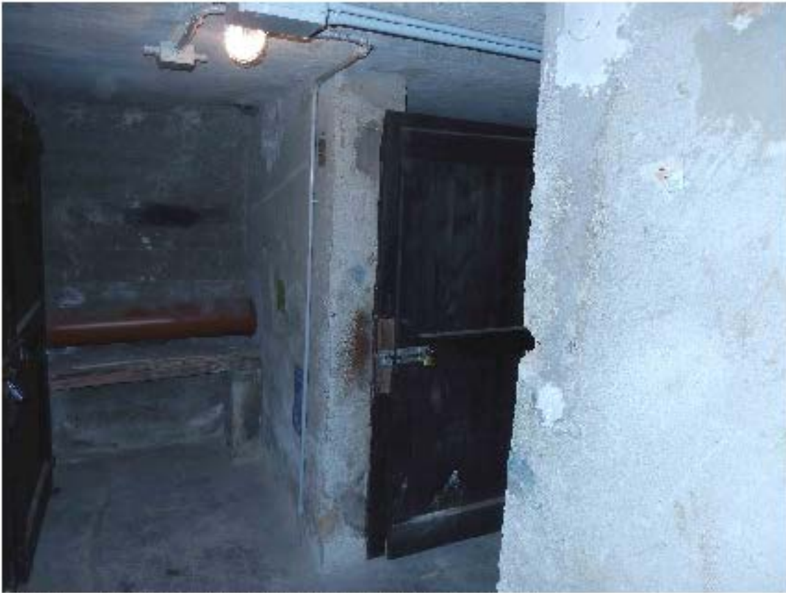
Foto 16 – Altra vista della cantina annessa all'appartamento.
