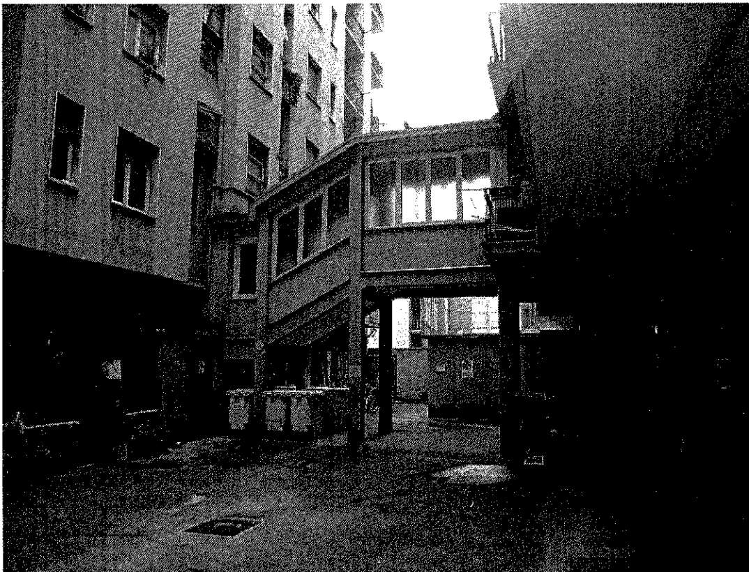
Foto 4 – Vista parziale del cortile sul retro.
