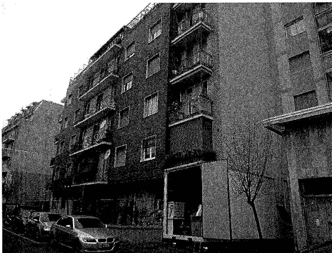
Foto 2 – Il prospetto principale su strada dell'edificio in esame.
