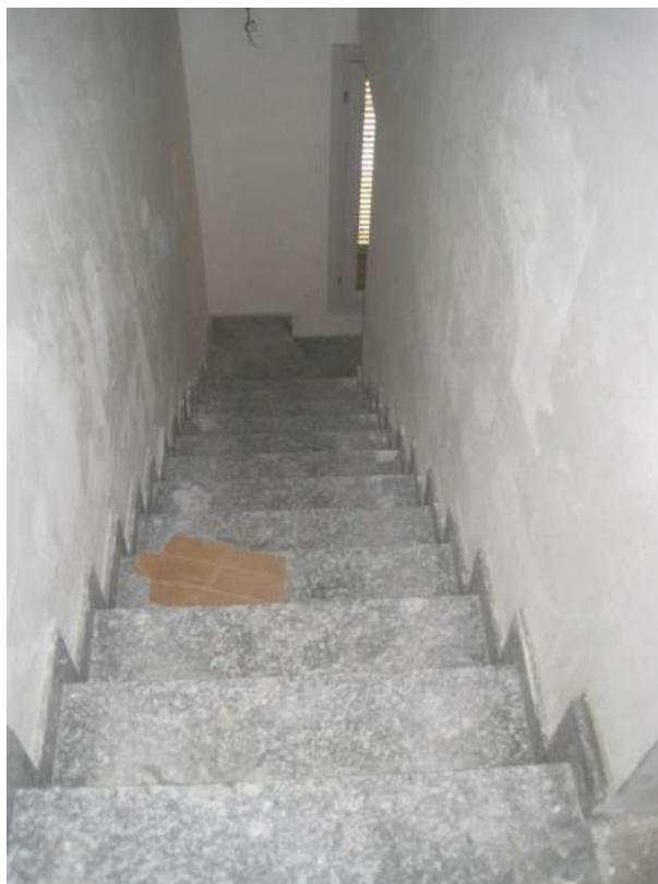
PIANO QUARTO – Appartamento n. 8
