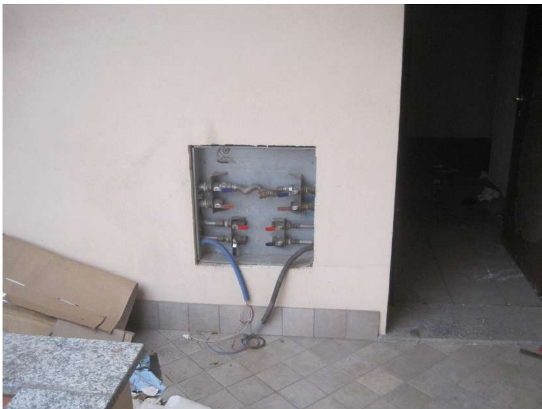
PIANO SECONDO – Appartamento n. 7
