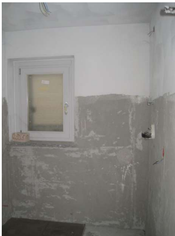
PIANO QUARTO – Appartamento n. 8
