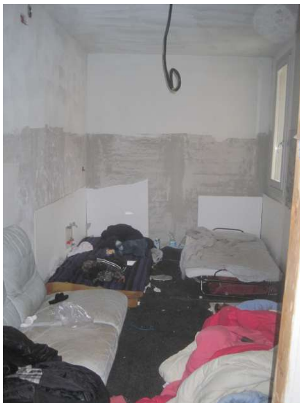
PIANO SECONDO – Appartamento n. 6
