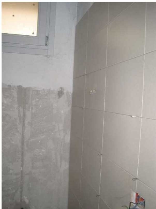
PIANO SECONDO – Appartamento n. 6
