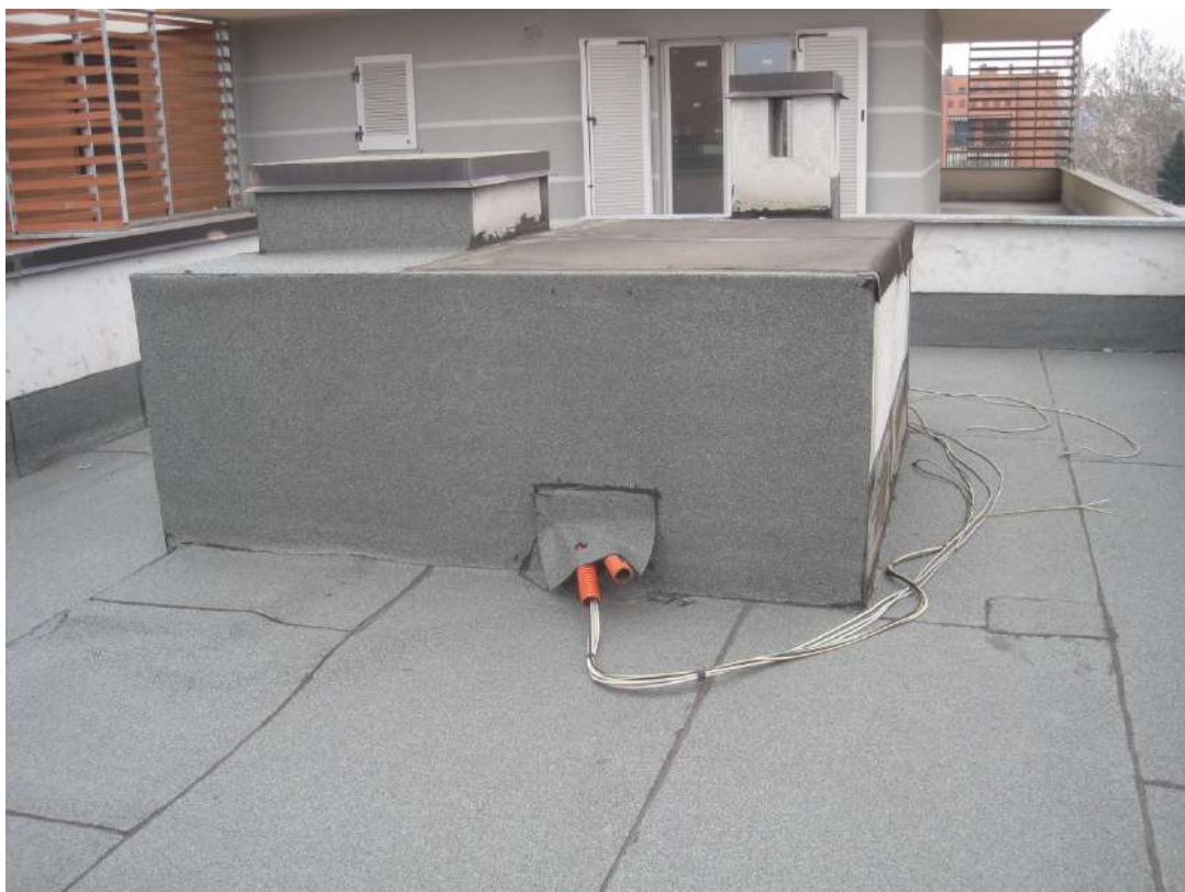
PIANO QUARTO – Lastrico Solare
