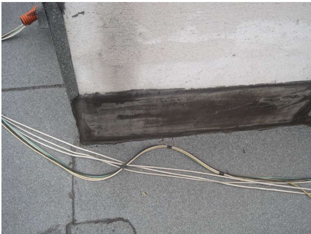
PIANO QUARTO – Lastrico Solare
