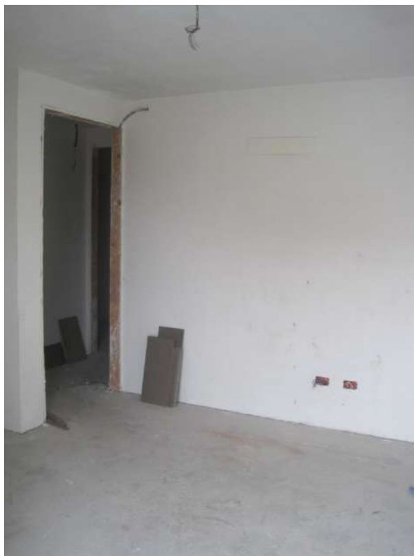
PIANO QUARTO – Appartamento n. 8
