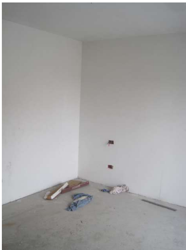
PIANO QUARTO – Appartamento n. 8
