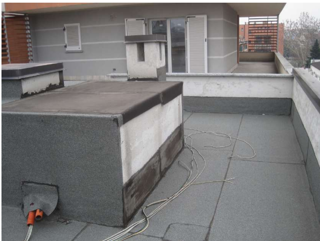
PIANO QUARTO – Lastrico Solare
