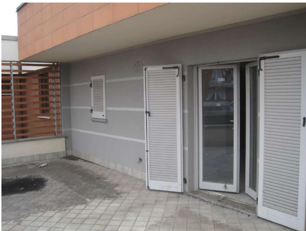
PIANO QUARTO – Appartamento n. 8
