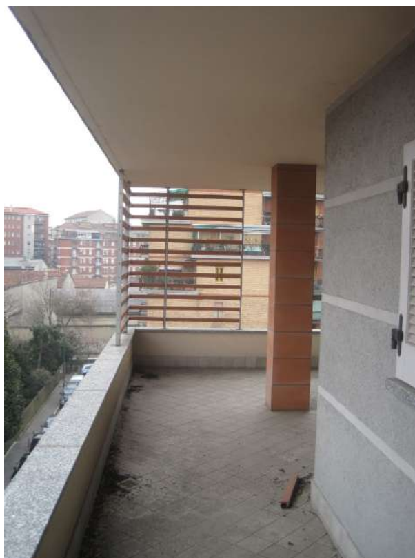
PIANO QUARTO – Appartamento n. 8
