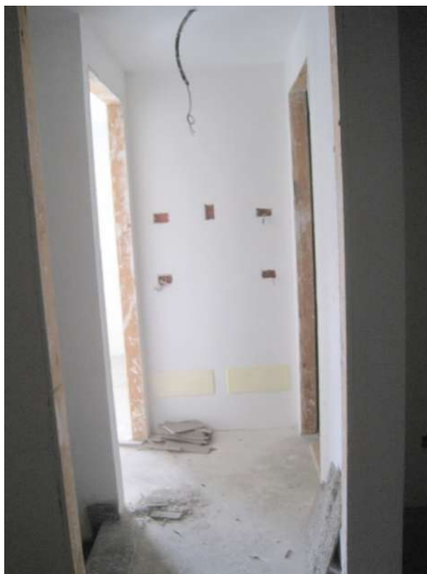
PIANO QUARTO – Appartamento n. 8
