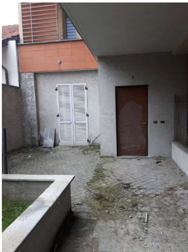
PIANO TERRA – Sala Riunioni
