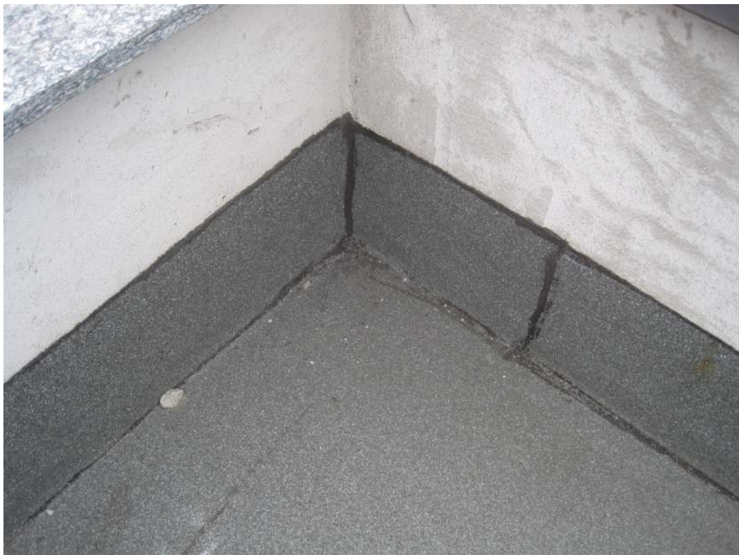
PIANO QUARTO – Lastrico Solare
