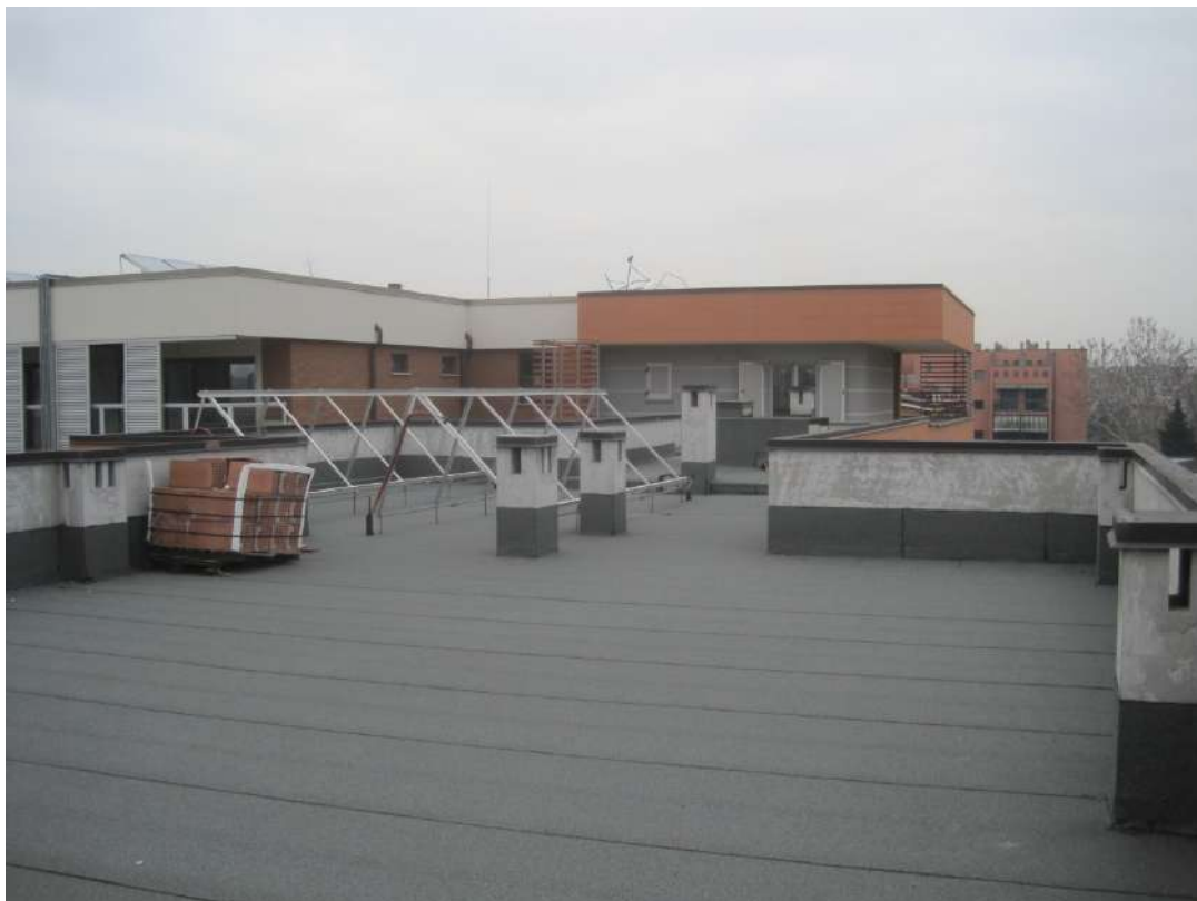
PIANO QUARTO – Lastrico Solare
