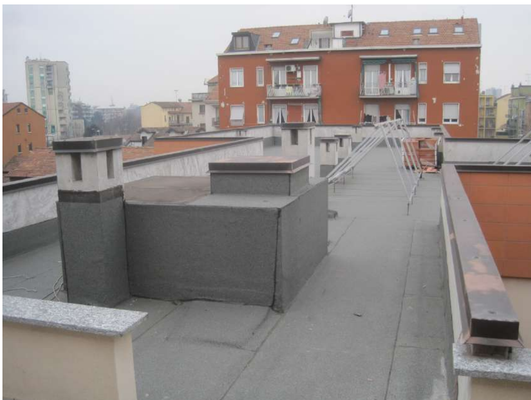
PIANO QUARTO – Lastrico Solare
