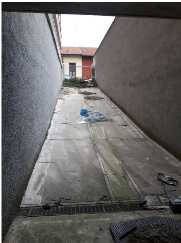
PIANO INTERRATO – Autorimessa
