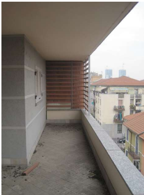
PIANO QUARTO – Appartamento n. 8
