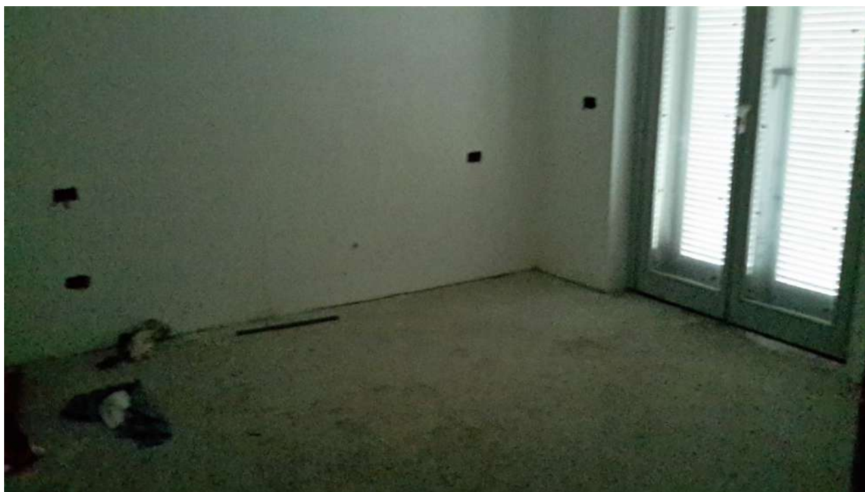
PIANO QUARTO – Appartamento n. 8
