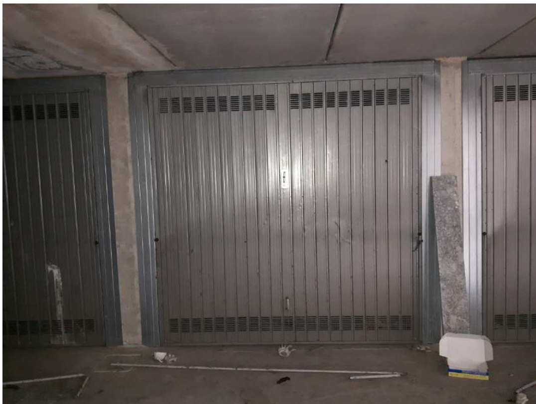
PIANO INTERRATO – Autorimessa
