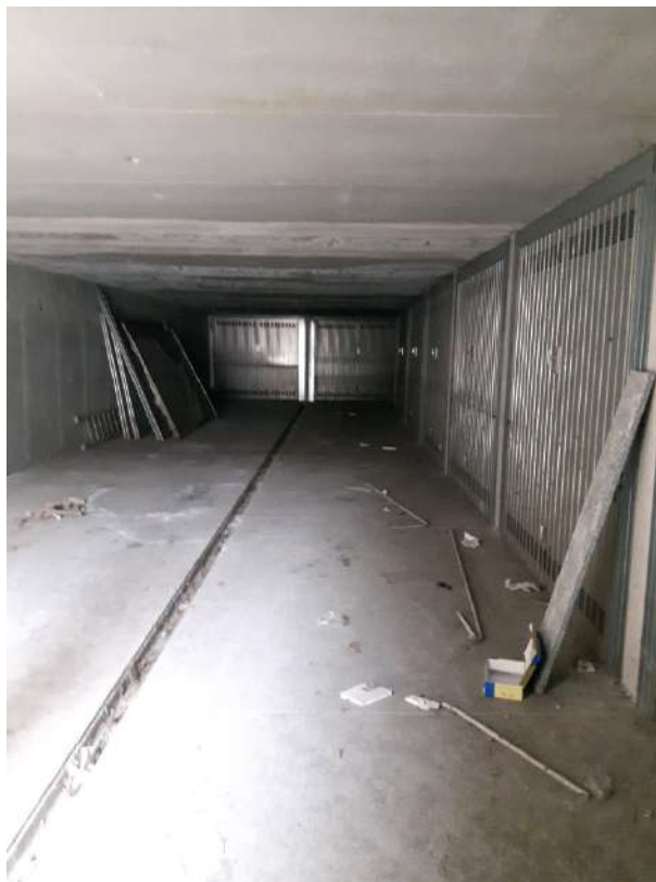
PIANO INTERRATO – Autorimessa
