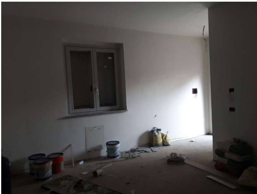
PIANO TERRA – Sala Riunioni
