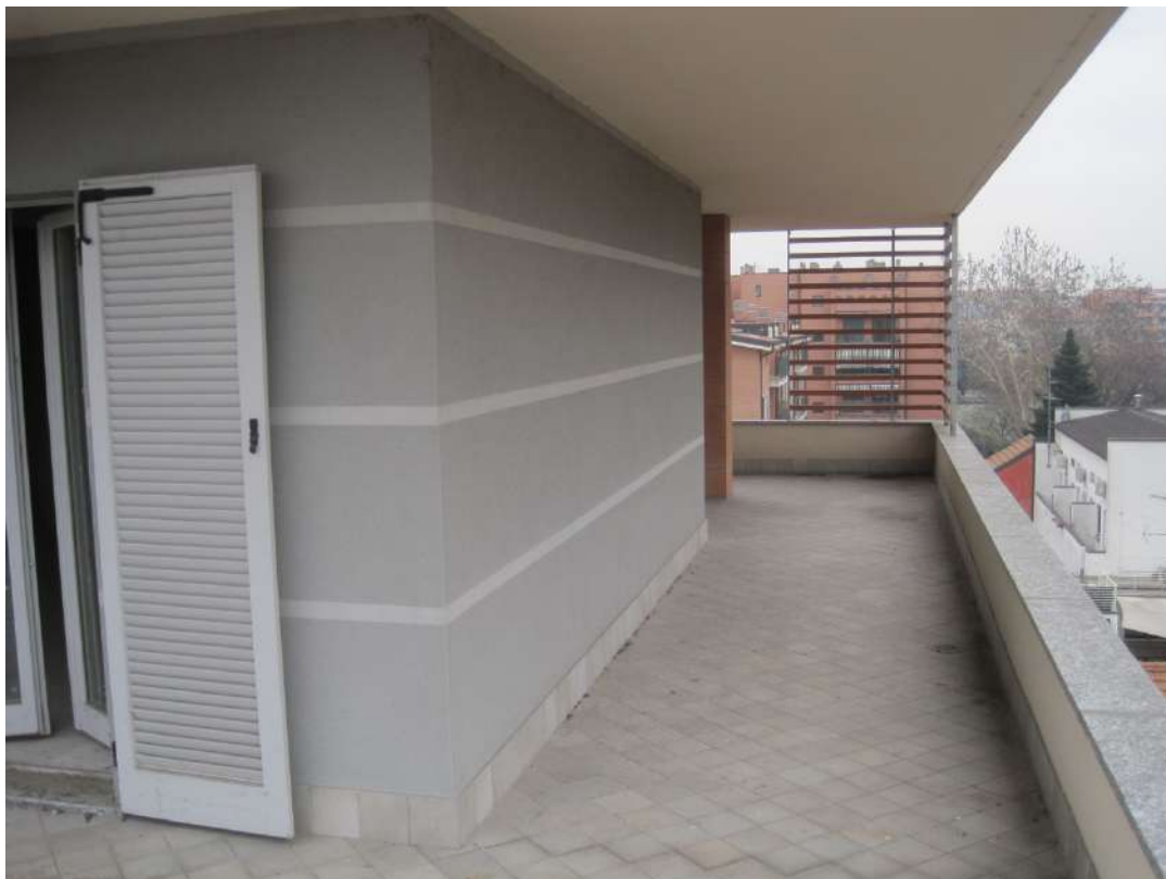
PIANO QUARTO – Appartamento n. 8
