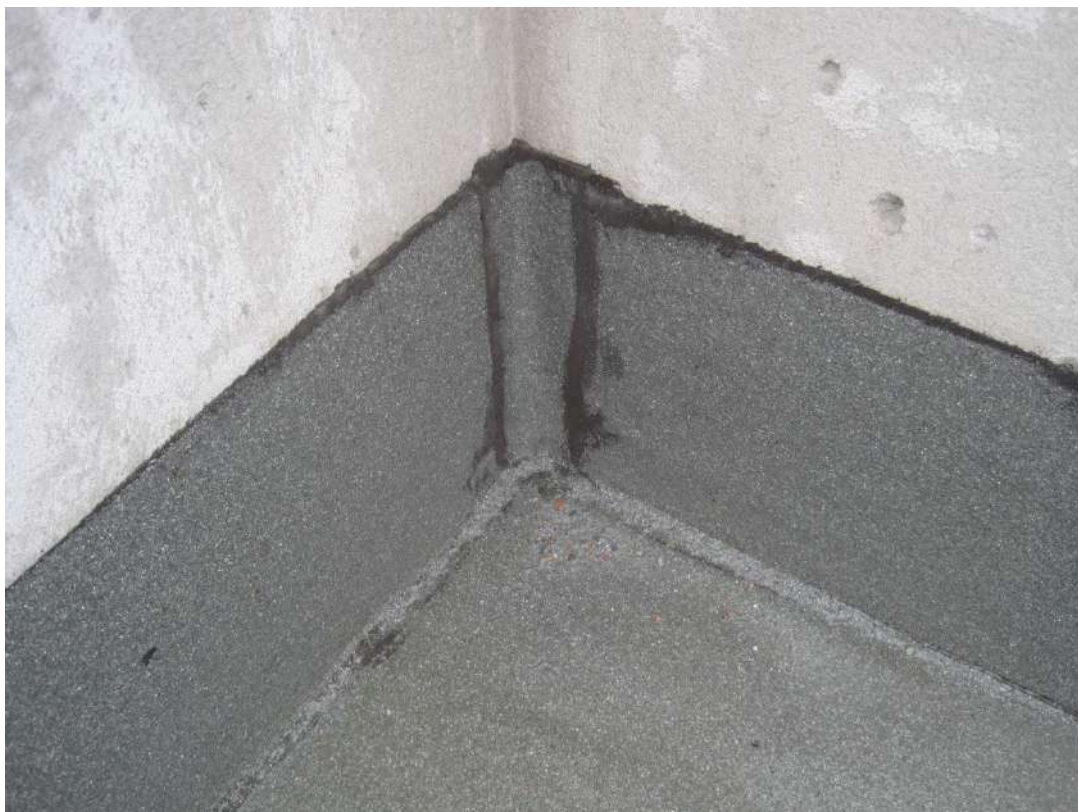
PIANO QUARTO – Lastrico Solare
