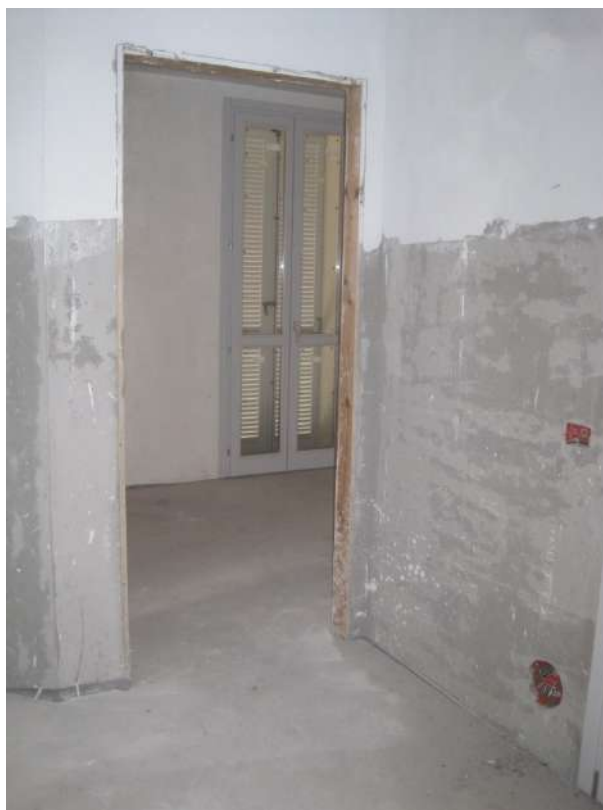
PIANO SECONDO – Appartamento n. 5
