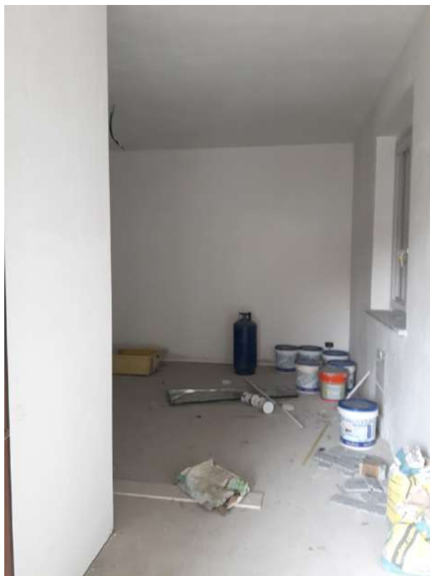
PIANO TERRA – Sala Riunioni
