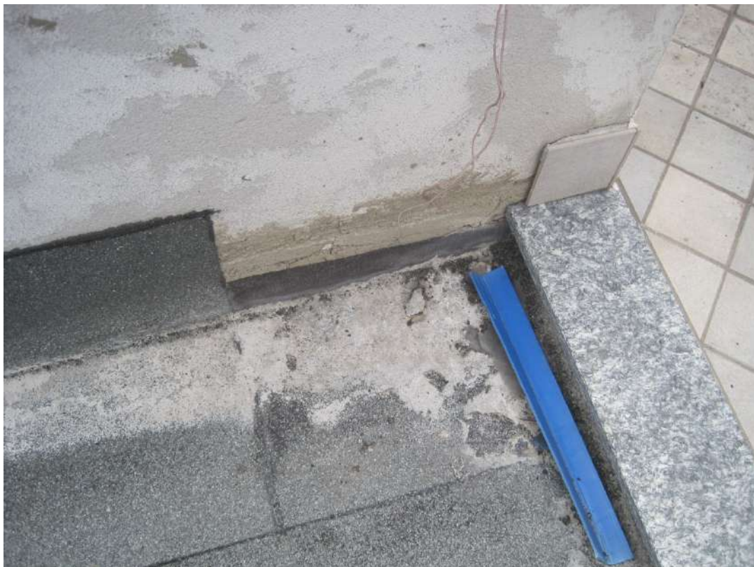
PIANO QUARTO – Lastrico Solare
