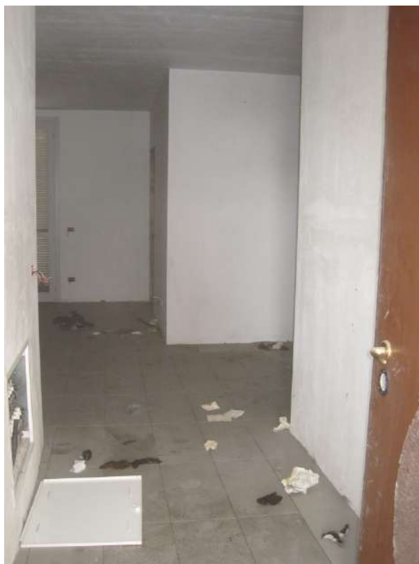
PIANO SECONDO – Appartamento n. 7
