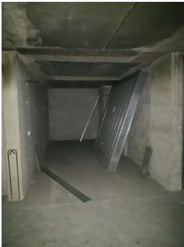
PIANO INTERRATO – Autorimessa
