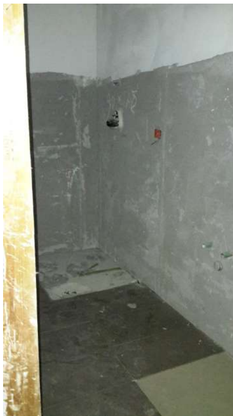
PIANO QUARTO – Appartamento n. 8
