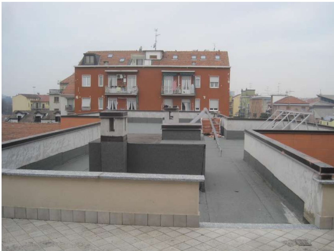
PIANO QUARTO – Lastrico Solare
