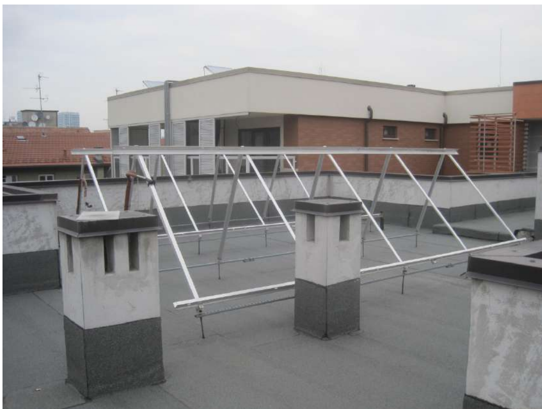
PIANO QUARTO – Lastrico Solare
