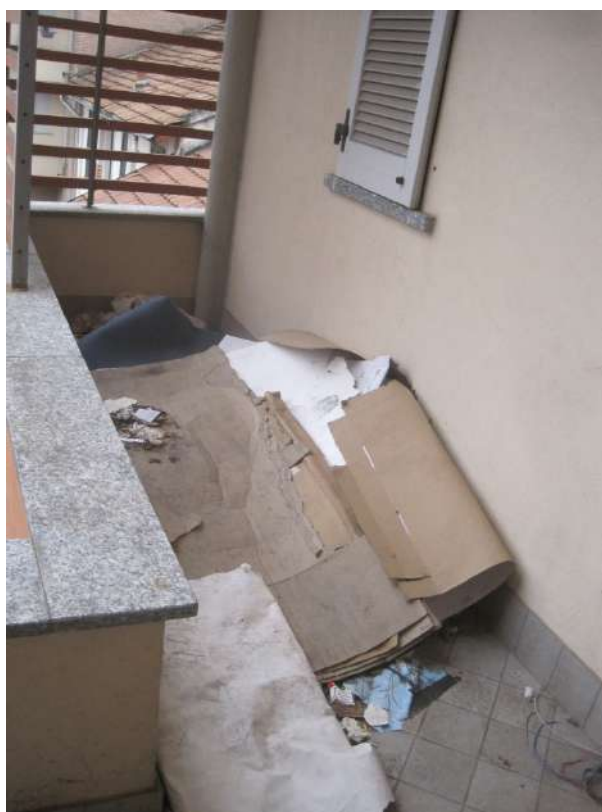
PIANO SECONDO – Appartamento n. 7
