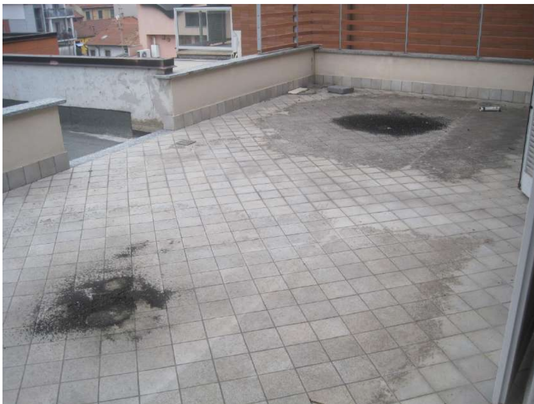
PIANO QUARTO – Appartamento n. 8
