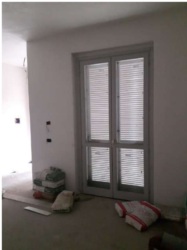
PIANO TERRA – Sala Riunioni
