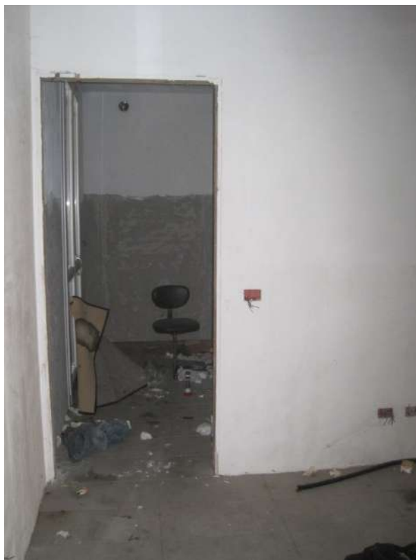
PIANO SECONDO – Appartamento n. 7
