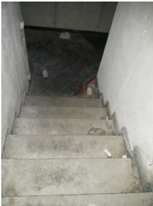
PIANO INTERRATO – Locali Tecnici
