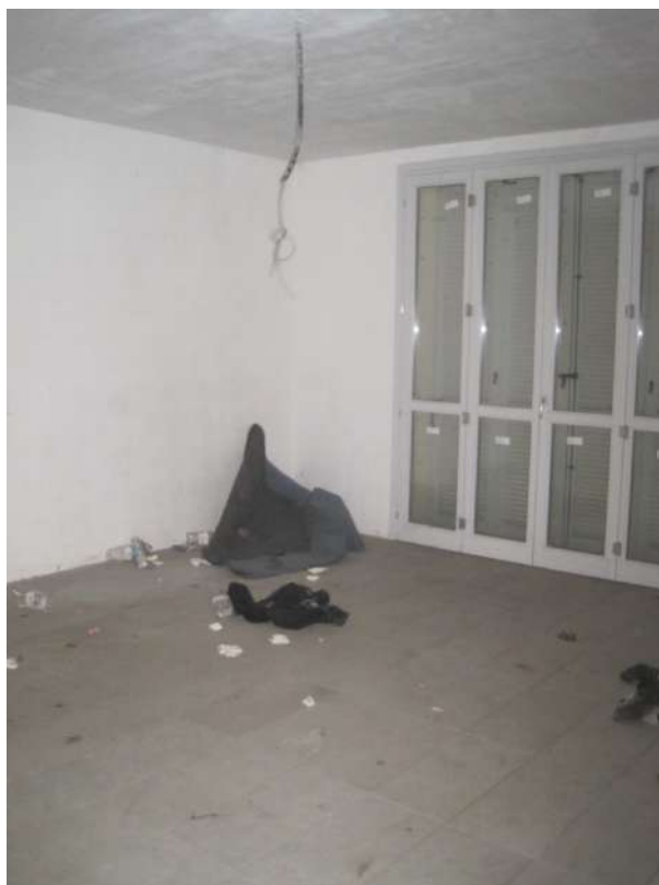
PIANO SECONDO – Appartamento n. 7
