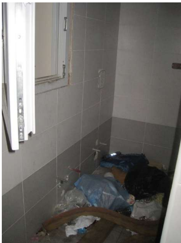
PIANO SECONDO – Appartamento n. 7
