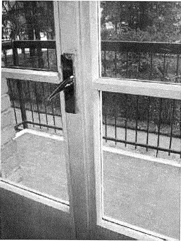
particolare serramenti esterni
