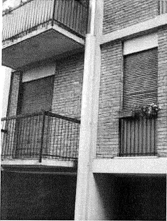
affaccio esterno appartamento
