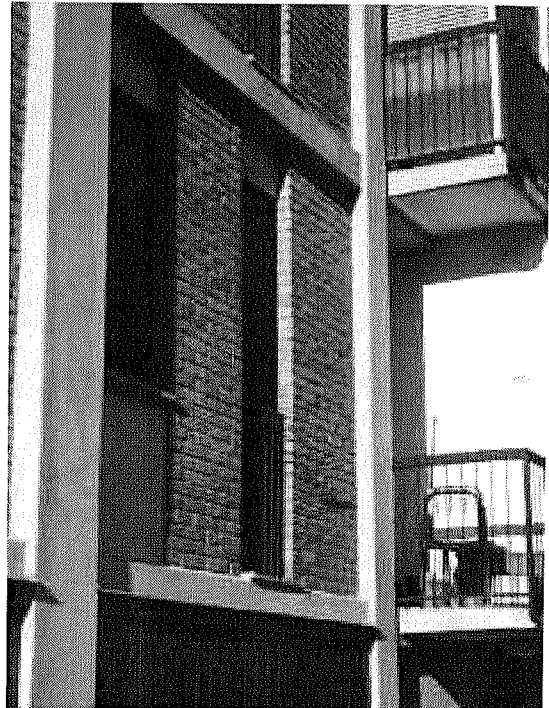
affaccio esterno appartamento
