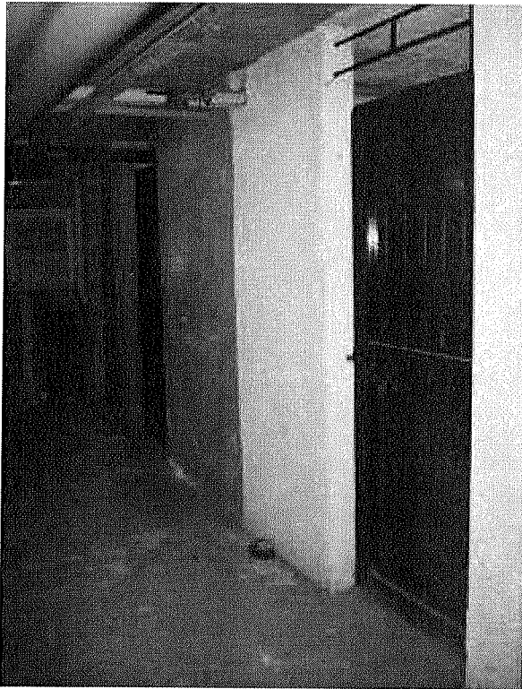
particolare porta ing. cantina di pertinenza
