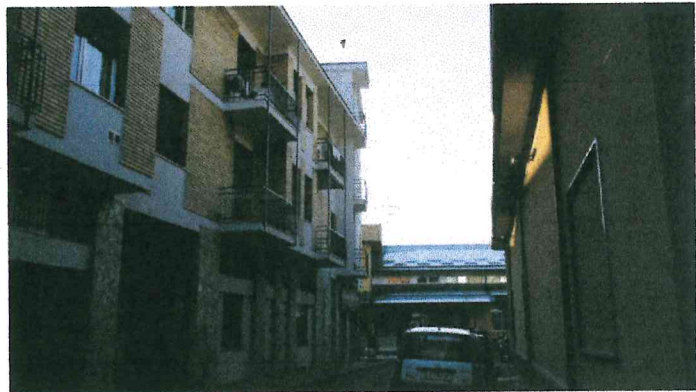
Facciata di ingresso principale- edificio su strada
