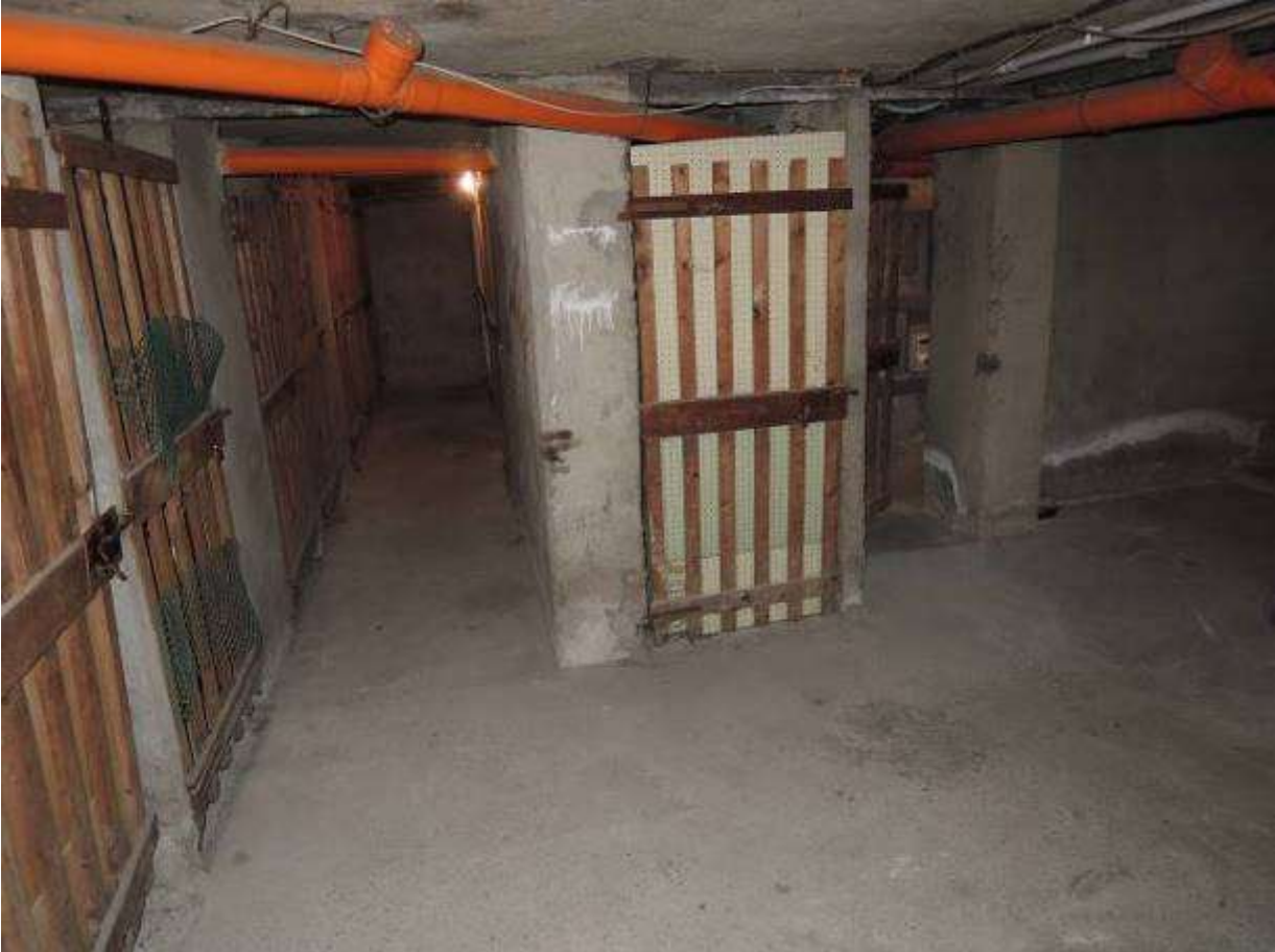
Corridoio comune di accesso alle cantine, vista verso Sud
