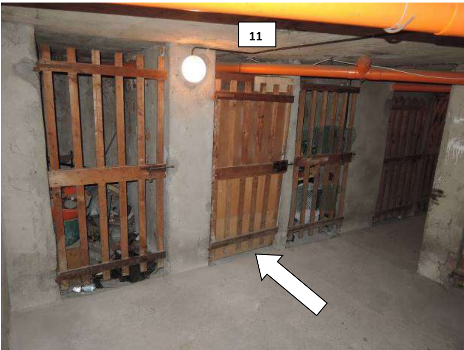
Fianco Est del corridoio comune verso Sud
