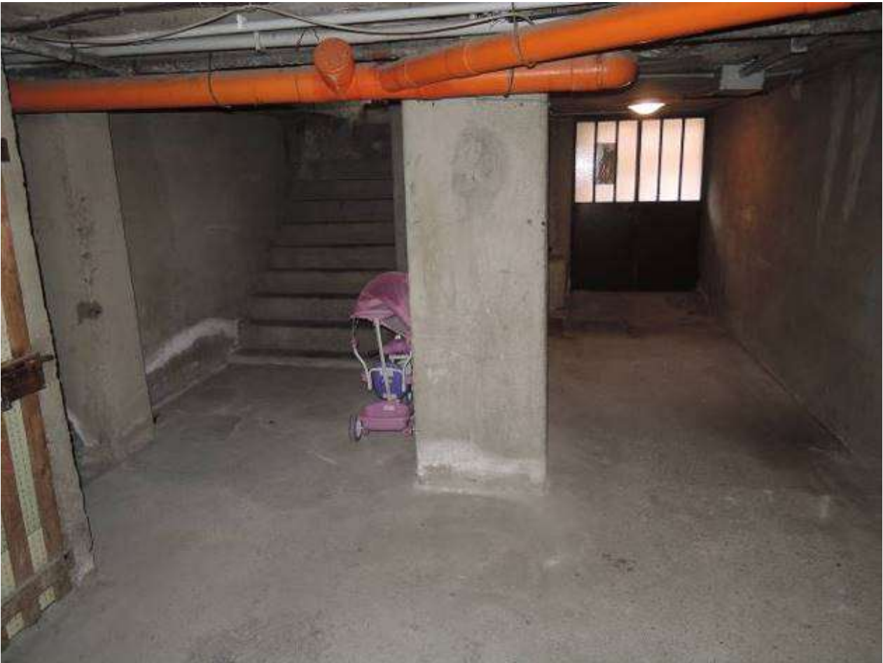
Corridoio comune di accesso alle cantine, vista verso Ovest
