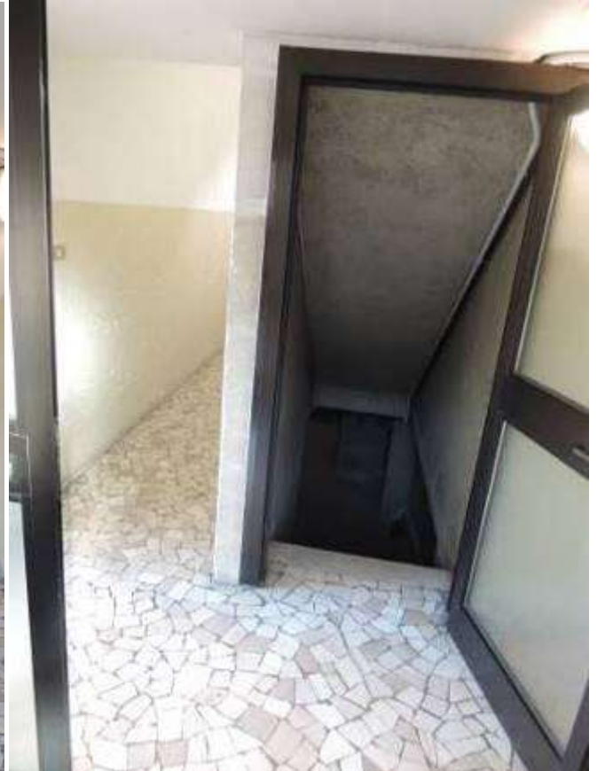
Porta di accesso al piano cantinato
