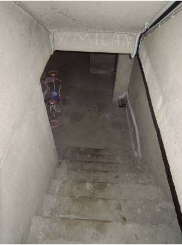
Rampa di accesso al piano cantinato
