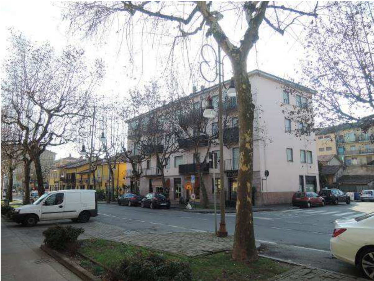
Pessano con Bornago fabbricato condominiale visto dal Viale Piave
