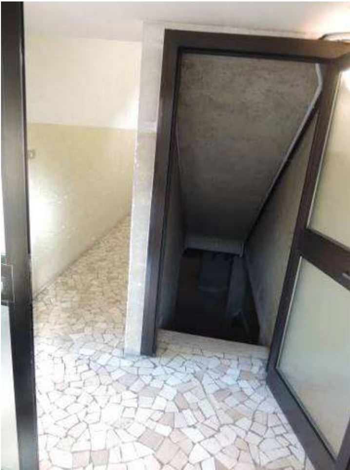
Accesso al piano cantinato
