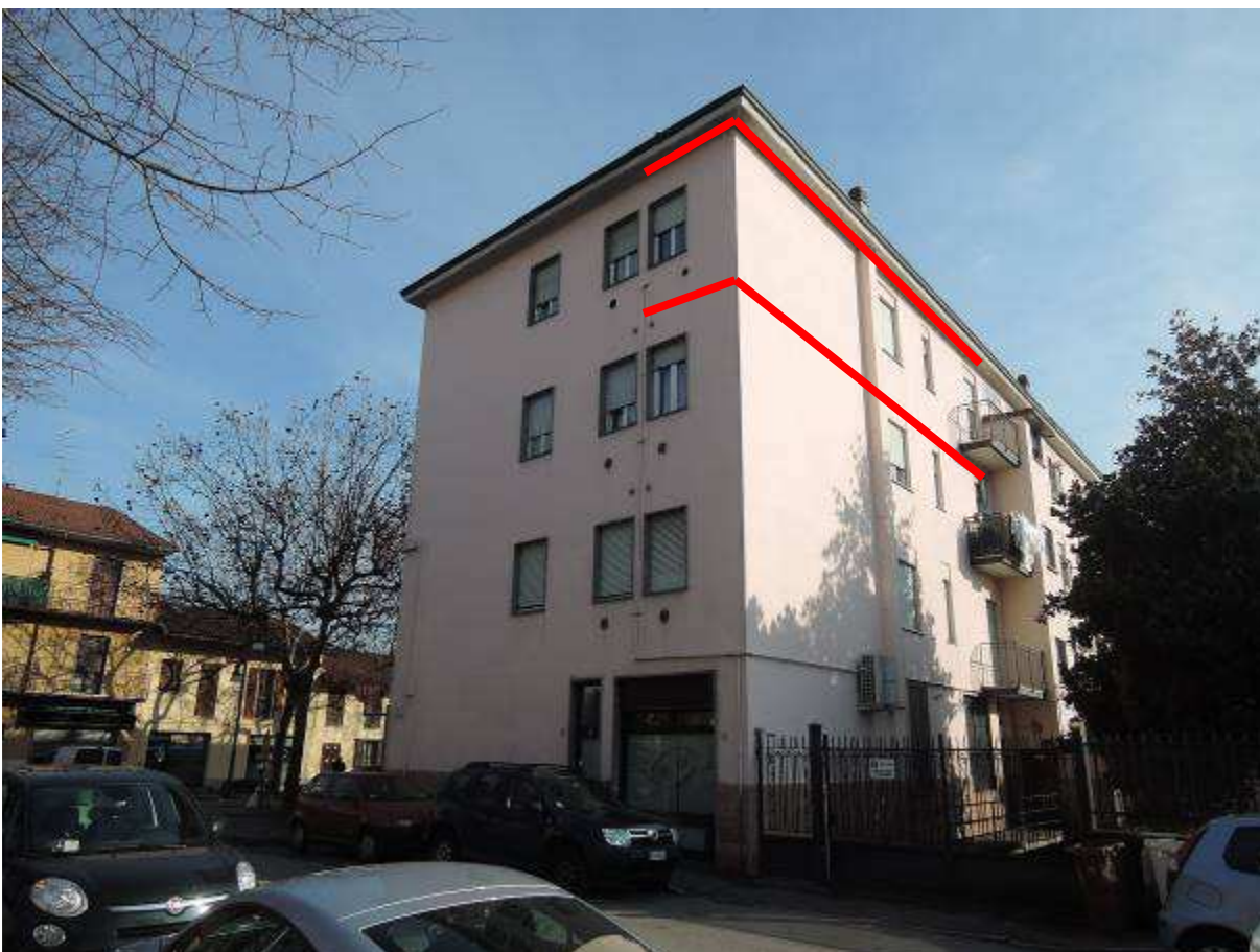
Pessano con Bornago fabbricato condominiale visto dalla via Montenero – individuazione unità
