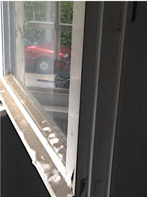
Foto: 09, dettaglio finestra
