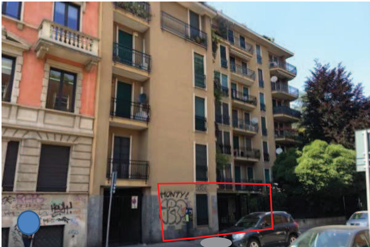
Vista fabbricato da Via Paolo Bassi
