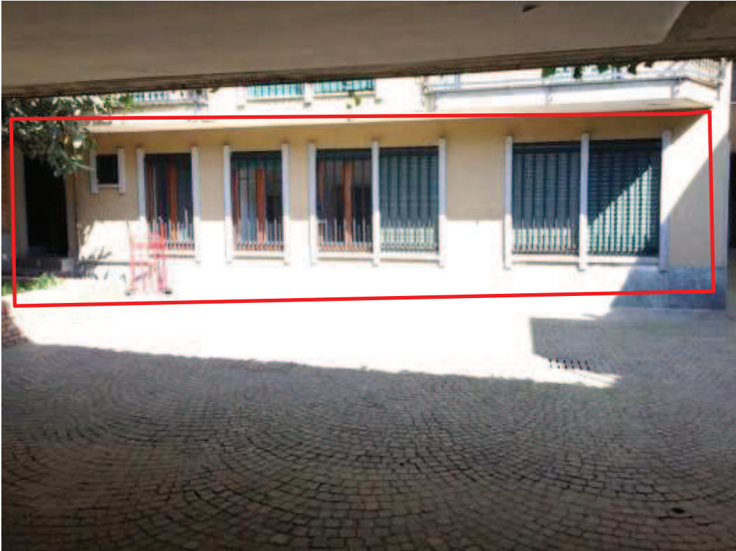
Vista unità lato cortile interno
